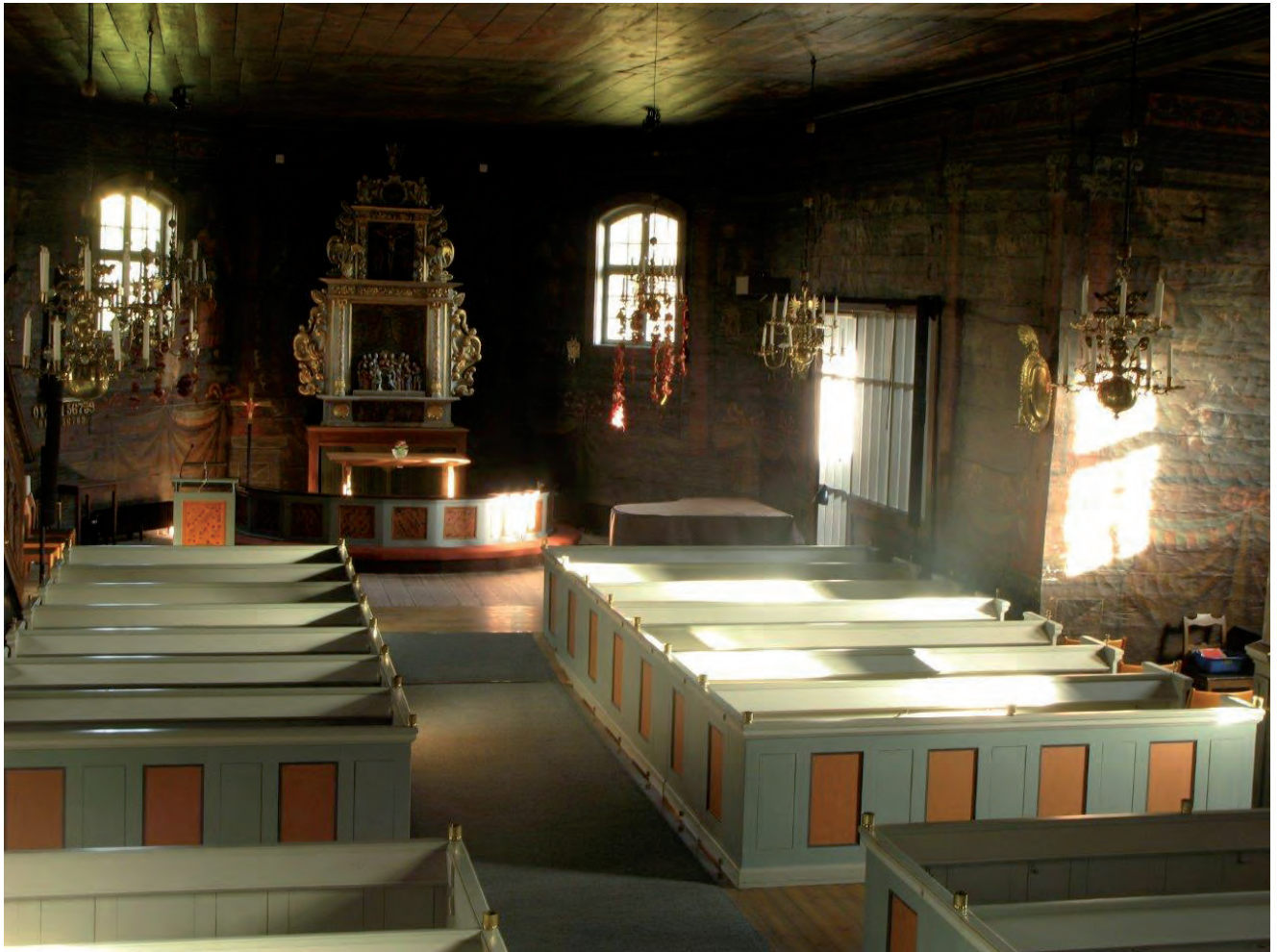
Vy mot koret 2013 efter avslutade byggnadsarbeten. 1880-talets skurgolv framtaget och kompletterat, ramp byggd i mittgången, nytt flyttbart altare och sektionerad altarring, ny högtalaranläggning.
