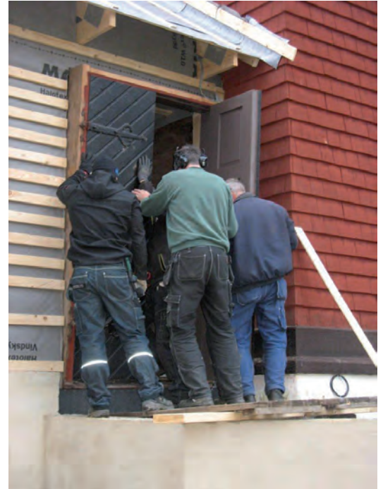
Gamla porten kommer på plats i nybygget.
