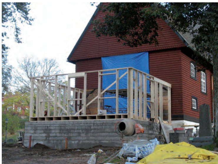
Sockel och stomme till nya vapenhuset.
