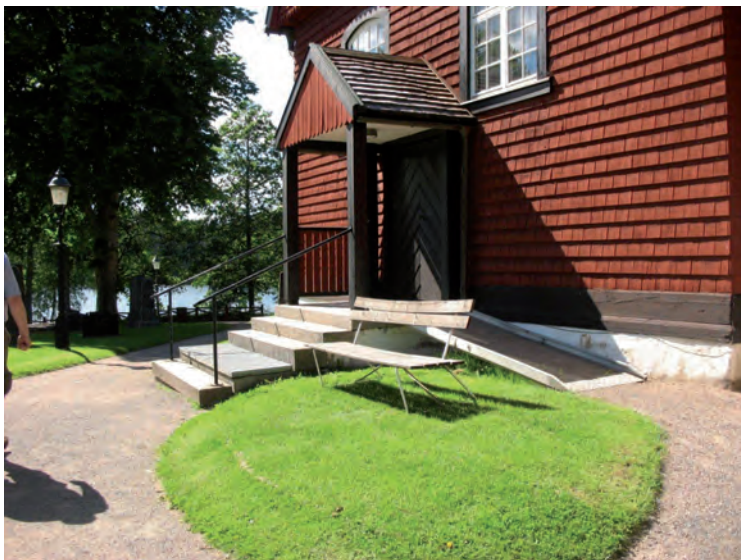
Södra ingången med tillfällig ståldurksramp. Eftersom dörrbladen går utåt kolleder dessa med rampen.
