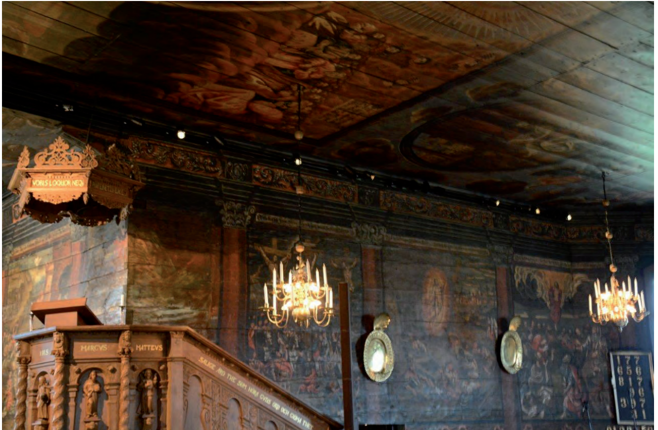
Längs taklist på kyrkorummets långsidor har skenor med svarta strålkastare monterats. Ny manöverpulpit har byggts.
