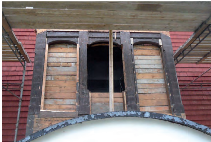
Vid rivningen av 1932 års vindfång visade det sig att stommen utgjordes av 1880-talets uppbyggnad för skärmtak (se sid. 30). Foto: Ulf Tinnis.
