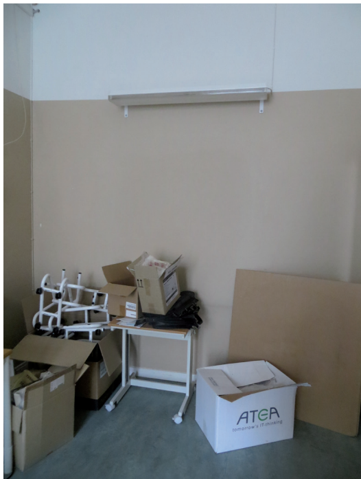
Väggen i rum 121C mot korridoren innan dörrhålet återupptogs.
