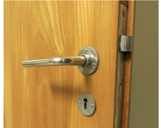
Ovan: Dörrblad och trycke från 1950 återanvändes. Till vänster: Pågående arbete när dörrarna monterats. Foto: G. Gustafsson, Tengbom. Nedan: Fönstersmygen med bevarade gångjärn för fönsterluckorna.
