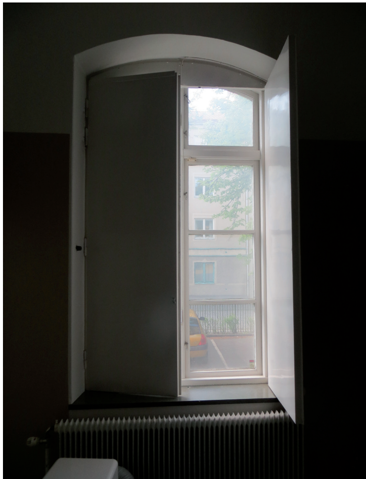
Fönstret i rum 121C inför ombyggnaden. Här syns fönsterluckorna och den fasta skyddsplåten överst.
