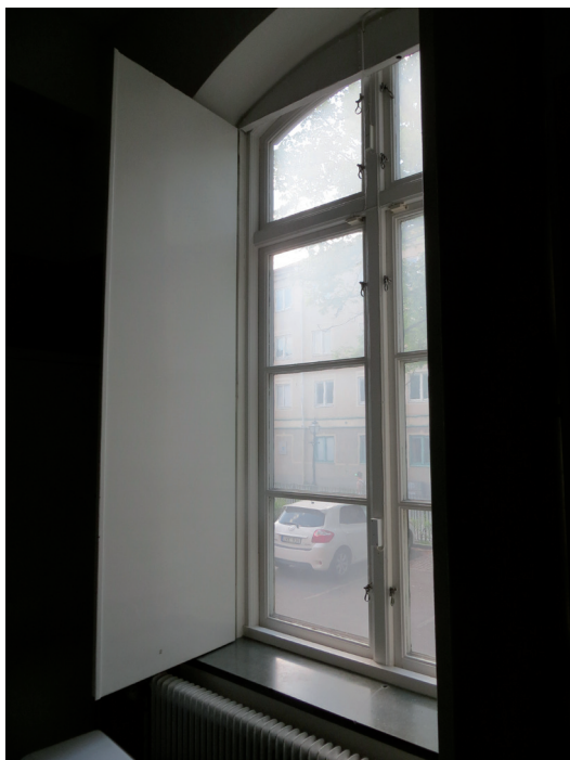
Fönstret i rum 121C inför ombyggnaden.
