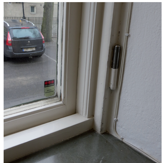
Ovan: Dörrblad och trycke från 1950 återanvändes. Till vänster: Pågående arbete när dörrarna monterats. Foto: G. Gustafsson, Tengbom. Nedan: Fönstersmygen med bevarade gångjärn för fönsterluckorna.
