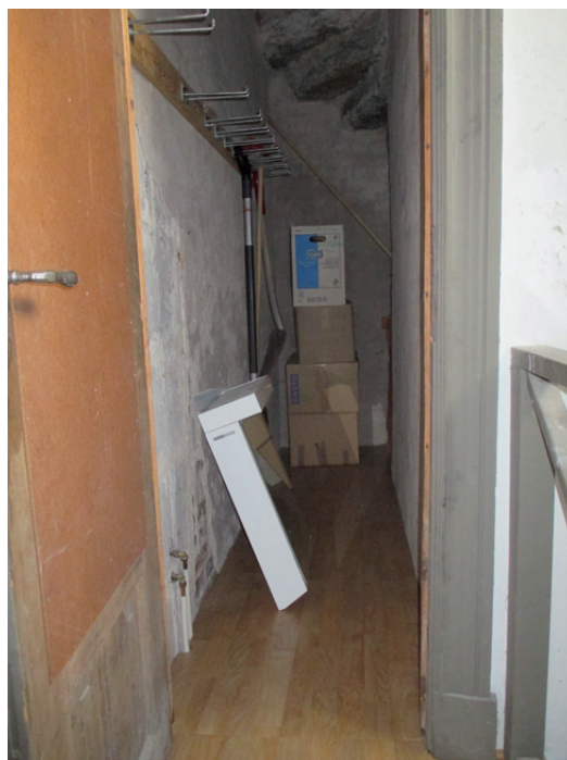
Skrubben under trappan upp til tornet golvades i anslutning till de andra snickeriarbetena.
