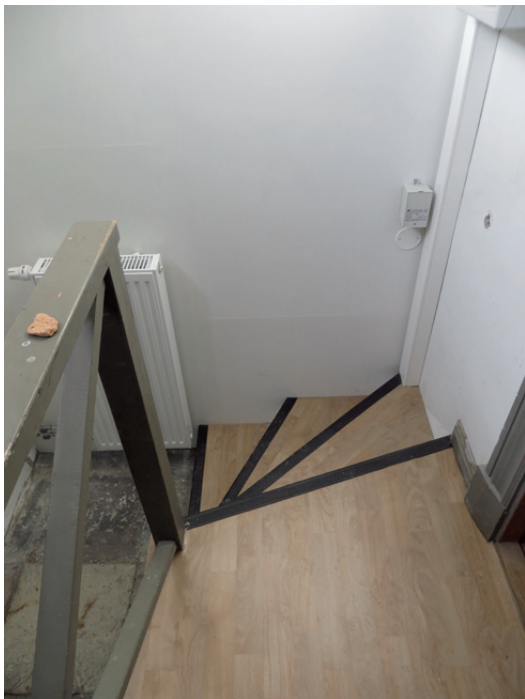
Trapphuset och den ombyggda trappan.
