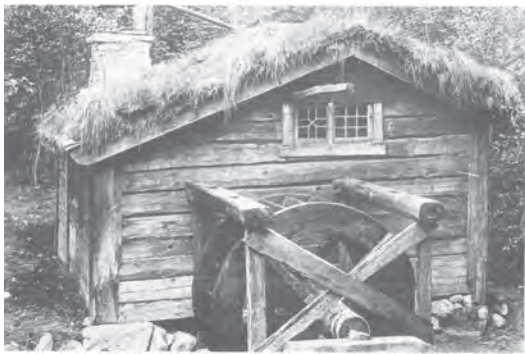
Tråddrageriet som skänktes av Gnosjöbor och består av tre kubbar, som drivs av ett vattenhjul. Här förvaras verktyg som hör till tråddrageriet.
