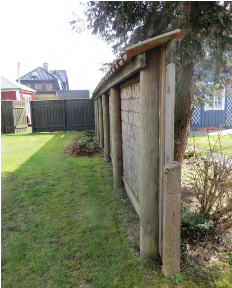
Tomtens södra gräns med planket av stolpar, vassmatta och tegelpannor upptill.
