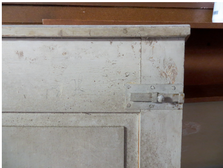
Inför ommålningen justerades bänkdörrarna så att de gick att stänga på ett enkelt sätt. Reglarna rengjordes så att de inte hakar upp sig. Vid demonteringen av gångjärn, regler eller andra beslag återanvändes befintliga spårskruvar.
