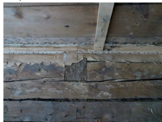
Smedjegatan 11, bottenvåningen. Båda dessa bilder visar de avsågade bjälkarna från ett tidigare, lägre bjälklag och den nya taknivån.
