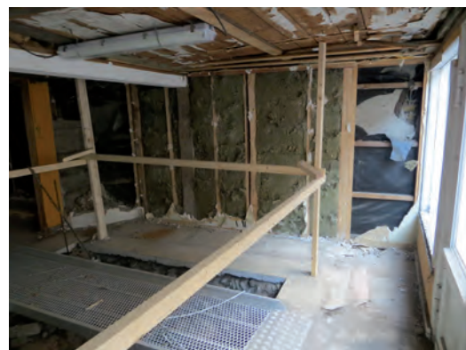
Smedjegatan 13, bottenvåningen. Den borttagna timmerväggen mot den östra grannfastigheten, ersatt med regelverk.
