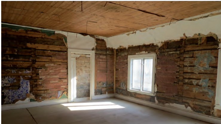
Smedjegatan 11, rum 114. Översikt som visar spår efter borttagna timmerväggar.
