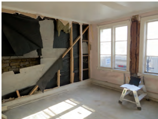
Större delen av timmerväggen mot grannhuset i öster hade rivits och ersatts med en regelverksvägg. Detta bidrog till svårigheterna att lyfta byggnadens stomme.
