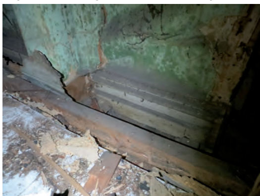
Smedjegatan 11, väggen mot den västra granntomten. Den övre av dessa bilder visar den borttagna väggens knutar mot ytterväggens timmer. Följaren till vänster har stadgat upp väggen efter väggborttagningen. Den nedre bilden visar en golvsöckel i ett läge under den nuvarande golvnivån.
