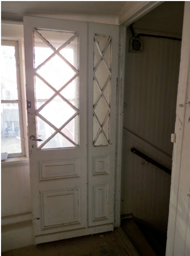
Smedjegatan 11, rum 101. Öppningen mot trappnedgången är försedd med en diagonalspröjsad dörr.
