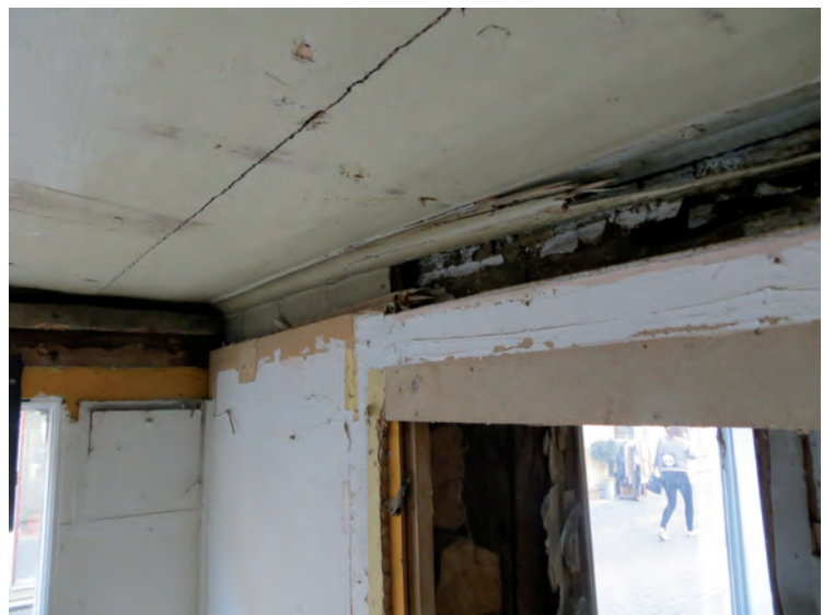
Smedjegatan 13, bottenvåningen. Ovan: Bilden visar den tidigare körportens tak med slät brädpanel. Till höger skymtar den stålbalk som ersatte körportens östra timmervägg. Till höger: Här kan man både se körportens brädtak, väggpanel och taklist.
