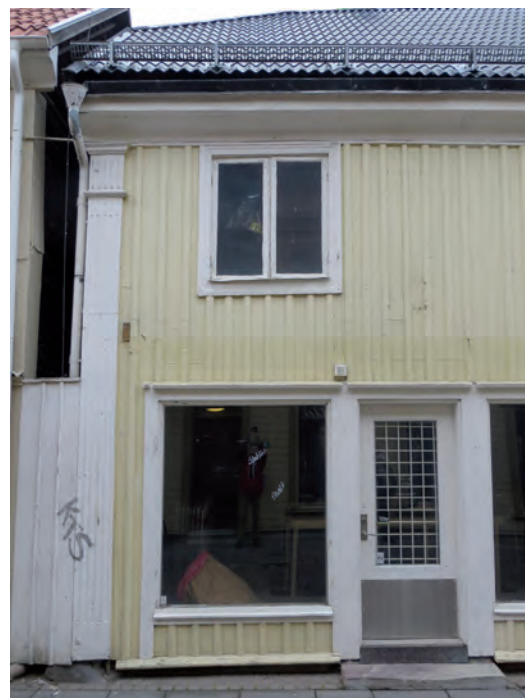
Smedjegatan 11, västra gatufasaden. Bland fasaddelarna är panelen, hörnpilastern och takgesimsen från omkring 1840. Övervåningens fönster tycks vara från omkring 1900.
