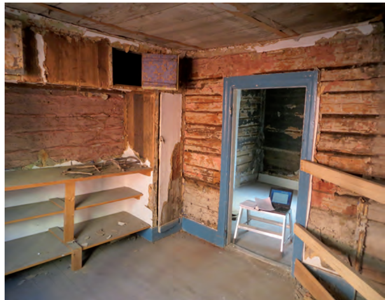
Smedjegatan 11, rum 104. Översikt med de inbyggda garderobsskåpen. Avgränsningen till höger beror på att en kalkelugn och murstock demonterats och ett schakt har bildats.
