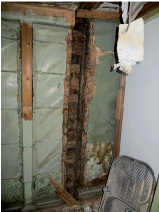
Smedjegatan 11, väggen mot den västra granntomten. Den övre av dessa bilder visar den borttagna väggens knutar mot ytterväggens timmer. Följaren till vänster har stadgat upp väggen efter väggborttagningen. Den nedre bilden visar en golvsöckel i ett läge under den nuvarande golvnivån.
