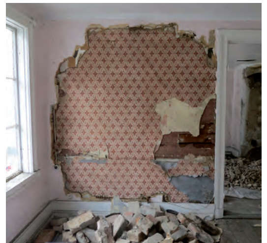
Till vänster: Det understa skiktet med stänkmålerier var mycket välbevarat under senare pappspänning.
