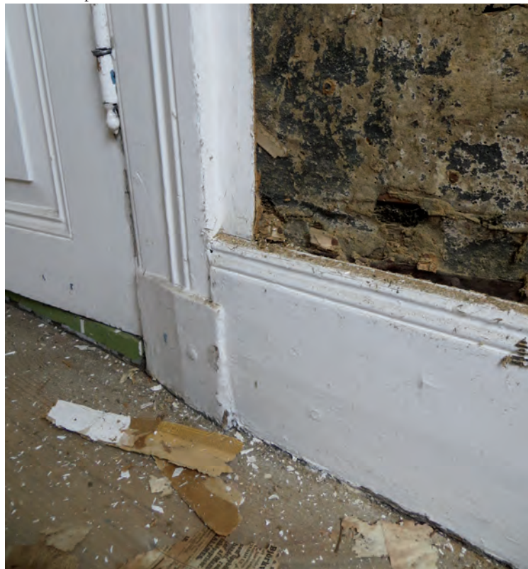
Nedan: Smedjegatan 11, rum 113. Detalj av vägg med gråsvart bröstning, golvsockel samt plåt bakom denna.
