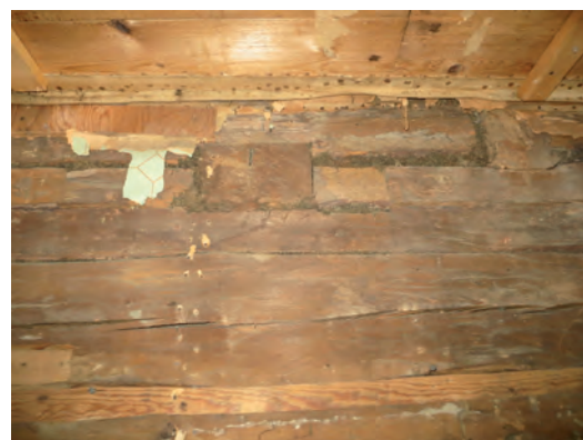
Smedjegatan 11, bottenvåningen. Båda dessa bilder visar de avsågade bjälkarna från ett tidigare, lägre bjälklag och den nya taknivån.
