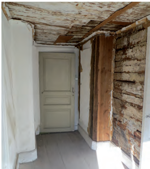
Smedjegatan 11, rum 113. Överst: Spår i tak och på vägg efter vindstrappa.
