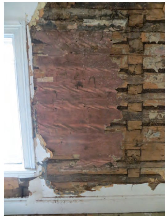
Smedjegatan 11, rum 114. Överst: Spår i timmerväggen mot gatan efter rödaktig väggmålning och borttagen timmervägg.
