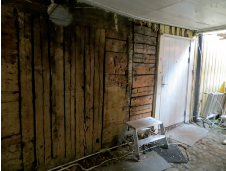
Smedjegatan 11, körporten. Körportens västra vägg hade spår av ett igensatt dörrhål in till den stora lokalen där. Man kan ana ett borrarhål i dörrhålets övre vänstra hörn, vilket tyder på att öppningen tagits upp sekundärt - man har borrar ett hål i väggen och sedan sågat ut öppningen från detta. Bilden till höger visar knutraden i denna bilds mitt.
