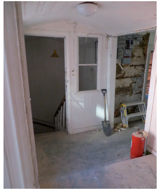
Ovan: Smedjegatan 11, rum 101. Öppningen mot trappnedgången. Smedjegatan 11, rum 101.
