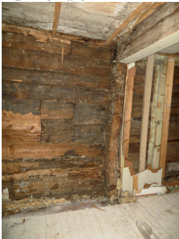
Smedjegatan 11, väggen mot den västra granntomten. Den övre av dessa bilder visar den borttagna väggens knutar mot ytterväggens timmer. Följaren till vänster har stadgat upp väggen efter väggborttagningen. Den nedre bilden visar en golvsöckel i ett läge under den nuvarande golvnivån.
