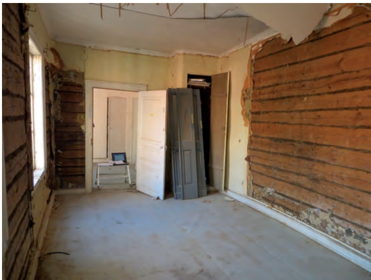
Nedan: Rummet mot söder med dörr mot rum 117.
