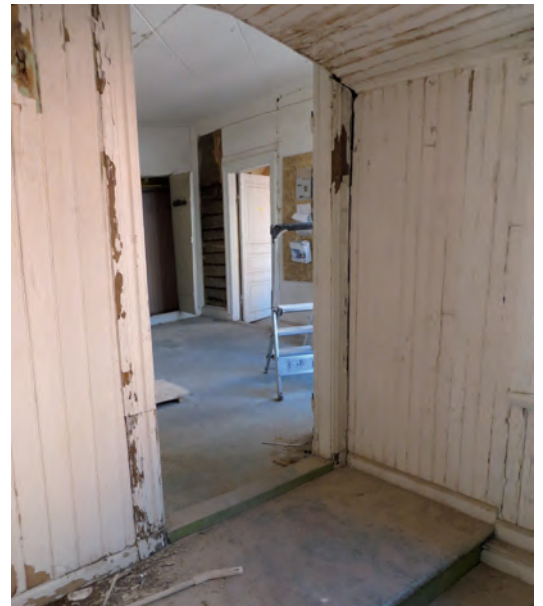
Nedan: Öppningen mot rum 117.
