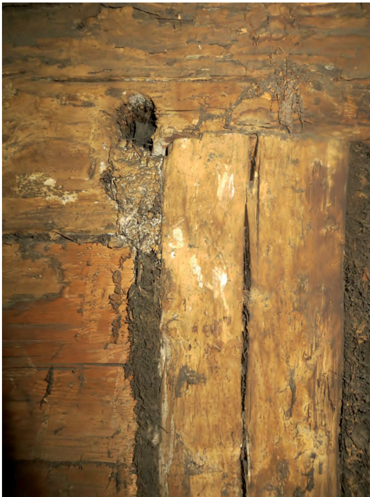
Smedjegatan 11, körporten. Körportens västra vägg hade spår av ett igensatt dörrhål in till den stora lokalen där. Man kan ana ett borrarhål i dörrhålets övre vänstra hörn, vilket tyder på att öppningen tagits upp sekundärt - man har borrar ett hål i väggen och sedan sågat ut öppningen från detta. Bilden till höger visar knutraden i denna bilds mitt.
