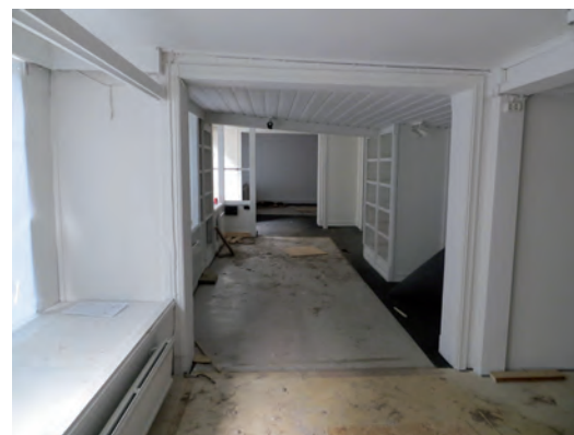
Smedjegatan 13, bottenvåningen. Den öppna planlösningen sedd från fastighetens östra del.
