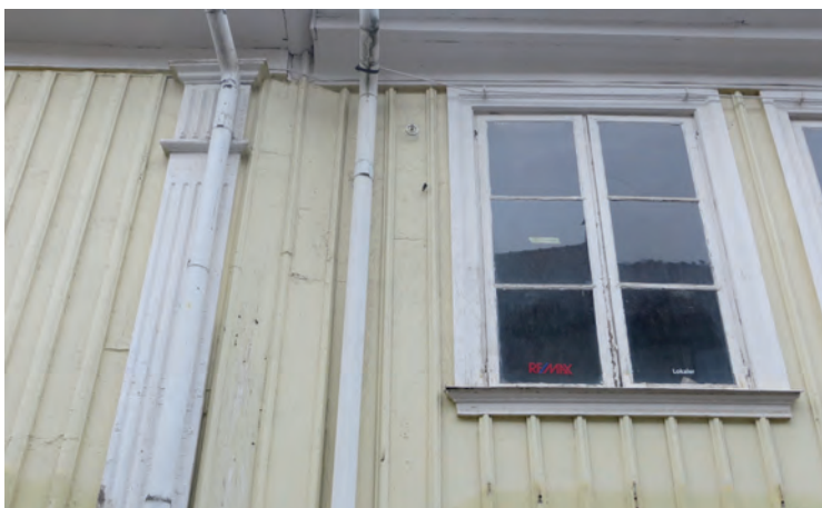
Ovan: Gatufasadens möte mellan Smedjegatan 11 (till vänster) och Smedjegatan 13 (till höger). Den västra (till höger) och den östra längans fasader. Här ses bland annat skillnaden beträffande bredd på locklister. Mellan stuprören har funnits en synlig lucka mellan husen som sedan täckts för.
