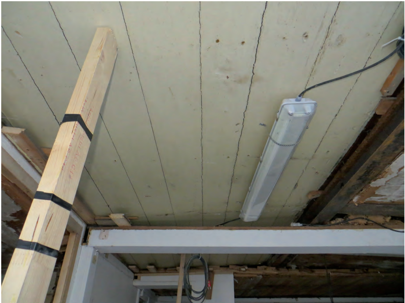
Smedjegatan 13, bottenvåningen. Ovan: Bilden visar den tidigare körportens tak med slät brädpanel. Till höger skymtar den stålbalk som ersatte körportens östra timmervägg. Till höger: Här kan man både se körportens brädtak, väggpanel och taklist.
