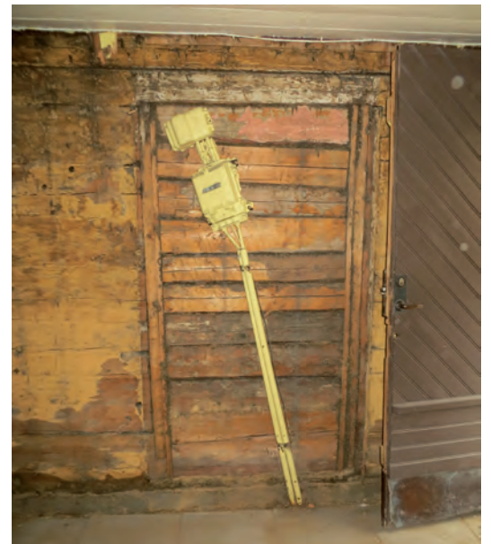
Till vänster: Smedjegatan 11, körporten. Den sekundärt upptagna och nu igensatta dörröppningen med borrarhål för upptagningen.
