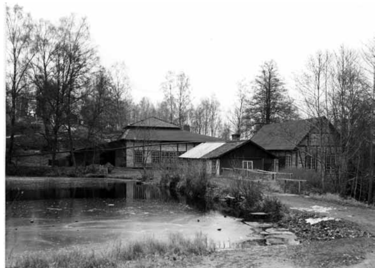
Masugnen och gjuteriet vid gjuteridammen.
