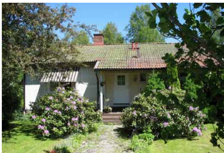
Mo 1:48, är ett av de Myresjöhus som uppfördes på 1950-talet. Husen var av två olika modeller, antingen som denna med taksprånget utdraget över verandan, längs med ena sidan av huset, eller som två intill varandra adderade byggnadskroppar med verandan i vinkeln.
