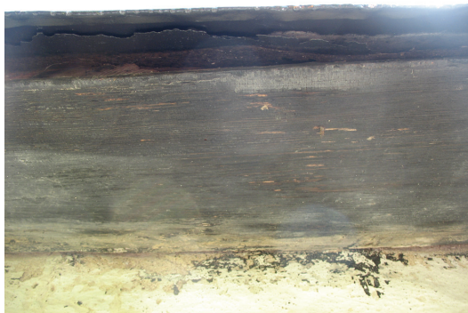
Under nuvarande plåttäckning syns kanten på en äldre, troligen ursprunglig plåttäckning.
