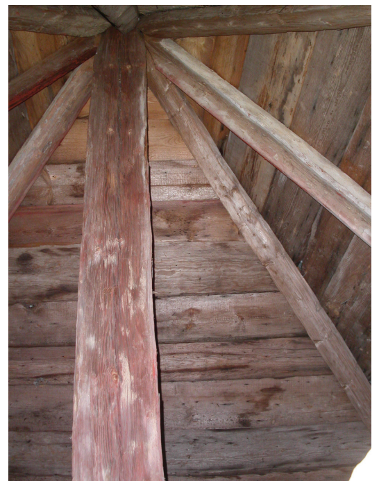
Takkonstruktionen med ursprunglig hjärtstolpe och högben, samt trobrädor (de översta utbytta 1900-tal). Foto: Jonas Haas 2005.
