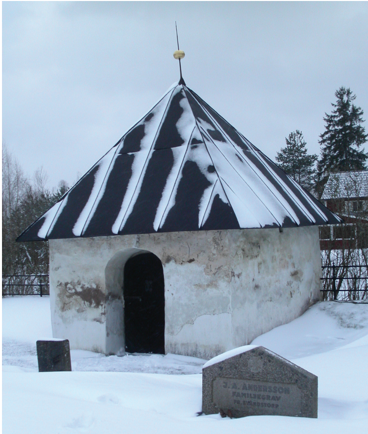
Gravkoret sett från nordväst vintern 2005. Notera de vitkalkade cementlagningarna nederst på murarna. Foto: Jonas Haas.
