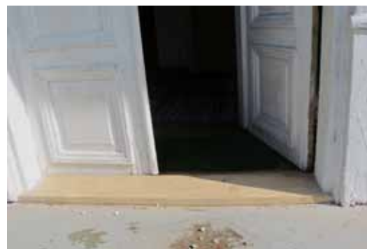
Tröskeln till huvudentrén var helt upprutten och byttes ut mot en ny tröskel av ek i ett stycke, 15 cm bred och 8 cm hög. Tröskeln har sågats ur för dörrbladsanslutning. Nedtill var dörrkarmarna ruttna till cirka 20 cm, de ruttna delarna har bytts ut och ersatts, spacklats och vitmålat.
