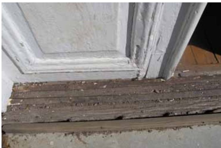
Tröskeln till huvudentrén var helt upprutten och byttes ut mot en ny tröskel av ek i ett stycke, 15 cm bred och 8 cm hög. Tröskeln har sågats ur för dörrbladsanslutning. Nedtill var dörrkarmarna ruttna till cirka 20 cm, de ruttna delarna har bytts ut och ersatts, spacklats och vitmålat.
