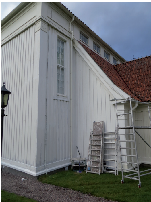
Ytor med ”apelsinhud” fanns på sakristians norra sida. Med mekanisk slipning borttogs ”valkningar” och ”rinningar”. Den avslutande slipningen fick ske för hand för att uppnå ett gott resultat utan spår av maskinslipning.
