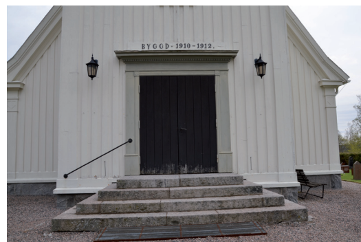
Entréfasaden. Befintliga dörrblad var dåliga i nedre delen. Panelen snedsågades i botten och kompletterades med en horisontell snedsågad bottenlist
