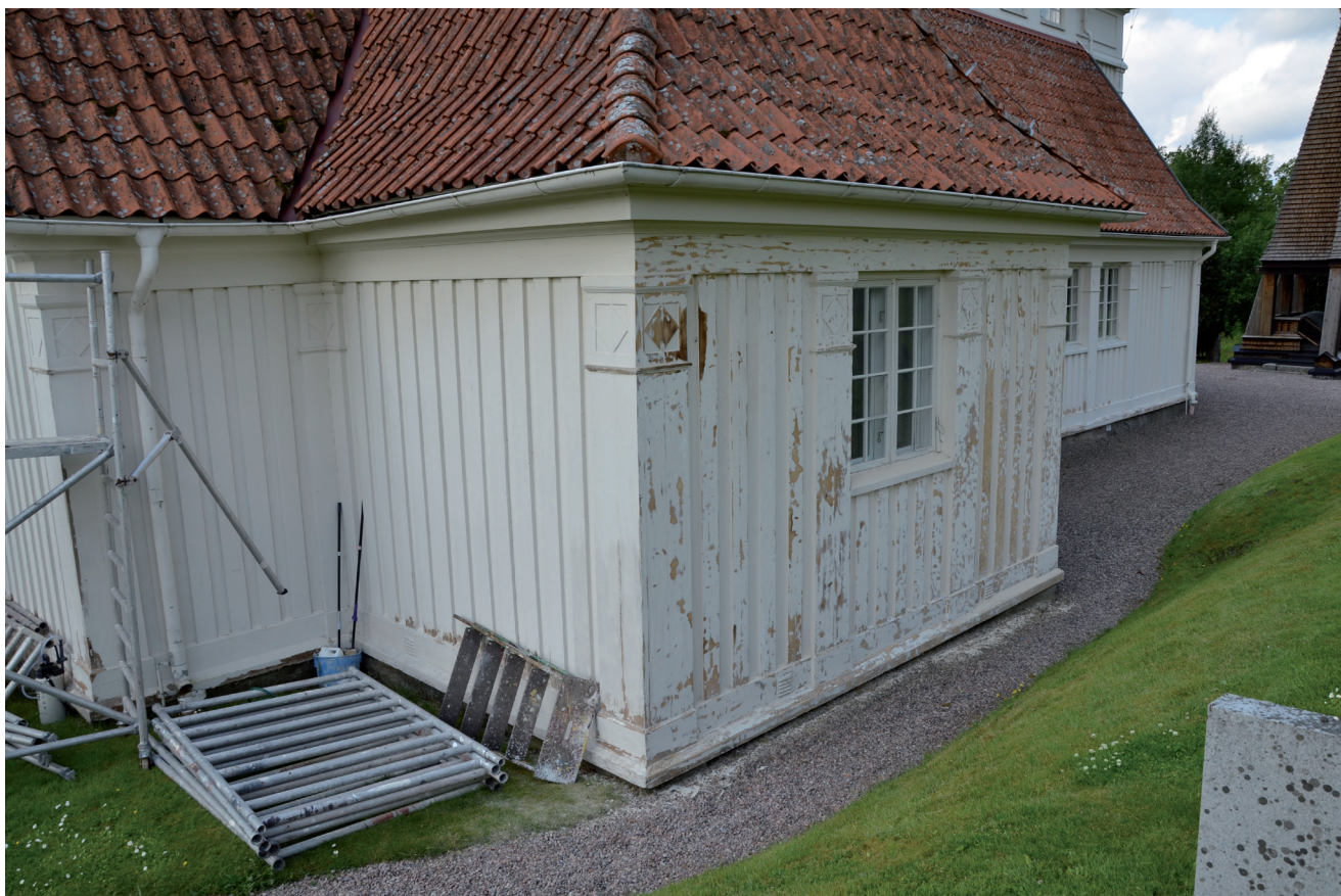
Ytor med ”apelsinhud” fanns på sakristians norra sida. Med mekanisk slipning borttogs ”valkningar” och ”rinningar”. Den avslutande slipningen fick ske för hand för att uppnå ett gott resultat utan spår av maskinslipning.
