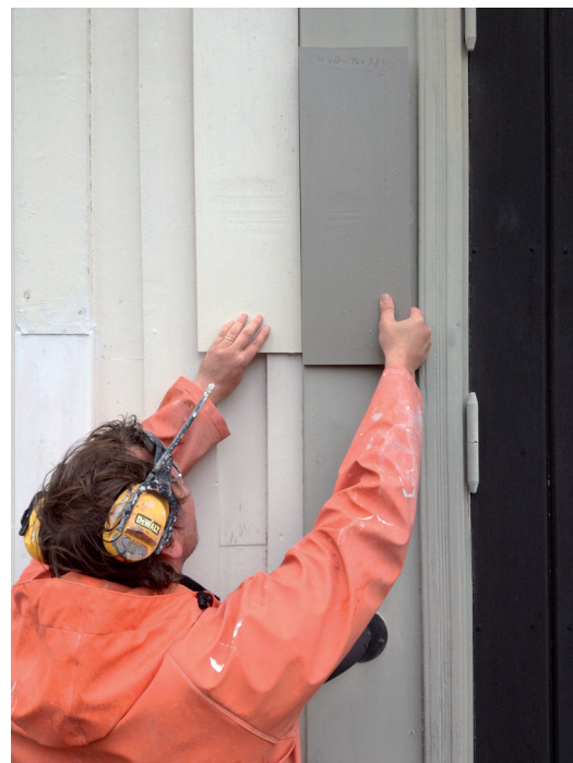
Före restaureringen utfördes provmålningar för att återskapa befintliga och ursprungliga kulör. Den här provmålningen av portomfattningen uppfattades som för mörk (Foto: I. Selse).
