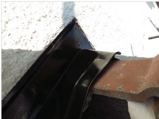
Ny plåt i mötet långhusets tak och tornfasaden med bättre putsankantning än tidigare.
