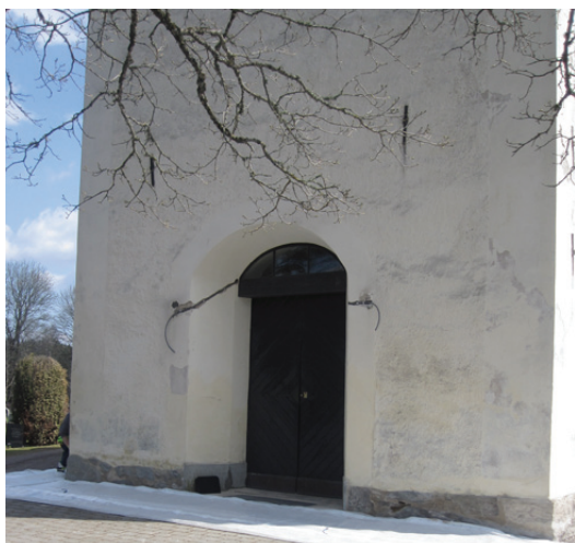
Ovan: Tornet uppvisade smärre putssläpp och avfärgningen var delvis avflagnad.
