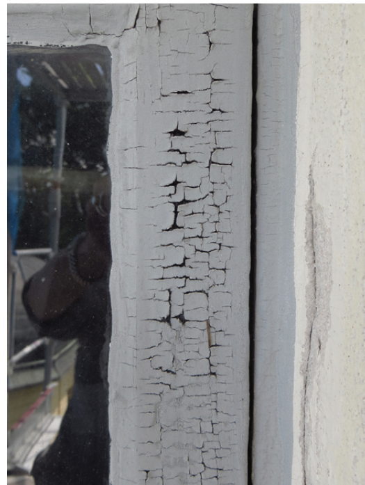
Till vänster: Lanternin och omfattning. Den tidigare grå kulören lyser igenom det sentida svarta färgskiktet. Ovan: Fönstren har tidigare varit svartmålade.
