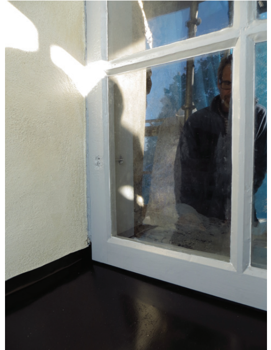
Detalj färdigmålat fönster i tornet. Plåttäckningen i solbänken är också utbytt.
