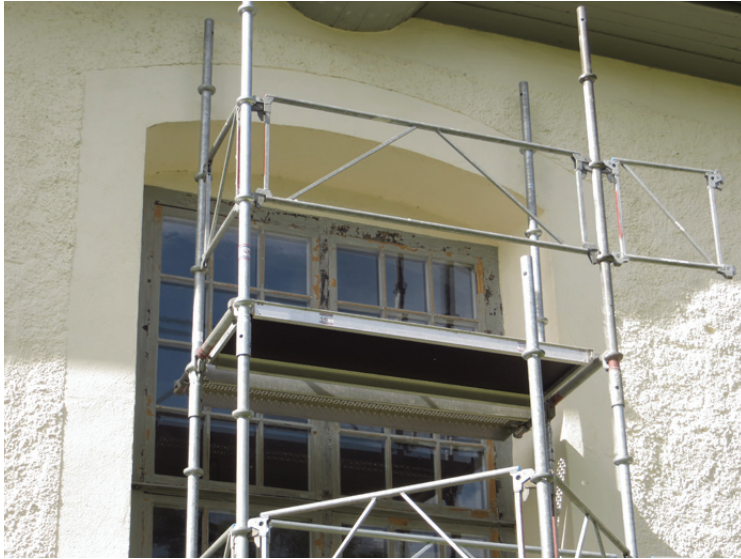
Till vänster. Pågående skrapning av fönstren. Ovan: Fönstret i tornet hade rötskador i karmen och bågens bottenstycke.
