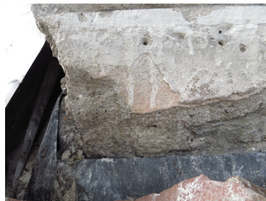
Till vänster: Lanterninens takfot har ursprungligen varit svart, därefter finns olika lager av gråa och vita färgskikt. Ovan: Under plåtanslutningen finns en rosaröd färgton på putsen.
