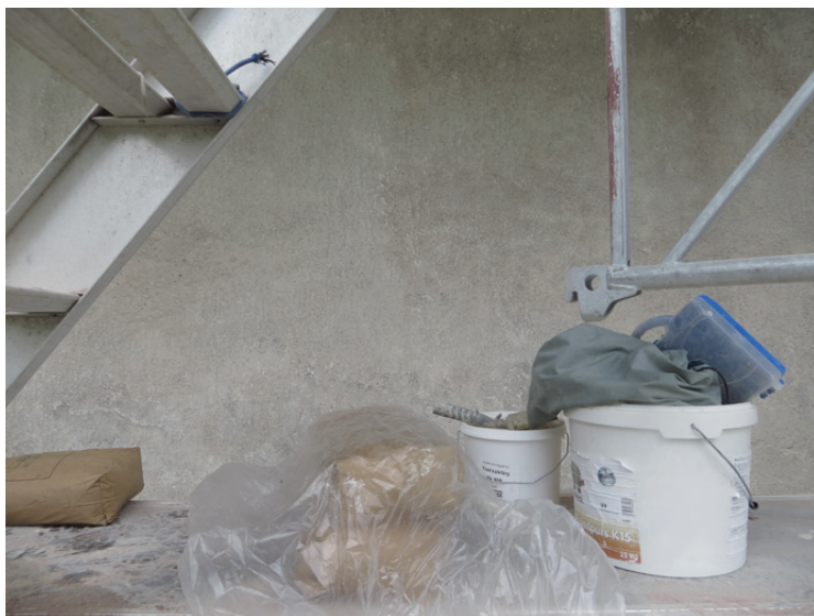
Fasaden är blästrad.
