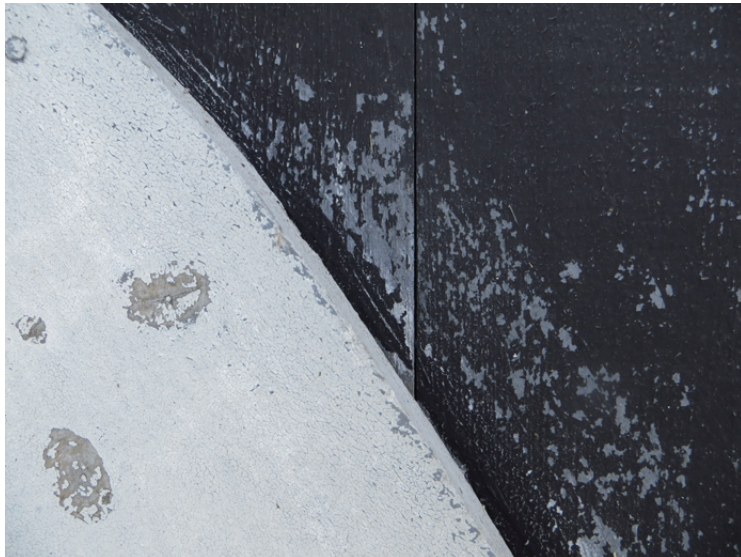
Till vänster: Lanternin och omfattning. Den tidigare grå kulören lyser igenom det sentida svarta färgskiktet. Ovan: Fönstren har tidigare varit svartmålade.
