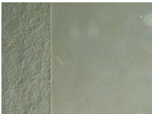
Detalj tornet, spritputsad fasad och slätputsat hörn.
