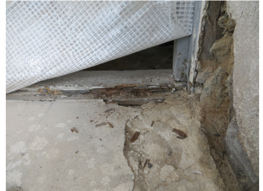
Till vänster. Pågående skrapning av fönstren. Ovan: Fönstret i tornet hade rötskador i karmen och bågens bottenstycke.
