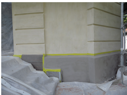
Kapellets sockel avfärgades med en hydraulisk kalkfärg, bruten med grön umbra.
