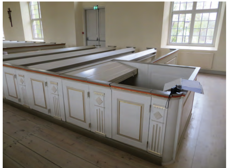
Ovan och till höger: Hela den bakersta bänken togs bort och den näst bakersta behölls till 1/3 och inreddes för mixerbordet.
