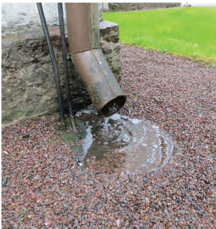
Till vänster: Vattensamlingen under ett stuprör var en utlösande faktor till att stenkistorna tillkom. Ovan: Grävning av stenkista pågå.
