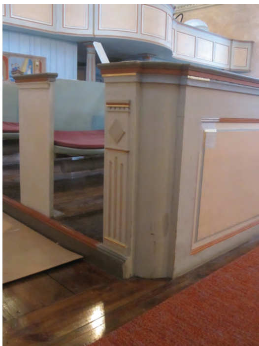
Ovan och nedan: Vid projekteringen av bänkmålningen gjordes uppstrykningsprov både på bänkarna och på skiva som dokumentation och referens.
