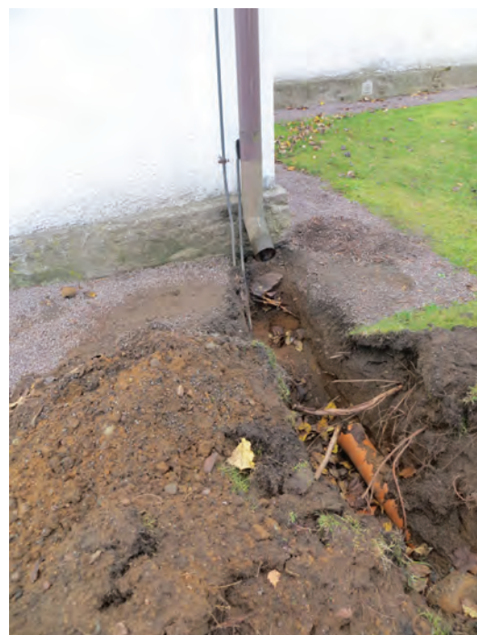
Till vänster: Vattensamlingen under ett stuprör var en utlösande faktor till att stenkistorna tillkom. Ovan: Grävning av stenkista pågå.
