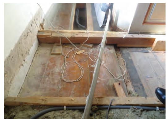
Bilden visar ny rördraging i sidogången mot söder. Här blottades också det ursprungliga golvet som täcktes över när korpodiet förstörades.
