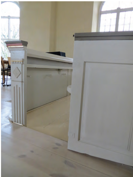
Golven i bänkkvarteren täckmålades i ljus gulbeige kulör. Bilden visar även det övriga golvet som behandlades med hårdvaxolja.
