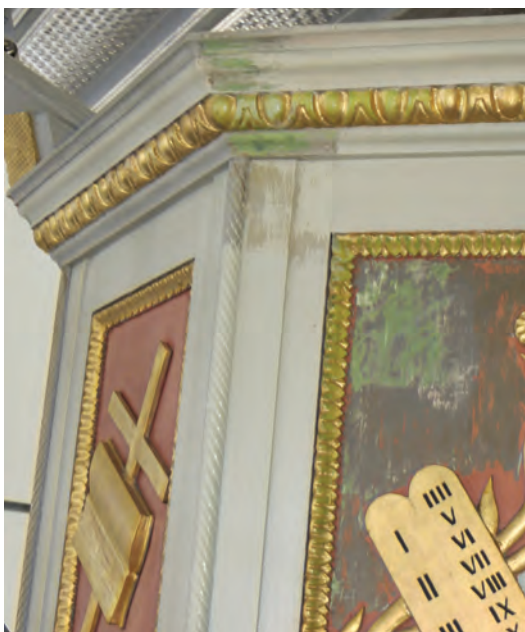
Ovan: Skrapprov på predikstolskorgen bekräftade de undersökningar som gjorts 1979, som bland annat visar att korgens spegelfält varit gröna i ett tidigt skede och dessförinnan troligen grå. Även listverken hade dessa färgskikt. Den vertikala tvinnade staven i hörnen hade varit förgyllt i ett tidigt skede, kanske ursprungligen. Denna förgylldes åter vid den nu genomförda restaureringen.
