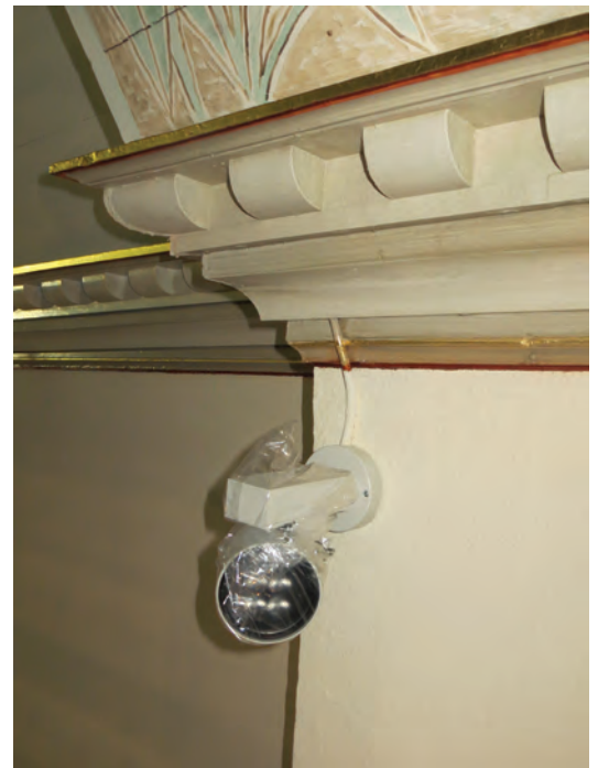
Ovan: En strålkastare placerades strax under taklisten för att belysa altartavlan.
