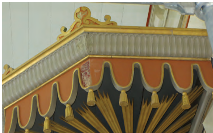
Ovan: Skrapprov på predikstolskorgen bekräftade de undersökningar som gjorts 1979, som bland annat visar att korgens spegelfält varit gröna i ett tidigt skede och dessförinnan troligen grå. Även listverken hade dessa färgskikt. Den vertikala tvinnade staven i hörnen hade varit förgyllt i ett tidigt skede, kanske ursprungligen. Denna förgylldes åter vid den nu genomförda restaureringen.
