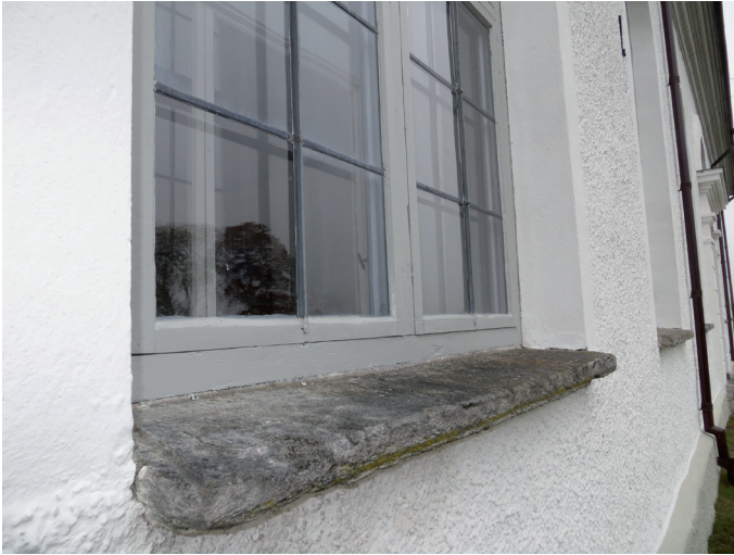
Ovan: Fönster på sydfasaden efter ommålning. Till höger: Ommålat fönster.
