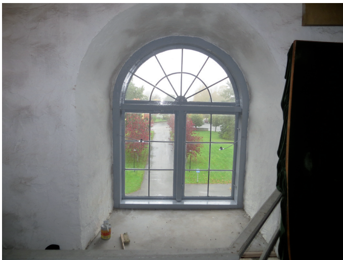
Ovan: Fönster i tornet efter ommålning. Till höger: Ommålat fönster i lanterninen.
