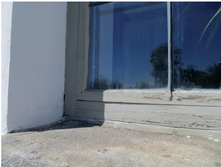
Ovan: Fönster på sydfasaden inför ommålning.
