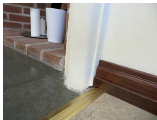
Detalj av spisens anslutning till golvet efter arbetena.
