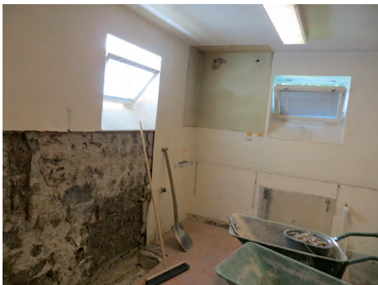
Ovan: Det tidigare kopieringsrummets golvkonstruktion. Till vänster: Rivning av väggbeklädnader. Nedan: Det nyinredda köket.
