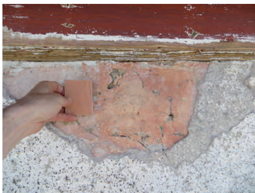
Slätputsparti överst på tornets västra fasad med rödorange kulör.
