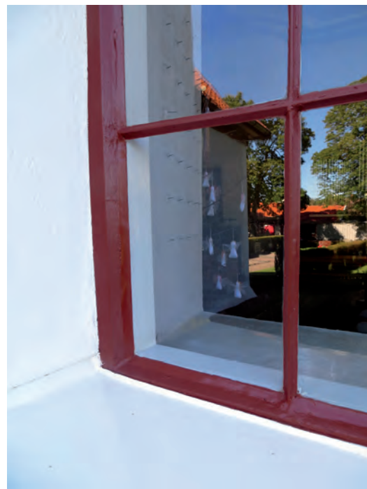
Ovan: Detalj av fönster efter ommålning. Till vänster: Långhusfönster på norrfasaden efter ommålning.
