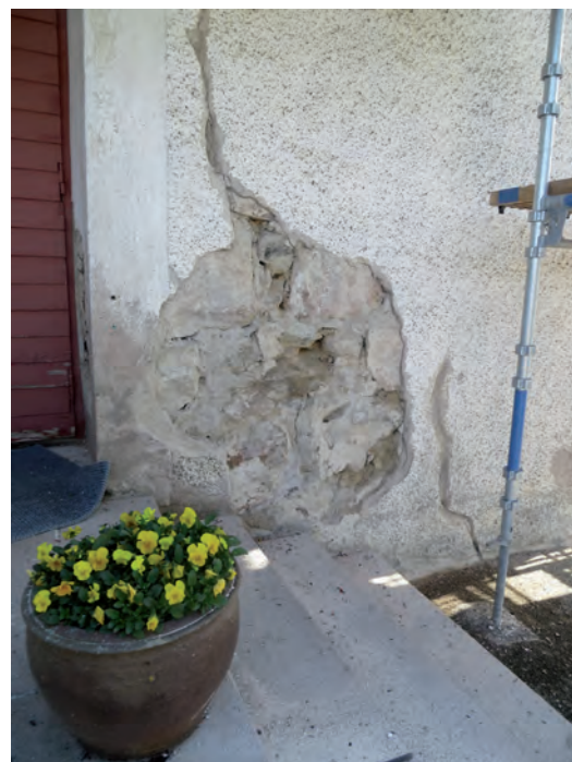
Ovan: Absidens slätputsade fält hade en hård krusta yterst, som lätt lossnade. Dessa partier putsades därför om. Nedan: Putsskador invid den västra ingången.
