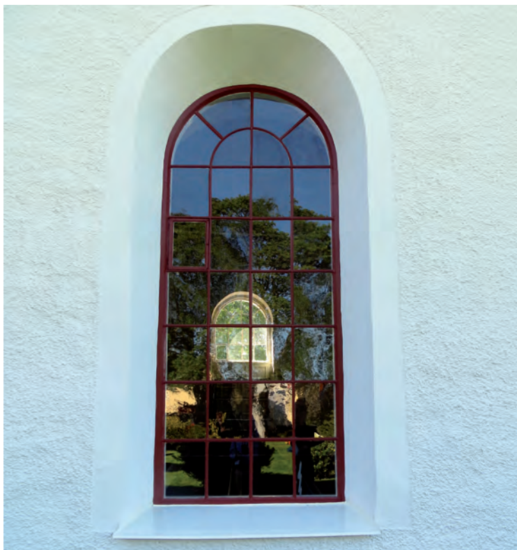
Ovan: Detalj av fönster efter ommålning. Till vänster: Långhusfönster på norrfasaden efter ommålning.
