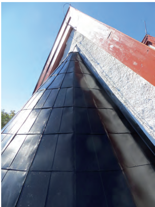
Ovan: Absiden efter omläggningen av taket. Nedan: Det nya taket på absiden. Genom omläggningen fick taket generalskarvar både vertikalt och horisontellt.
