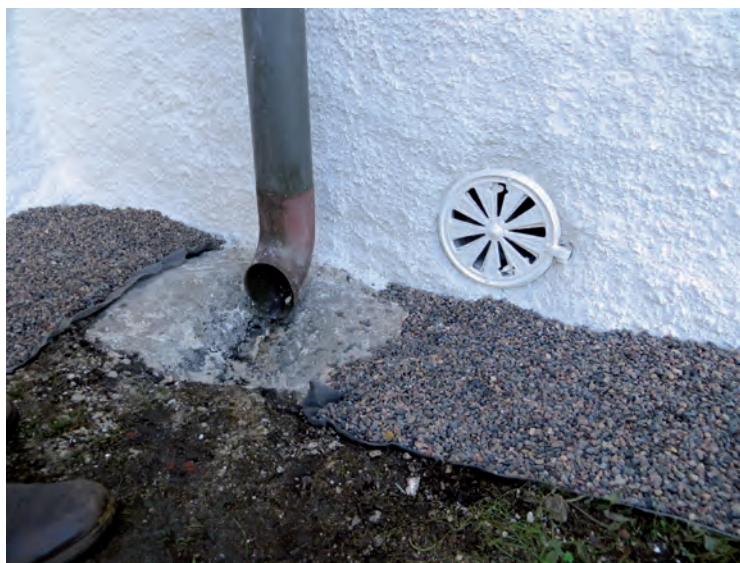
Sockelventilerna i långhuset bevarades och målades upp i väggkulören.
