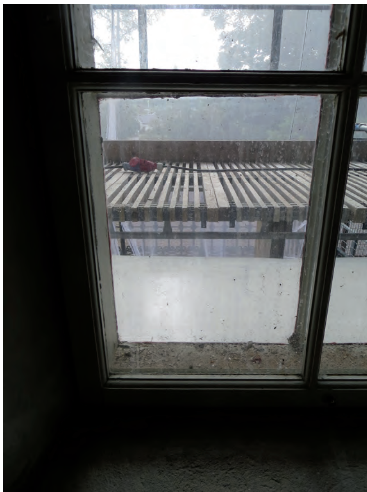
Eftersom det kom in smuts mellan bågarna och en rengöring förutsatte att innerbågarna måste demonteras företogs även en ommålning av innerbågarnas utsidor.
