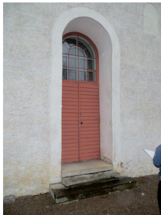
Ovan: Fönster sett från insidan inför arbetena. Nedan: Sydingången med putsskador nedtill på fasaden.
