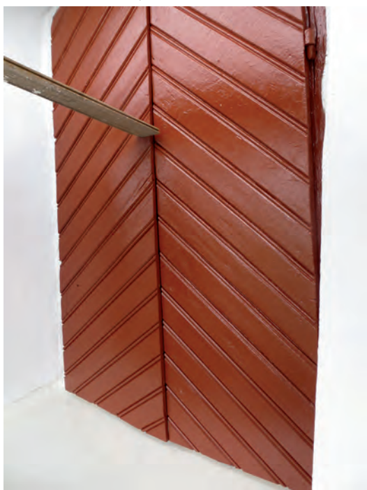
Ovan: Delar av ljudluckornas panel var rötskadad och byttes ut mot ny med identiskt utseende. Nedan: Restaurerad ljudlucka.
