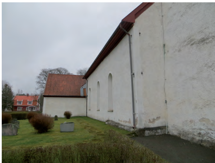
Ovan: Parti av långhusets och korets södra fasad med markering i putsen av medeltida fönster. Till höger: Kyrkans norra fasad med puttskador.
