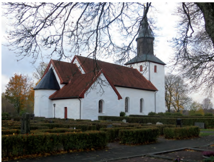
Kyrkan sedd från nordost efter att arbetena avslutats.
