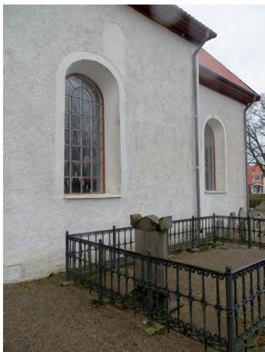
Ovan: Parti av långhusets och korets södra fasad med markering i putsen av medeltida fönster. Till höger: Kyrkans norra fasad med puttskador.
