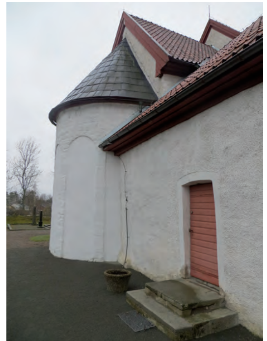
Ovan: Inför arbetena hade absiden ett tak av ogalvaniserad stålplåt i fjällläggning. Generalskarvarna låg horisontellt och allt gav ett särskilt ålderdomligt intryck. Nederst till vänster: Det rotskadade taket inför omläggningen.
