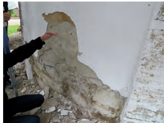
Ovan: Absidens slätputsade fält hade en hård krusta yterst, som lätt lossnade. Dessa partier putsades därför om. Nedan: Putsskador invid den västra ingången.
