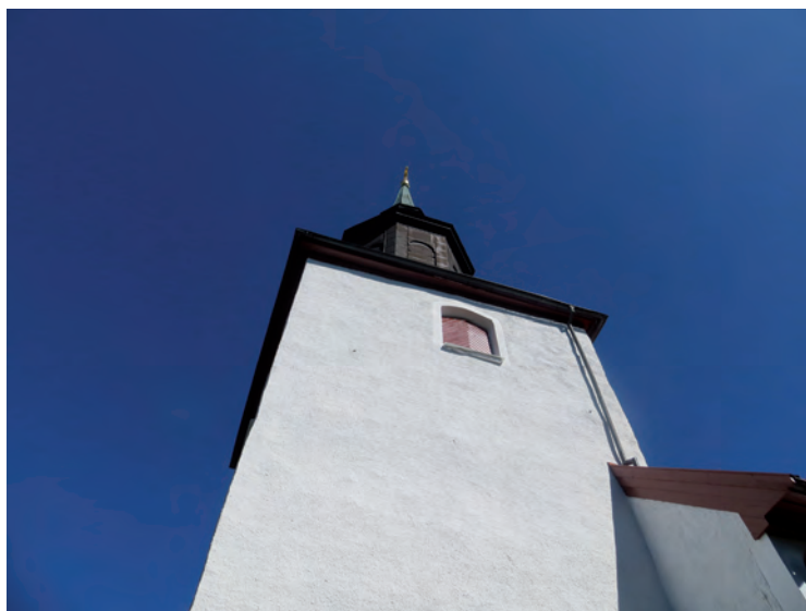
Tornets södra fasad efter putsrenoveringen, lagningen och målningen av ljudluckorna samt förgyllning av korset på tornspiran.
