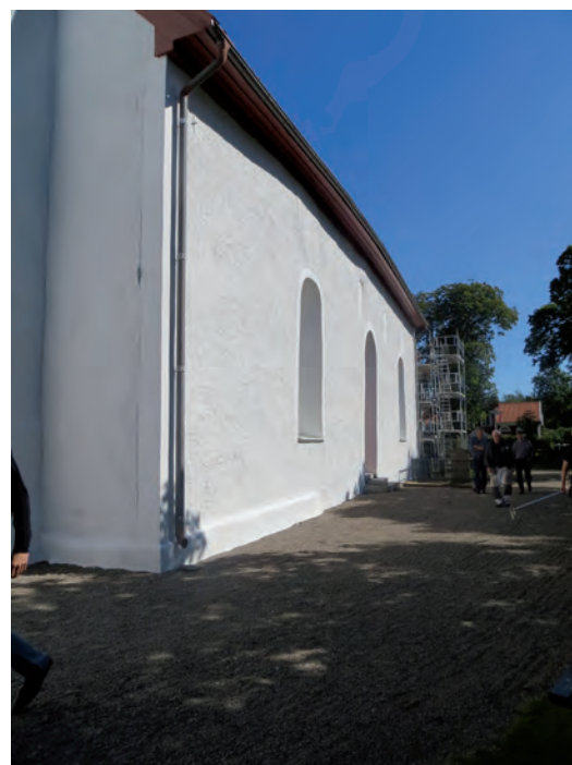
Den södra fasaden efter att arbetena avslutats.
