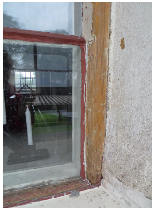
Ovan: Fönster efter skrapning, men före målning. Ovan till vänster: Bågbottnestycket möter gjutjärnspröjsningen.
