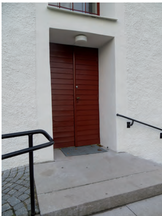
Nedan: Västingången efter arbetenas avslutning.
