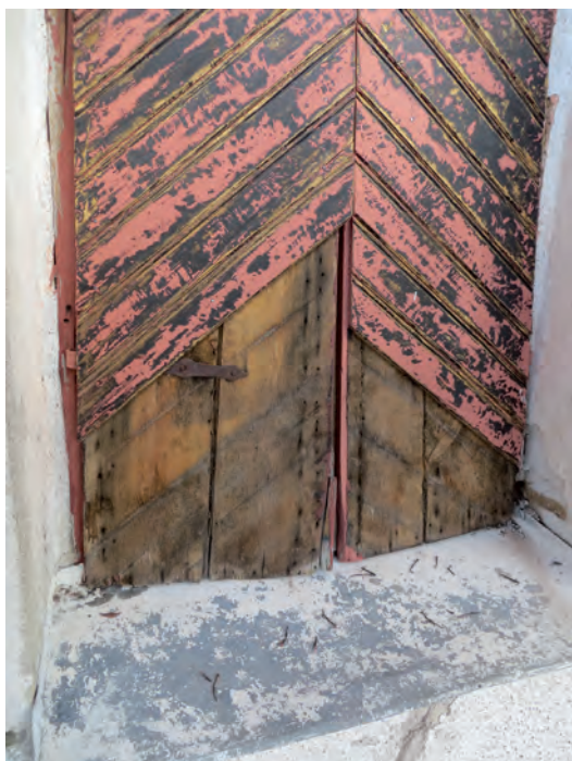
Ovan: Delar av ljudluckornas panel var rötskadad och byttes ut mot ny med identiskt utseende. Nedan: Restaurerad ljudlucka.
