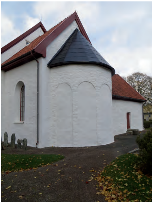
Ovan: Absiden efter omläggningen av taket. Nedan: Det nya taket på absiden. Genom omläggningen fick taket generalskarvar både vertikalt och horisontellt.
