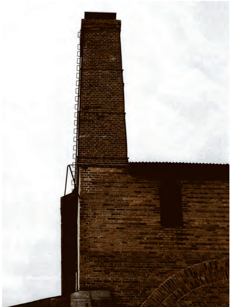
Masugnen efter avslutade arbeten. Foto: Bröderna Bergström Byggnads AB.
