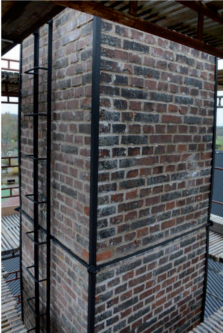
Skorstenen efter byte av skadat tegel, omfogning och målning av stål.
