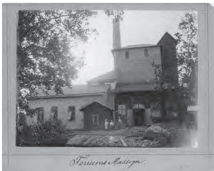
Masugnen från öster, fotograferad under tidigt 1900-tal. Notera det lilla takfallet som fortsätter runt basen på skorstenen. Ur "Åminne - människor och maskiner".
