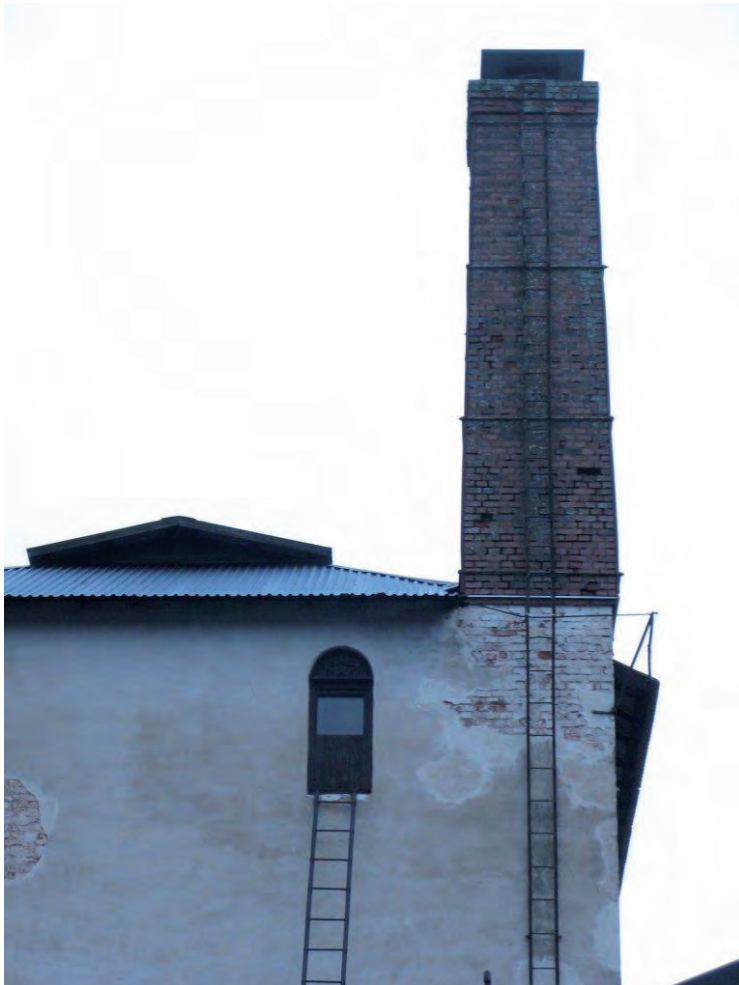
Skorsten och parti av sydfasad före arbetena.
