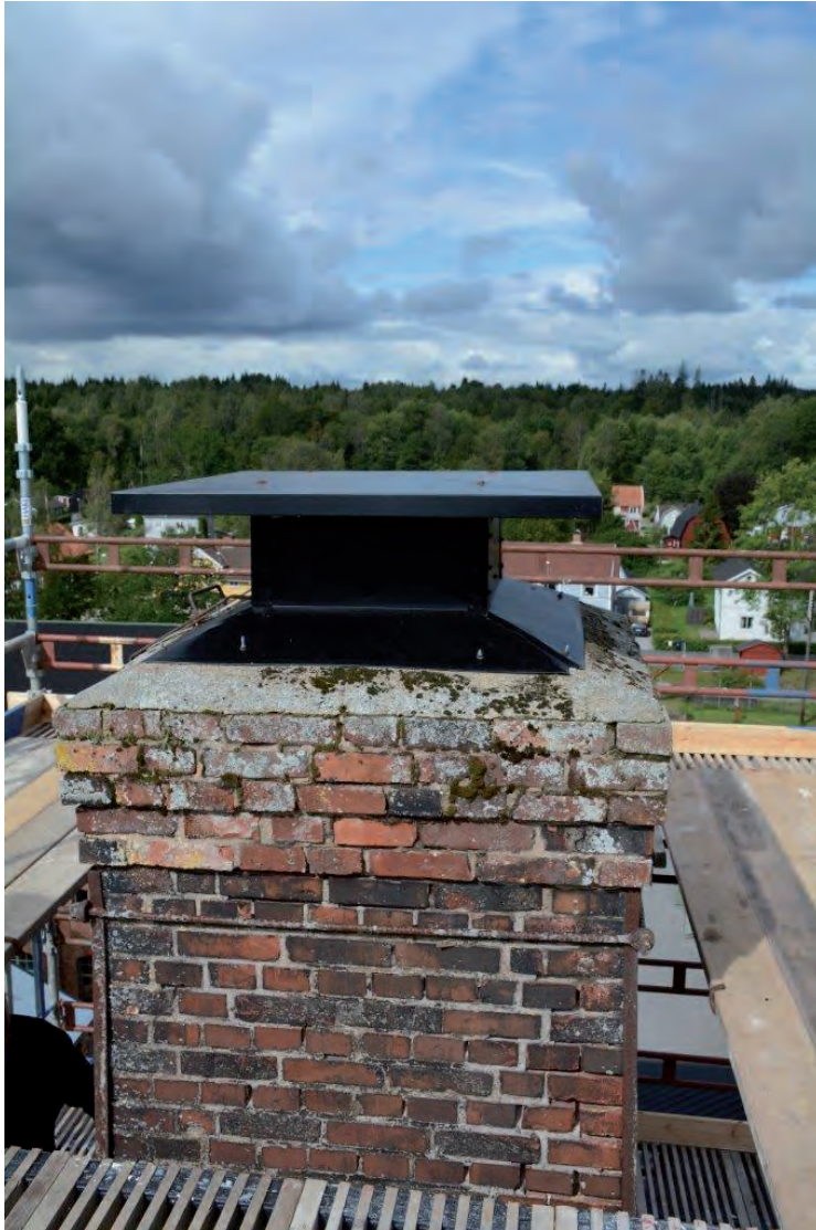
Skorstenskrönet med betongplombering och sentida plåthuv i god kondition.
