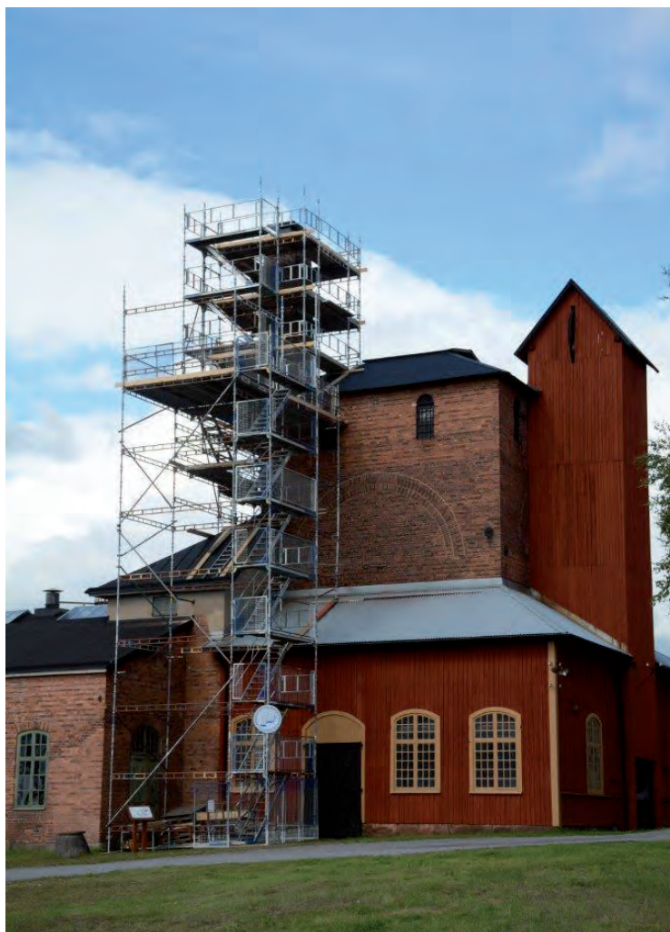
Uppstart av arbetena i augusti 2014.
