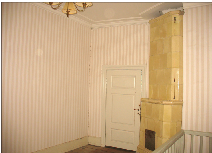
Kammaren norr om förmaket i övervåningen, rum 205, hade före restaureringen kvar en viss tidig 1800-talskaraktär med sin gulglaserade kakelugn, halvfranska dörr och brädgolv. Även trappräcket med sina snedställda ribbor var gustavianskt till sin typ.
