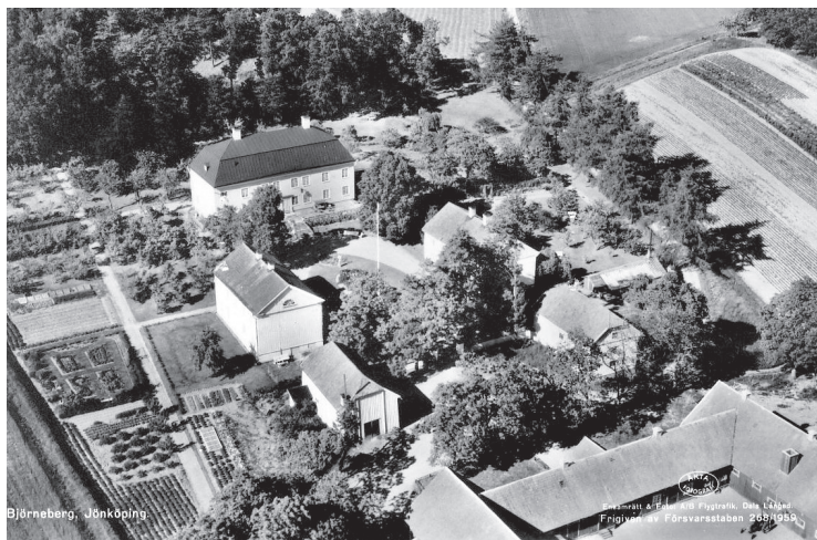
Herrgårdsanläggningen under 1900-talets första hälft.
