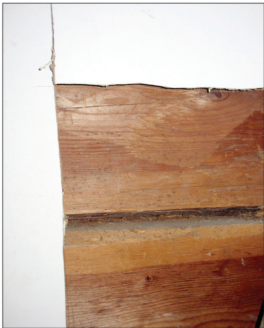
Underliggande timmervägg obehandlad i rum 204.
