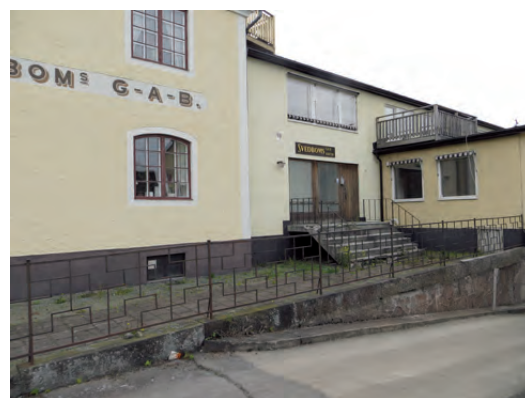
Kvarteret Felsteget, verkstadsbyggnader från olika tider.
