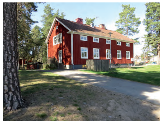
Den gamla komministergården återuppfördes som barnträdgård i parken.
