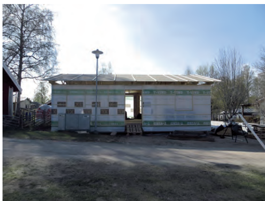
Pågående ombyggnad av en av stugorna på Östanå.
