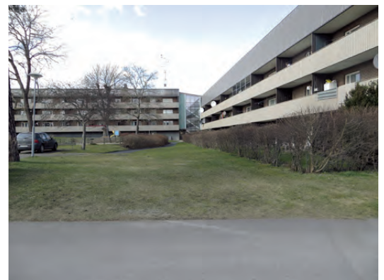
Loftgångshusen i kvarteret Hackspetten var stiftelsen Witalabostäders första byggnadsprojekt.
