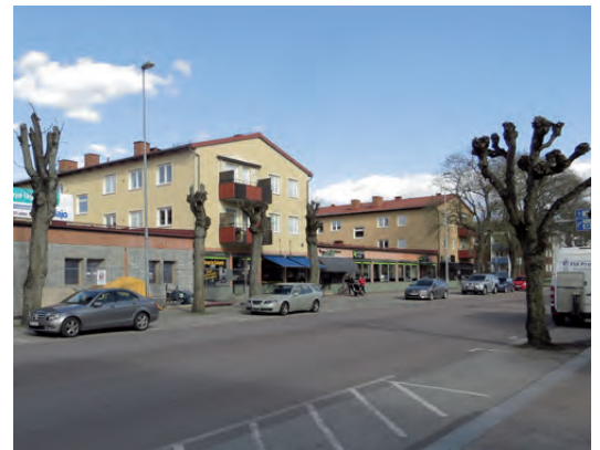
Kvarteret Norresand uppfördes av HSB Jönköping.
