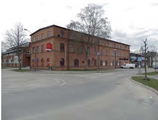
Fabriksbyggnader uppförda för Hvetlanda snickerifabrik, sedermera JOC i kvarteret Trasten 17.
