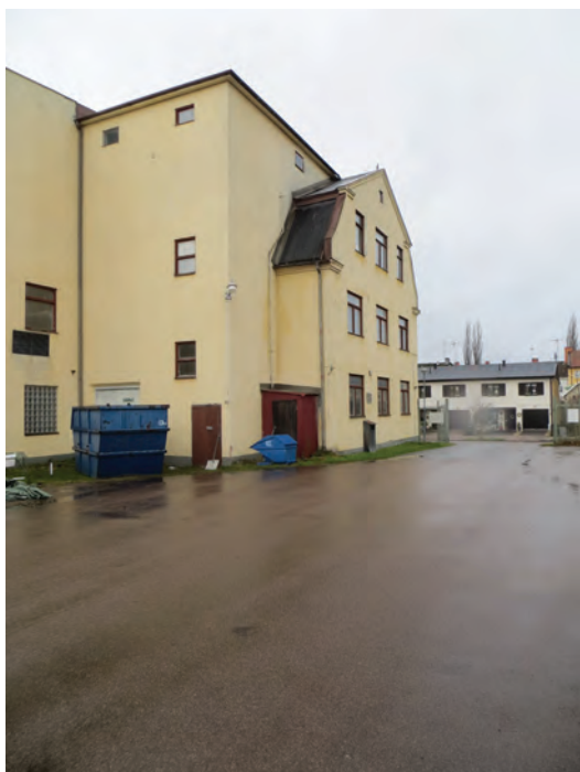
Ovan: Gaveln på den äldre byggnadskroppen samt det sekundära trapphuset. Ovan till höger: Den äldsta byggnadskroppens huvudfasad mot väster.
