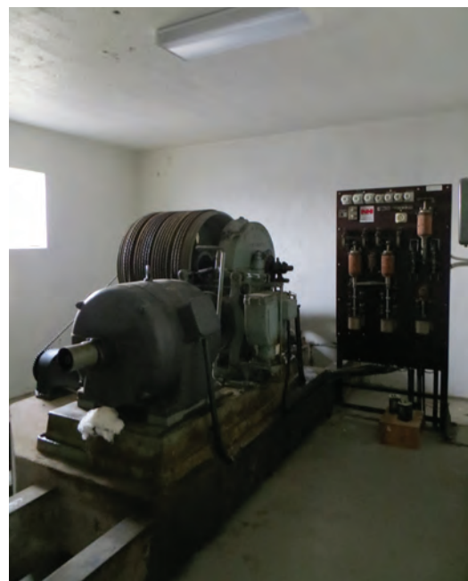
Ovan: Det översta vindsutrymmet i tillbyggnaden omfattar en del äldre föremål och ritningar från den tid då AB Westbergs möbler verkade i byggnaden. Till höger: Maskinrummet för en av hissarna från 1940-talet.
