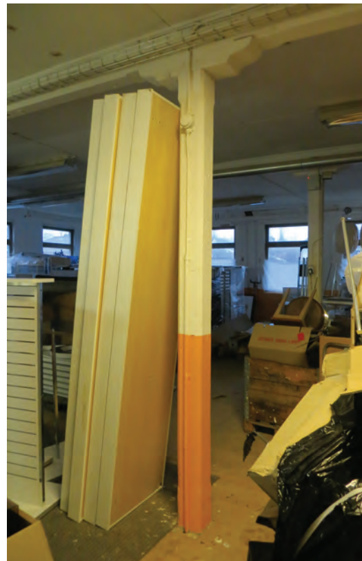
Ovan: Mellanbjälklagen bärs upp av träpelare i två rader i byggnadens längdriktning.
