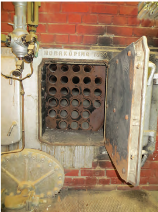
I vinkeln mellan den ursprungliga fabriksbyggnaden och tillbyggnaden från 1940-talet finns pannrummet. Ångpannan är från 1930 och den gav värme åt fabrikslokalerna och behövdes för torkningen av virket.
