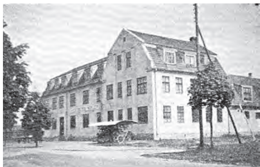
Nedan: Fabriksbyggnaden sedd från sydväst (efter Samlingsverket städer och samhällen... 1944).
