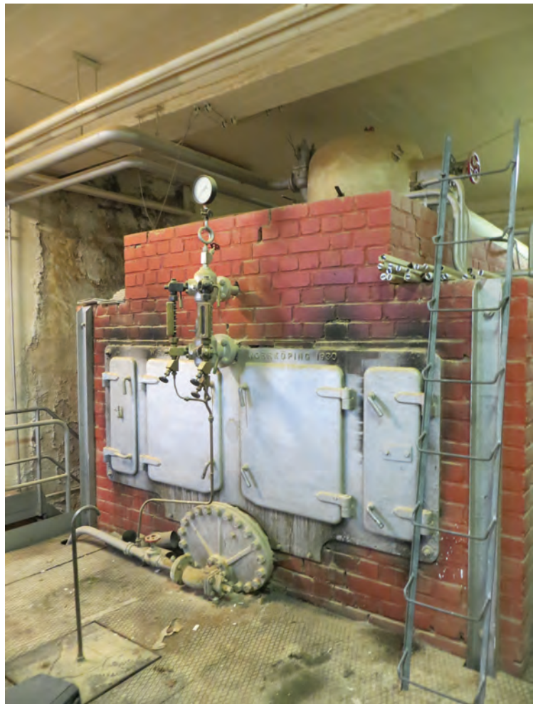
I vinkeln mellan den ursprungliga fabriksbyggnaden och tillbyggnaden från 1940-talet finns pannrummet. Ångpannan är från 1930 och den gav värme åt fabrikslokalerna och behövdes för torkningen av virket.
