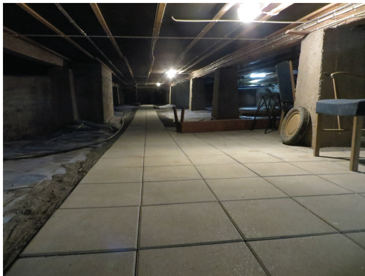
Ovan: Pentryt med ny utrustning. Till höger: Den städade krypgrunden med markplast och betongmarksten. Nedan: Entrén och verkstadsrummet med klinkergolv.
