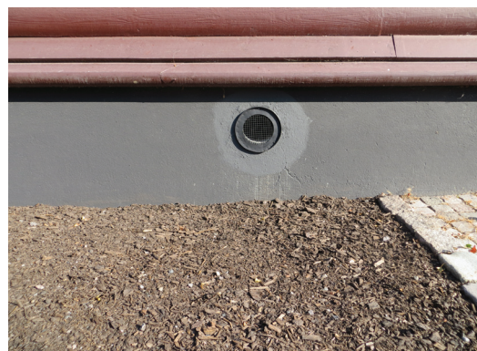
En nya sockelventil efter inmålning.
