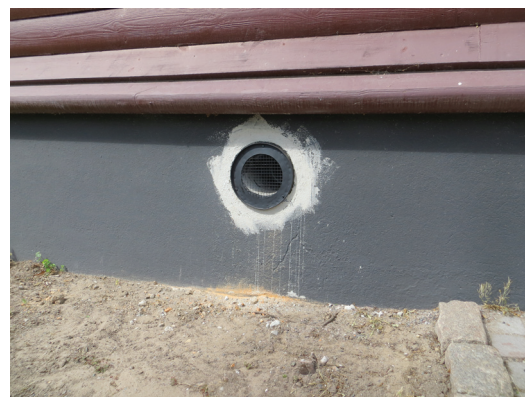
Monterad, men inte inmålad ventil.
