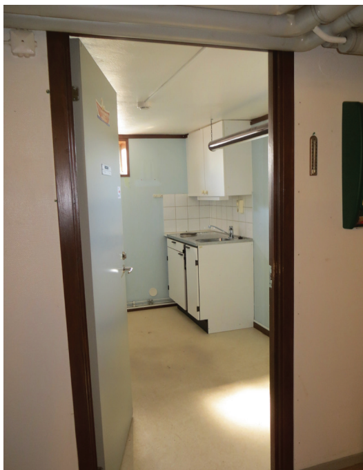
Nedan till höger: Det stora rummet inför arbetena. Luckan i bildens mitt leder in till krypgrunden.
