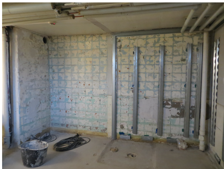
Ovan: Här pågår uppregling och montering av dagerramar. Till höger: Här har kakelskiktet rivits och uppreglingen påbörjats.
