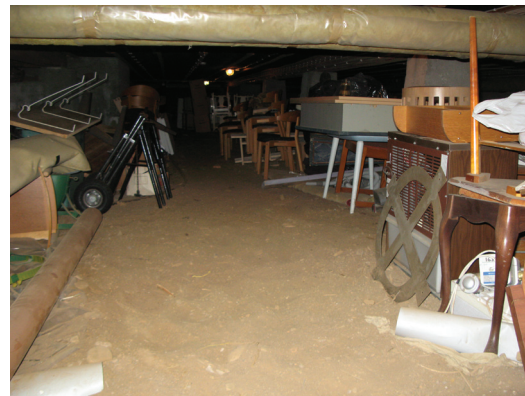
Den ostädade kryppgrunden inför arbetena.
