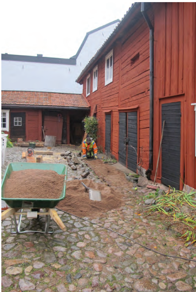
Återläggningen av kullerstensbeläggningen.
