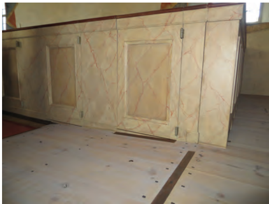
Rampen mellan mittgången och koret. Här har kontrastmålningen gjorts upptill, nedtill och vid bänkdörrarna.
