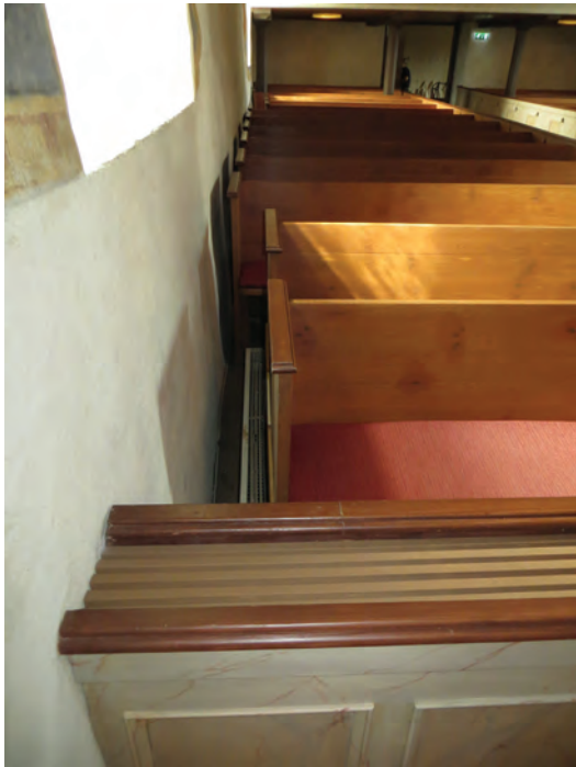
Ovan: Bänkarnas lägen utefter den södra väggen inför ombyggnaden.
