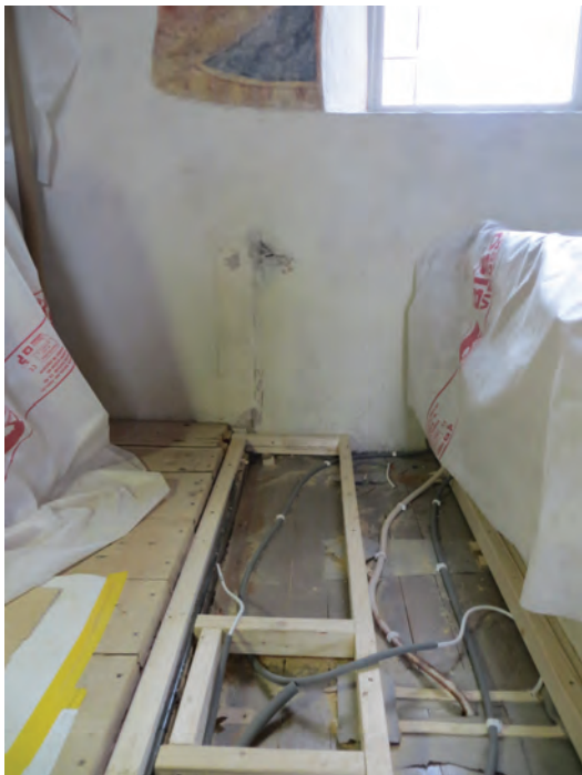
Ovan: Här har de främsta bänkarna tagits bort och uppregling pågår för att förlänga korgolvet mot bänkskärmens nya läge.
