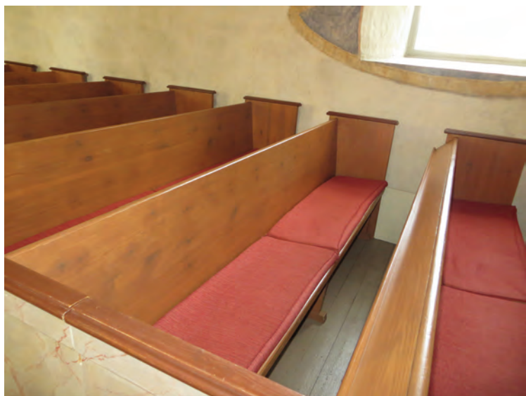
Bänkarna i det norra bänkkvarteret inför ombyggnaden.
