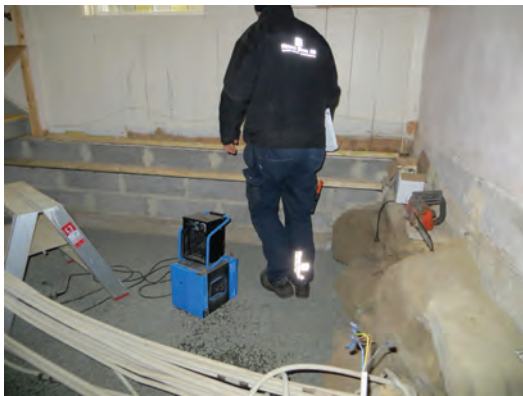
Här pågår murning av vapenhusets nya sockel. Markytan har täckts med makadam.
