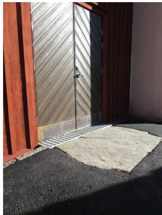
Till vänster: Entrén till vapenhuset efter att släntningen och den nya asfalten närmast ingången lagts. Ovan: Asfalten, den återanvända stenhällen och skrapgallret framför entrén.
