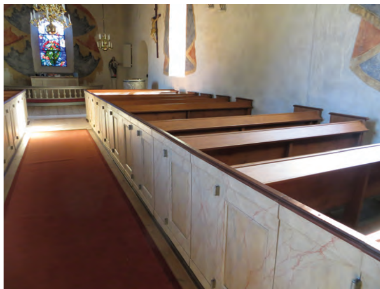
Mittgången med mattan inlagd och den nya rampen mot koret. Till höger syns även den borttagna bänken.
