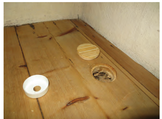
Ovan: Sektion av golvkonstruktionen i ett bänkkvarter med smalt spontgolv överst och äldre golvbrädor under detta.
