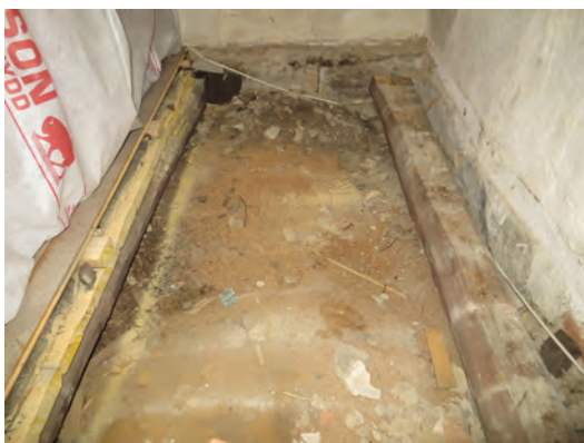
Här har golvet i den bakre delen av kyrkorummet öppnats upp. Därefter företogs rensning av organiskt material och återställning.
