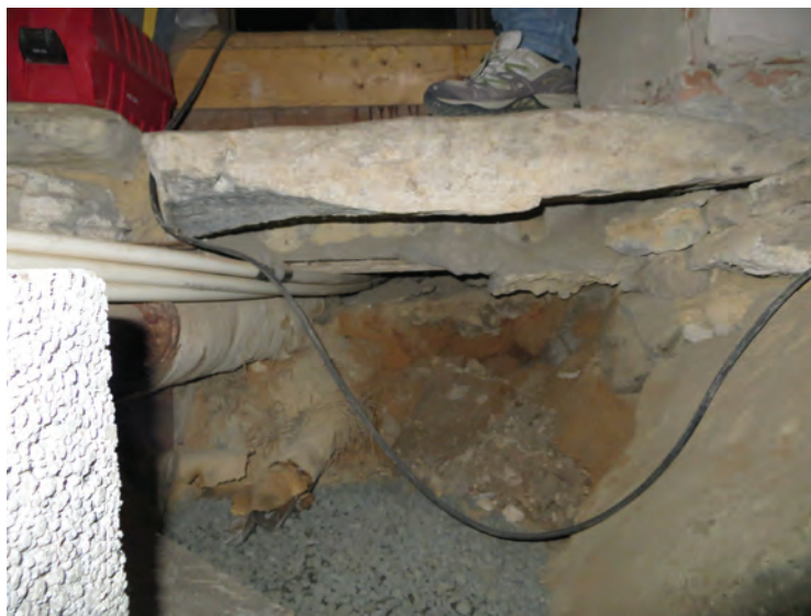
Ovan: Den nya inspektionsluckan i vapenhusets golv. Till höger: Under tröskelstenen mellan vapenhuset och kyrkorummet fanns äldre rör som tagits ur bruk. Här gjordes de erforderliga rör- och kabeldragningarna.
