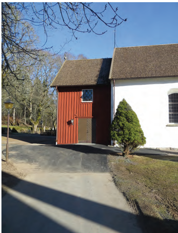
Till vänster: Entrén till vapenhuset efter att släntningen och den nya asfalten närmast ingången lagts. Ovan: Asfalten, den återanvända stenhällen och skrapgallret framför entrén.
