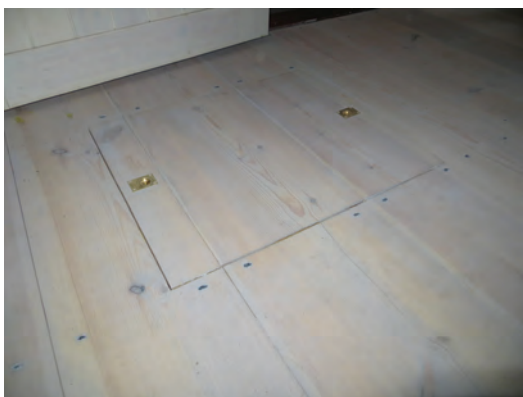
Ovan: Den nya inspektionsluckan i vapenhusets golv. Till höger: Under tröskelstenen mellan vapenhuset och kyrkorummet fanns äldre rör som tagits ur bruk. Här gjordes de erforderliga rör- och kabeldragningarna.
