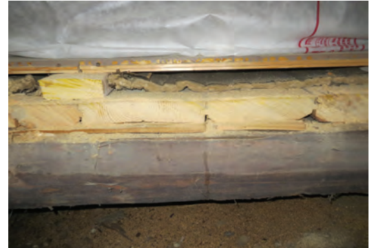
Ovan: Sektion av golvkonstruktionen i ett bänkkvarter med smalt spontgolv överst och äldre golvbrädor under detta.
