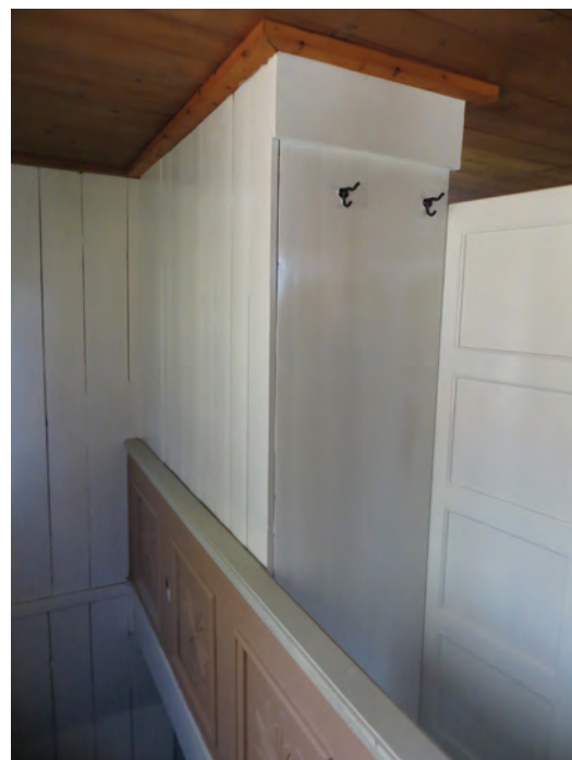
I rummet över vapenhuset fanns ett fristående skåp som inrymda el-centralen. Detta skåp utvidgades mot norr så att den byggdes mot ytterväggen. Allt målades in i befintliga kulörer.
