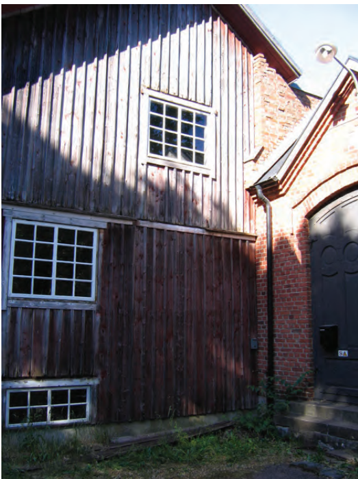
Kvarnens sydfasad före åtgärd.
