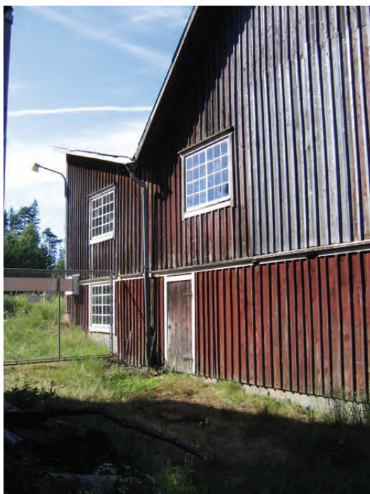
Ovan: Sågens södra gavel före åtgärd. Till höger: Sågens norra respektive västra fasad.
