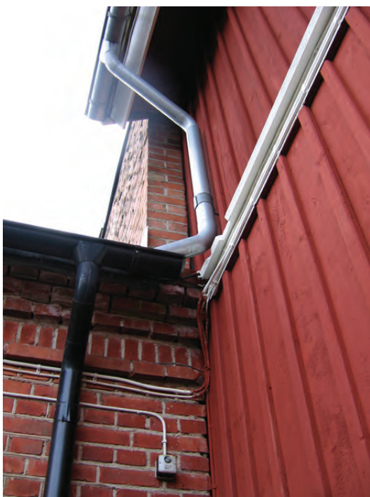
Detalj ny lösning av avvattningen, kvarnens östra fasad.
