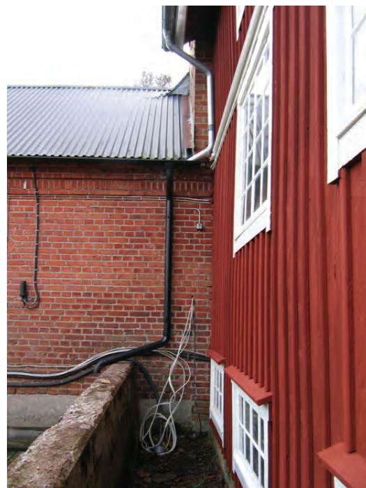
Vattnet från takavvattningen leds ut från fasaden.
