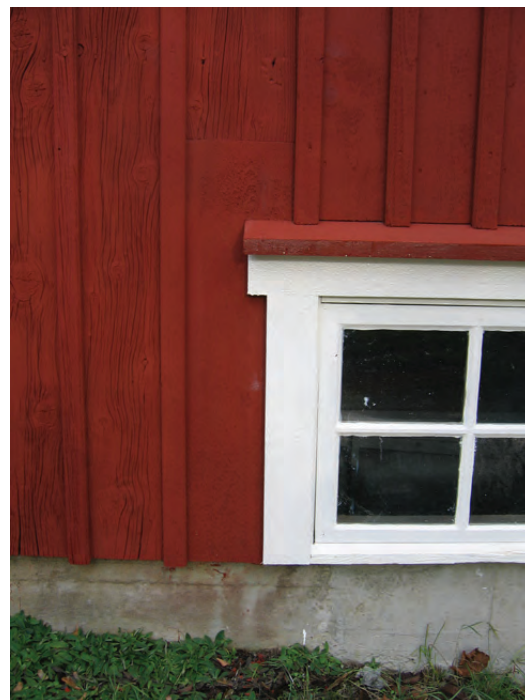
Detalj, panelbrädan vänster om fönstret är delvis bytt. Ny droppbräda över fönster monterad.
