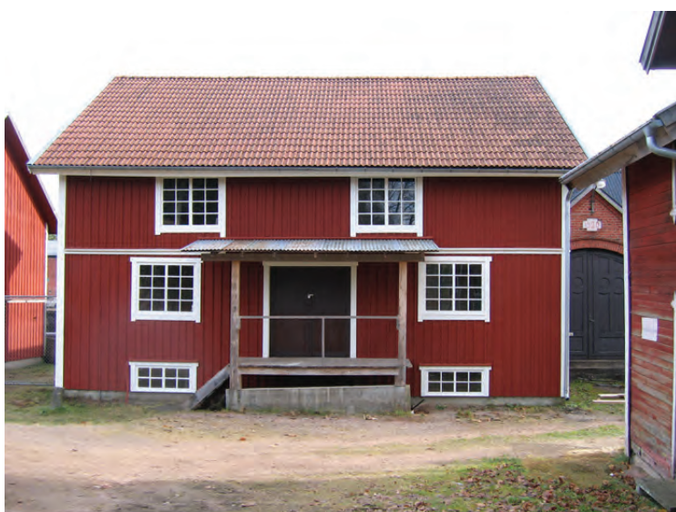
Kvarnen västra fasaden.
