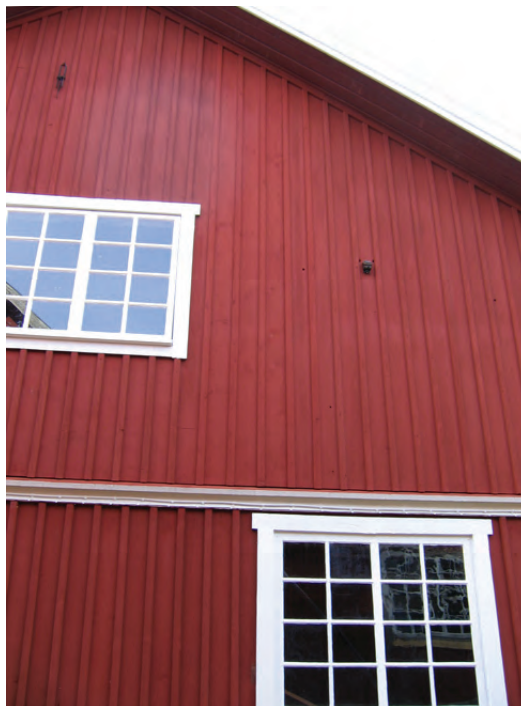
Kvarnens norra fasad, detalj.
