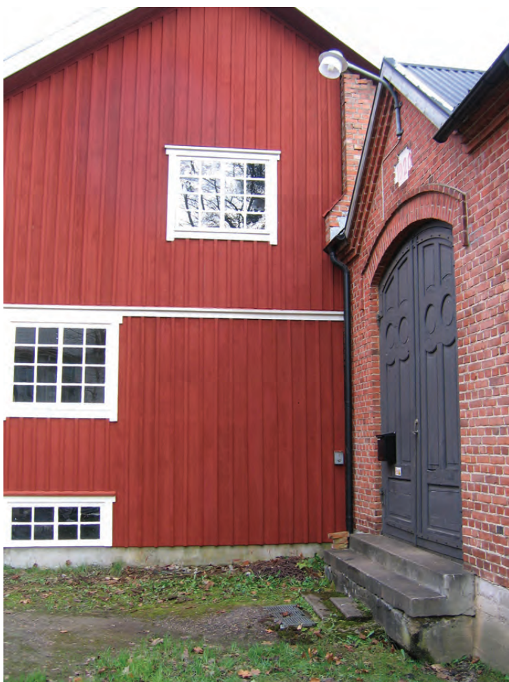
Detalj, panelbrädan vänster om fönstret är delvis bytt. Ny droppbräda över fönster monterad.
