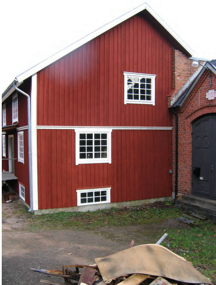
Kvarnens södra fasad.
