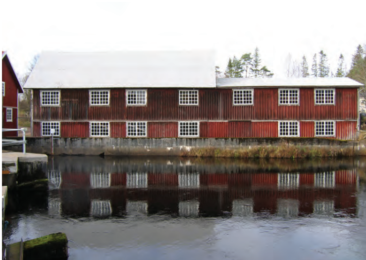
Sågens fasad mot öster. Arbetena på denna fasad kunde inte inrymmas i den aktuella etappen.
