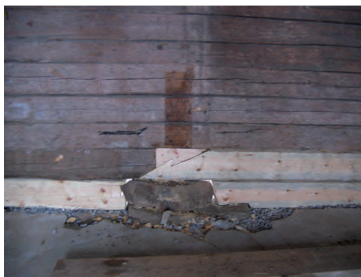
Timmerlagningar gaveln mot ladugården, den nedre timmerstocken är en fyllnadsbit.
