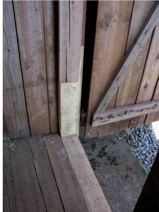
Lagning vid tröskel och angränsande stolpe i dasset.
