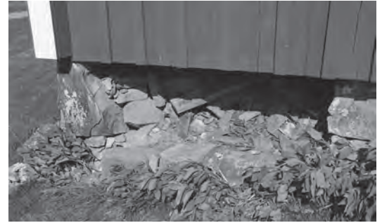
Stenar ur sockeln är flyttade inför grävning ner till fast grund.
