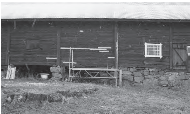
Pågående lagningsarbeten ladugårdens baksida.
