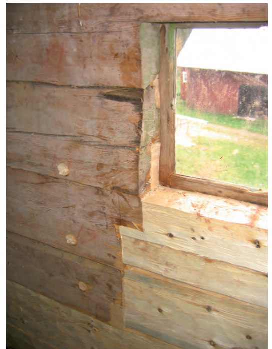
Lagningen på västra gaveln från insidan.
