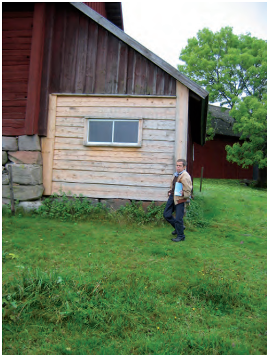
Den nytimrade väggen på det tidigare svinhuset, numera garage. Bo Ejenfors, länsstyrelsen vid delbesiktning.
