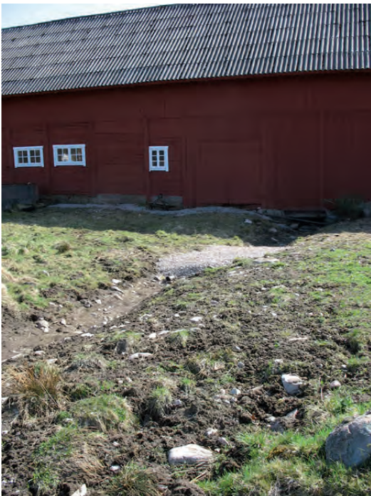
På dubbelladugårdens baksida grävdes ett dike och en trumma lades under en uppfylld övergång att få en bättre vattenavrinning.
