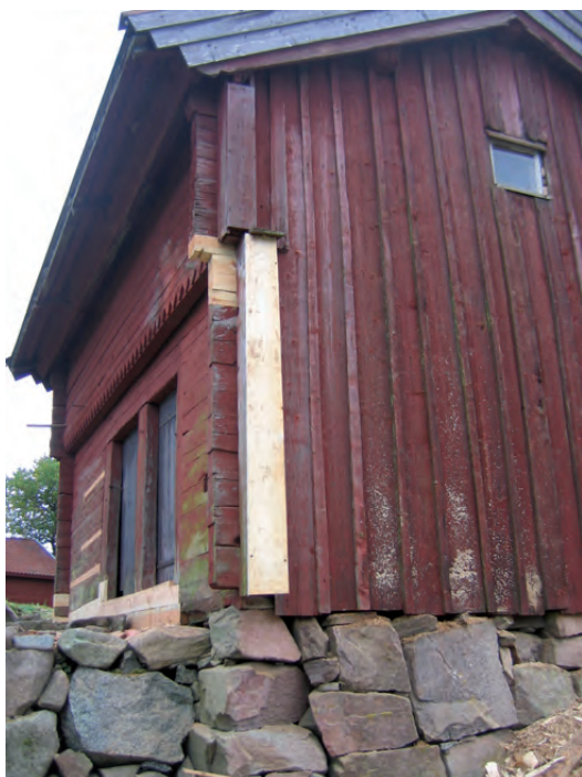
Enstaka knutskallar lagades och en ny knutlåda sattes vid knuten i väster.
