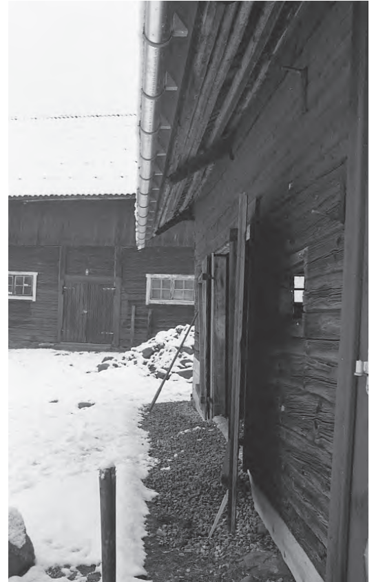
Hängrännor monterades på respektive takfall.
