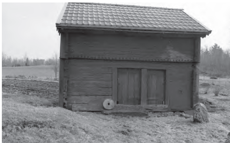
Loftboden i söder före åtgärd.
