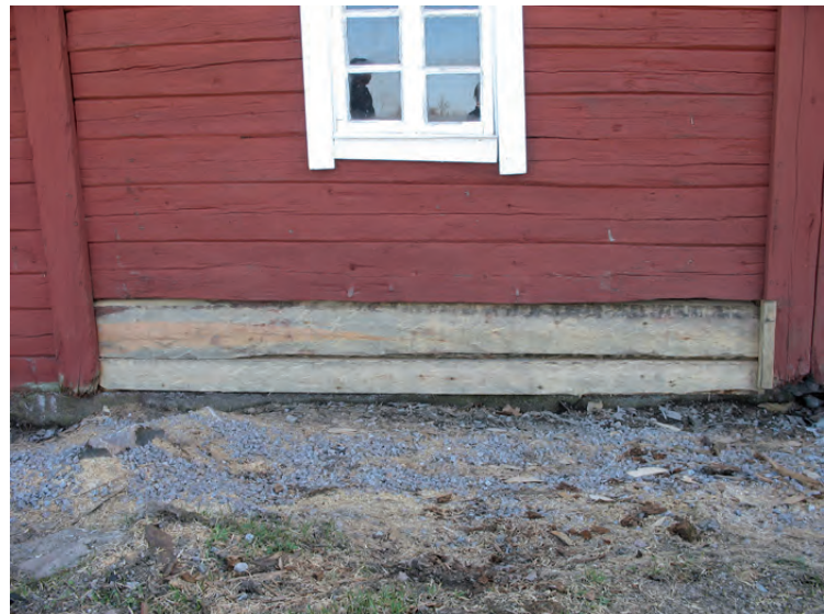
Två timmerstockar i skiftesverkskonstruktionen byttes på ladugårdens baksida i anslutning till det tidigare hönshuset.
