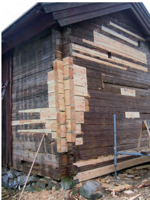
Knuten mot öster och bodens baksidan genomgick en omfattande lagning
