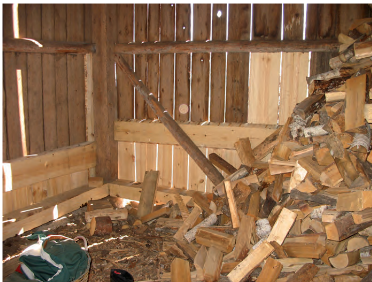
Panellagningarna från insidan. Nya tvärgående plankor monterades för att kunna lägga horisontella skarvar där de var befogade.
