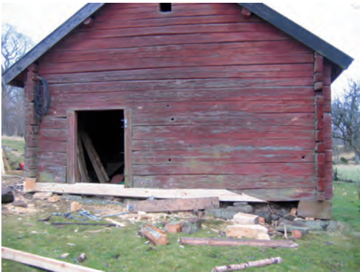
Pågående arbeten västra gaveln. Stora delar av bottensyllen är bytt. En blytskarv förbinder det nya timret med den bevarade delen av syllen.
