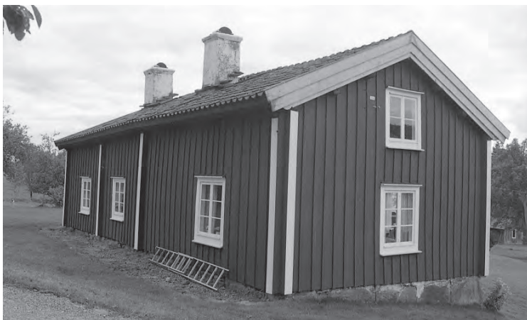
Den åtgärdade väggen hösten 2004, efter att den har rödfärgats.
