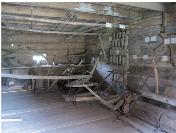
Golvet i vagnboden i norr, foto från juni 2015.
