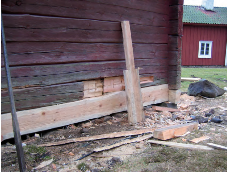
Pågående arbeten, långsidan mot nordost. Bottensyllen är bytt och urtag är gjort inför en partiell halvsulning.
