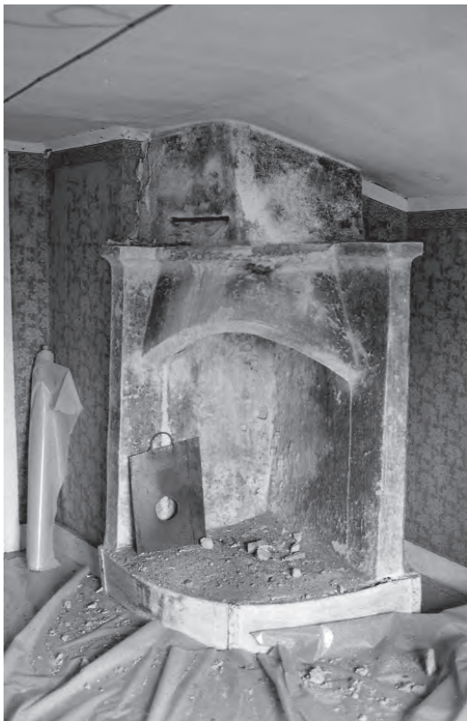
Ovan: Den öppna spisen på övervåningen före åtgärd. Ovan till höger: Den öppna spisen i salen under arbete.
