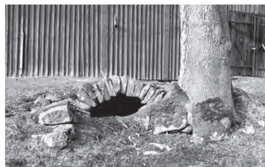
Valvbron på ladugårdens framsida.
