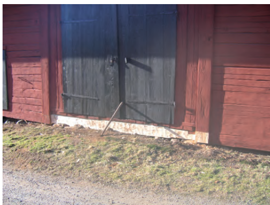
Bottensyllen i anslutning till logdörrarna byttes.
