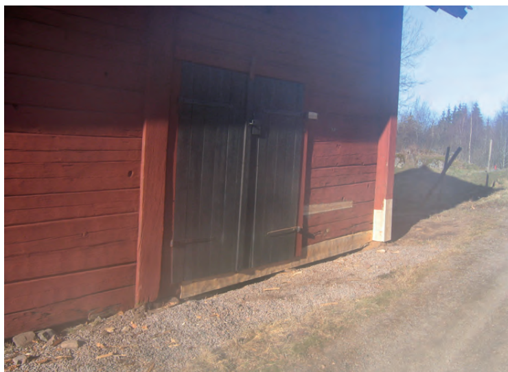
Lagning vid vagnboden och knuten mot nordväst.
