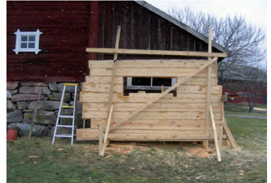
En ny väggsektion timrades i verkstad, här uppställd inför montering.
