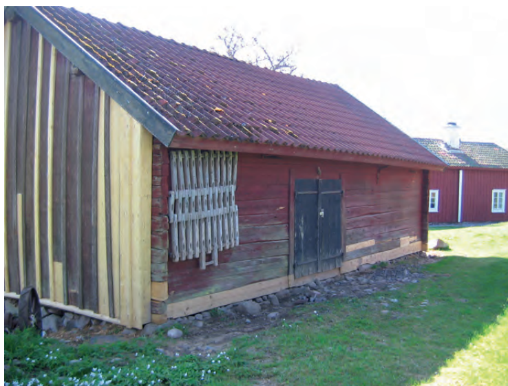
Bottensyllen byttes på långsidan mot nordost, panelen på den östra gaveln lagades.
