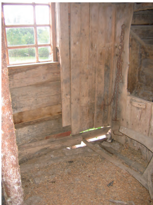
Fähuset före åtgärd.
