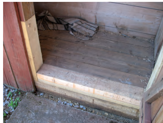
Dassets tröskel och nederdelarna av stolparna i dörrömfattningen byttes.
