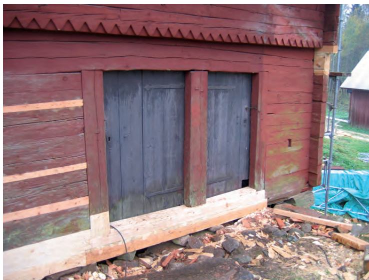
Stora delar av bottensyllen byttes på bodens framsida.
