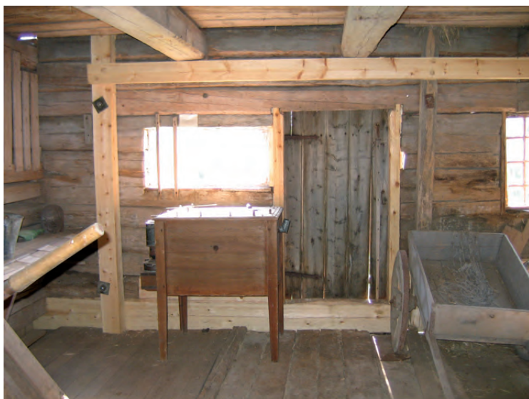
Lagning av väggen i fähusdelen.
