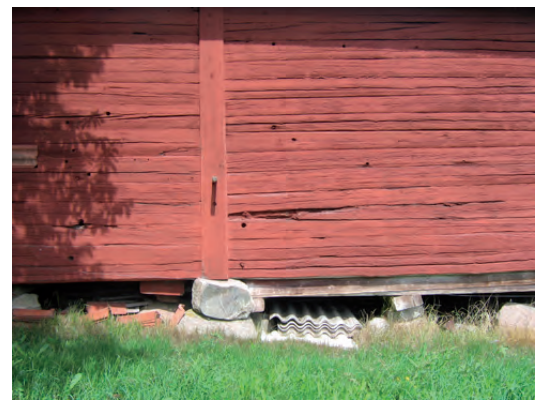
Andra väggsektionen från väster före arbetet utfördes.
