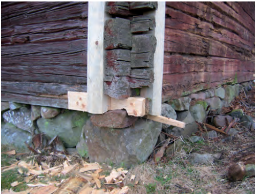
Knuten mot sydost. Följare är satta på respektive sida om knutskallarna.
