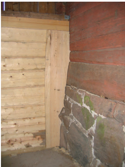
Den nytimrade väggen från insidan.
