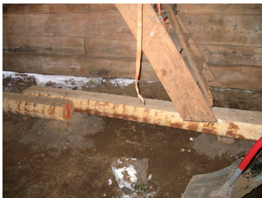
Pågående arbeten i golvbjälklaget, boden i väster.
