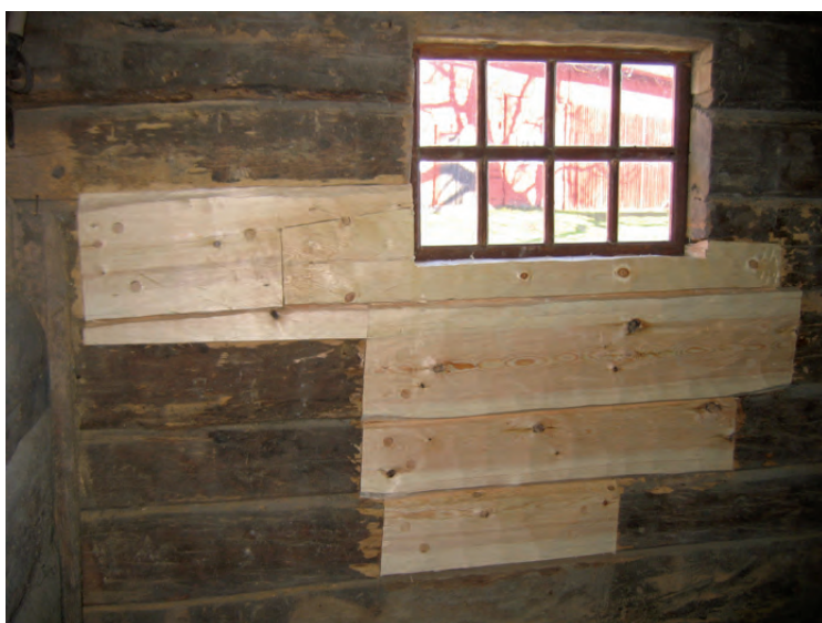
Lagning av ytterväggen i anslutning till i kätten mot norr.
