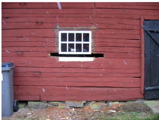
Pågående lagning under fönstret mot framsidan.
