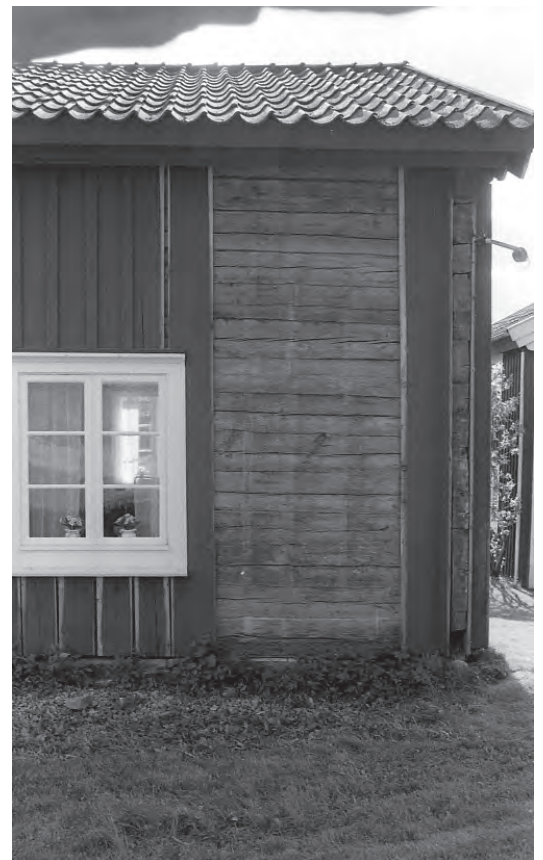
Vid besiktning i juni 2004 återstod att återspika enstaka panelbräda. Den bytta läkten var ännu inte målade.
