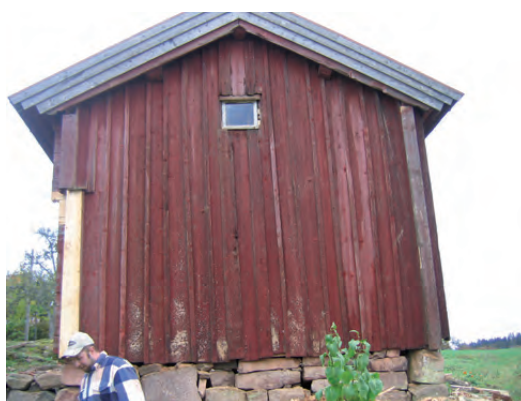
Västra gaveln efter att panelen har återställts.
