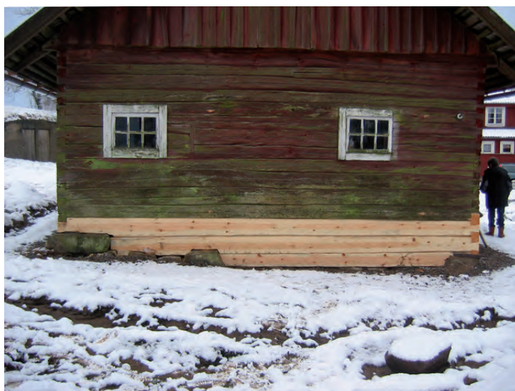
Timmerlagningar gaveln mot ladugården, den nedre timmerstocken är en fyllnadsbit.
