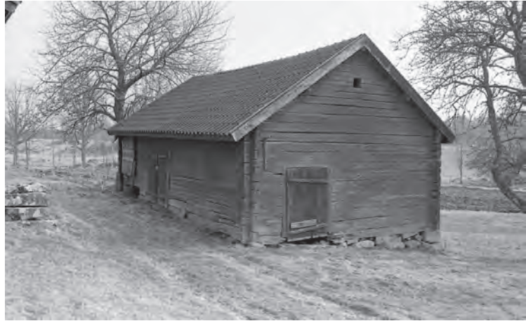
Vagnboden sydost om farfarsstugan före åtgärd.
