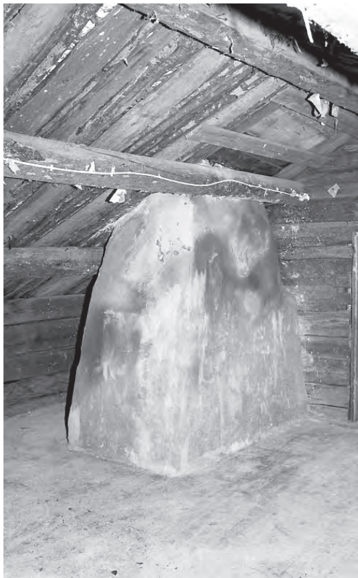
Murstocken på vinden är lagad mot taket och omputsad.
