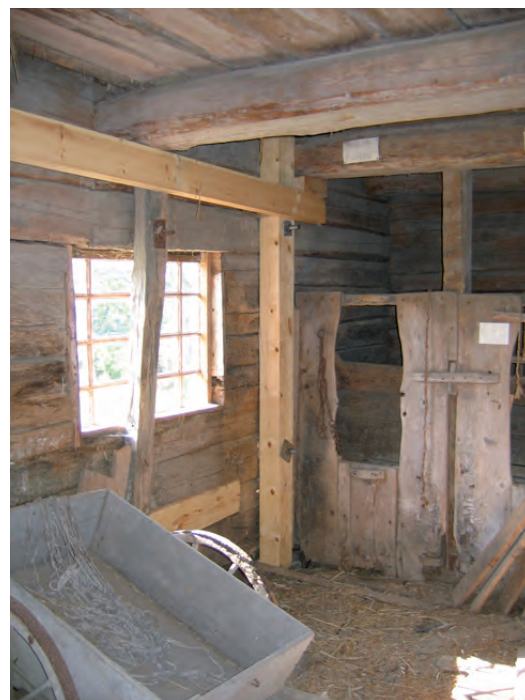
Lagning och förstärkning av väggen i anslutning till båsinredning.
