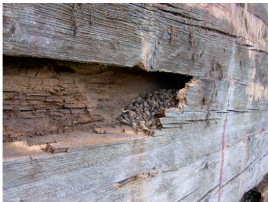
Skador orsakade av möss eller råttor, till vänster i bild, ett upplag av gamla körbärskärnor.
