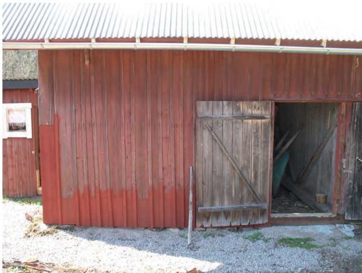
Den nystrukna rödfärgade panelen är den del som är bytt.
