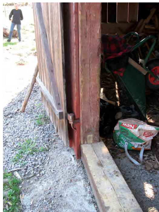
Tröskeln in till vedboden byttes.
