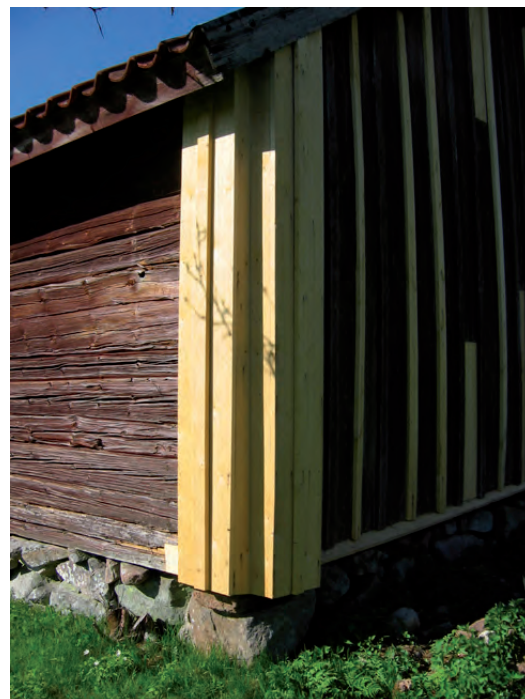
Knuten i sydost förstärktes med följare och byggdes in i knutlådor.
