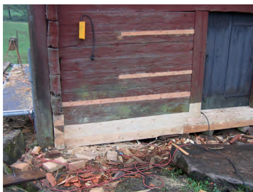
Stora delar av bottensyllen byttes på bodens framsida.
