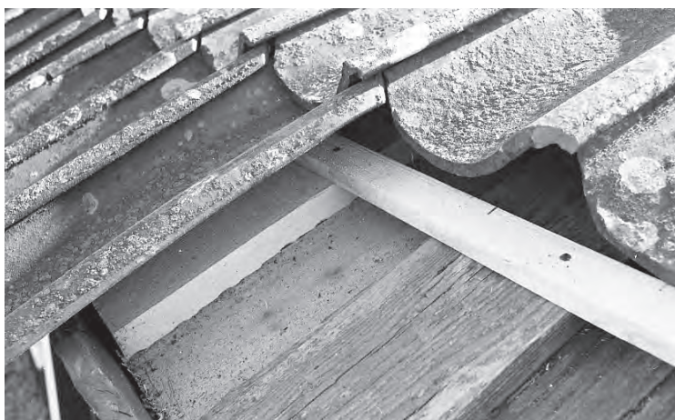
Detalj pågående arbeten tak. En läkt är bytt.
