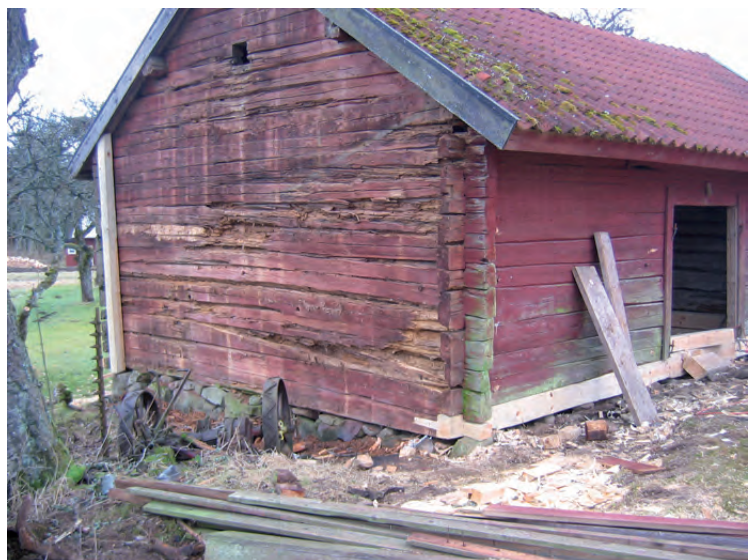
Pågående arbeten västra gaveln. Stora delar av bottensyllen är bytt. En blytskarv förbinder det nya timret med den bevarade delen av syllen.
