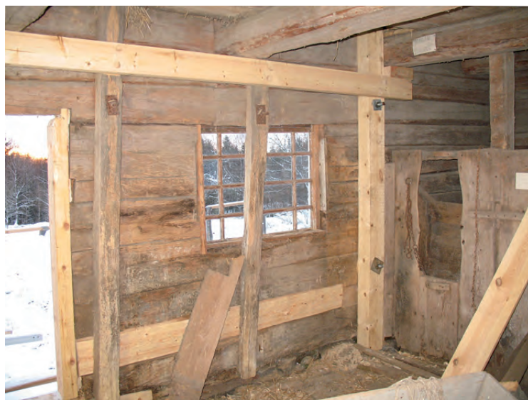
Pågående arbeten fähuset.
