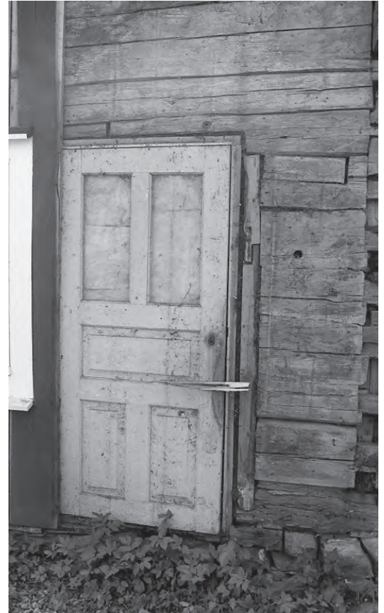
Ovan och till vänster, bilder från arbetets genomförande. De avsågade knutskallarna har gjort att väggen har förlorat sin låsning i sidled. Den gamla köksdörren fanns bevarad bakom panelen. Gåtsvärdet till höger om dörren indikerar att den ursprungliga dörren har varit lägre.
