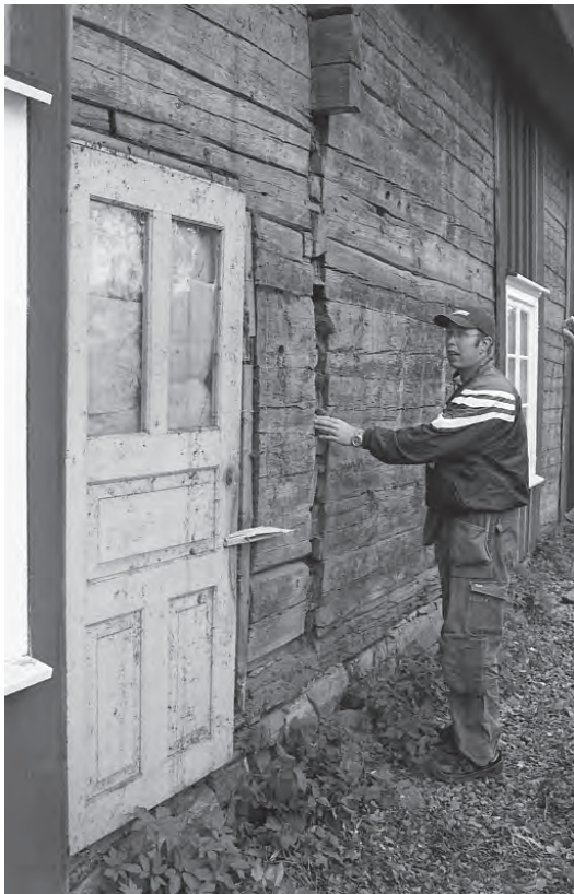
Den så kallade farfarsstugans bukiga vägg med de kapade knutskallarna inspekteras av Pierre Bosson.
