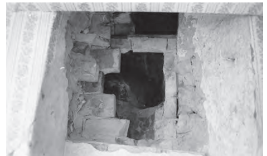
Öppnad mur mot bakugn.
