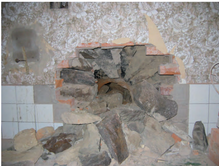
Öppnad mur mot bakugn.
