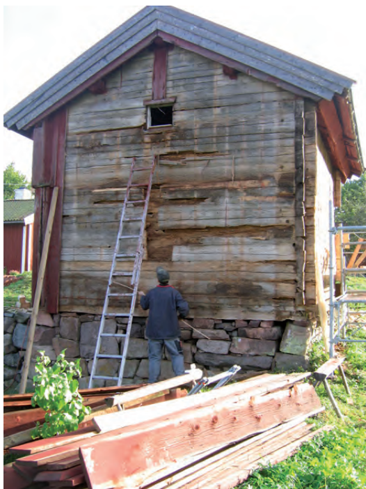
Demontering av panel, västra gaveln.
