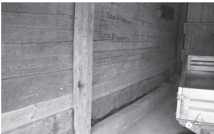
En stock byttes i mellanväggen, mellan boden och garaget. I bakgrunden syns också den nya panelen på bakväggen.
