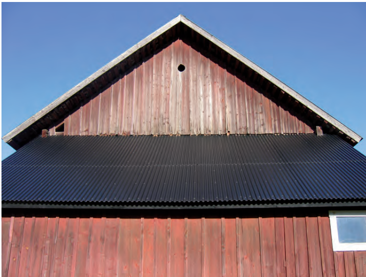
Gavelspetsen i öster hade rötskador i nederkant och bedömdes generellt vara i för dåligt skick för att kapa den och göra successiva omflyttningar.
