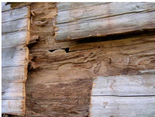
Skador orsakade av möss eller råttor, till vänster i bild, ett upplag av gamla körbärskärnor.
