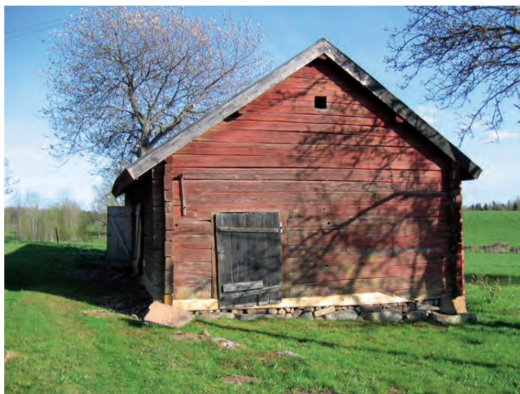
På den västra gaveln byttes stora delar av bottensyllen.
