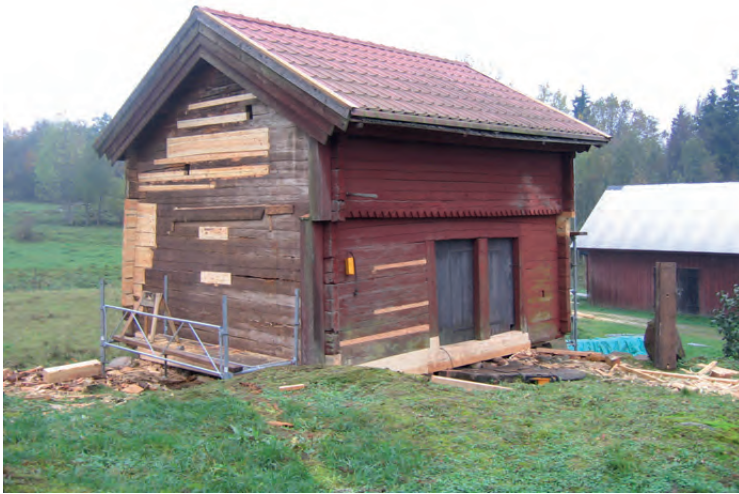
Översikt av den lagade gaveln i öster innan panelen återsattes.
