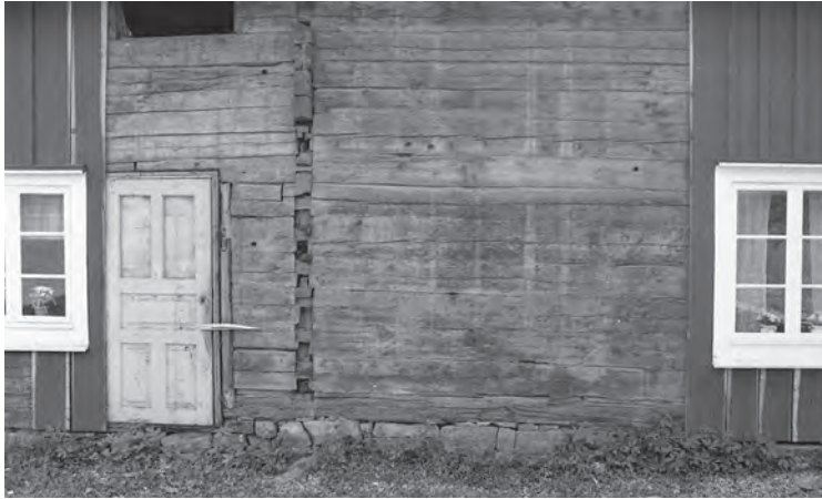
Ovan och till vänster, bilder från arbetets genomförande. De avsågade knutskallarna har gjort att väggen har förlorat sin låsning i sidled. Den gamla köksdörren fanns bevarad bakom panelen. Gåtsvärdet till höger om dörren indikerar att den ursprungliga dörren har varit lägre.
