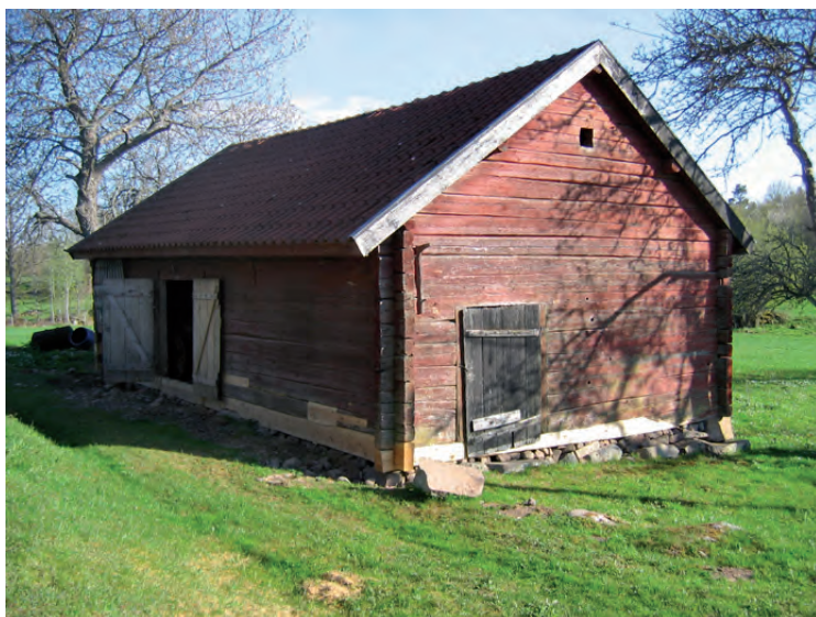
Översikt, nordöstra långsidan och västra gaveln.
