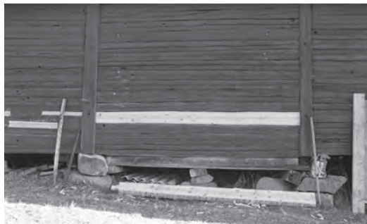
Utförda lagningar på ladugårdens baksida, andra sektionen från väster.
