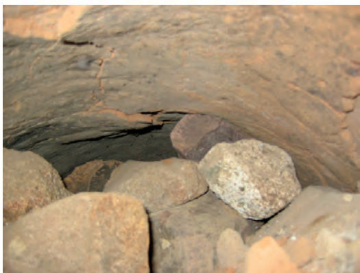
Bakugnen i köket, stenfylld men i övrigt relativt intakt.
