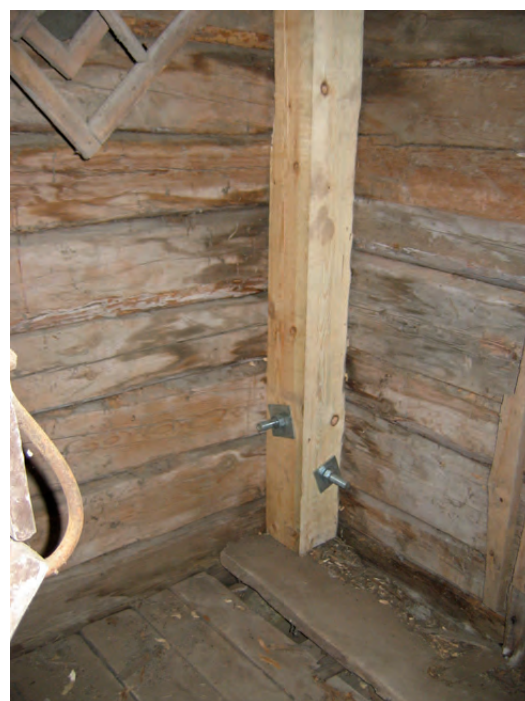
Följare sattes både ut- och invändigt i anslutning till knuten i sydost.
