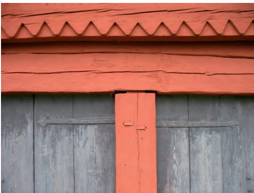
Detalj från loftboden i söder.
