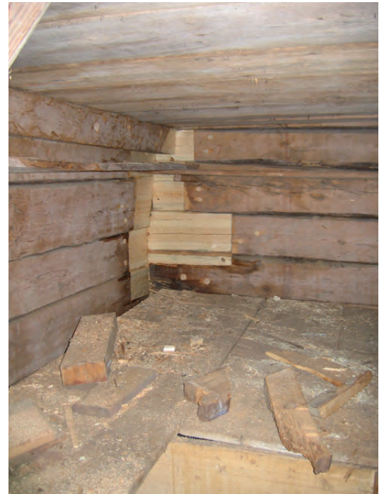
Lagningen från insidan.
