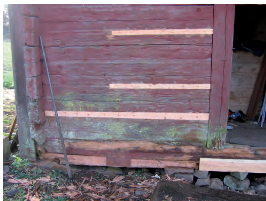
Pågående arbeten på bodens framsida.
