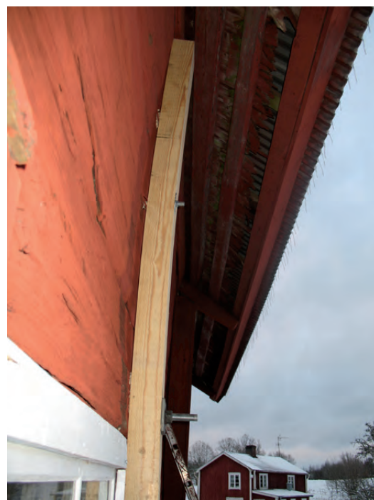
Utvändigt satt följare i fähusdelen.
