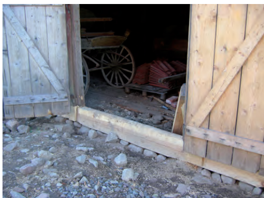
Hela bottensyllen byttes på nordöstra långsidan, här utgör den tröskel vid boddörrarna.
