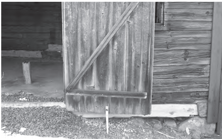
En ny bottensyll sattes på framsidan.
