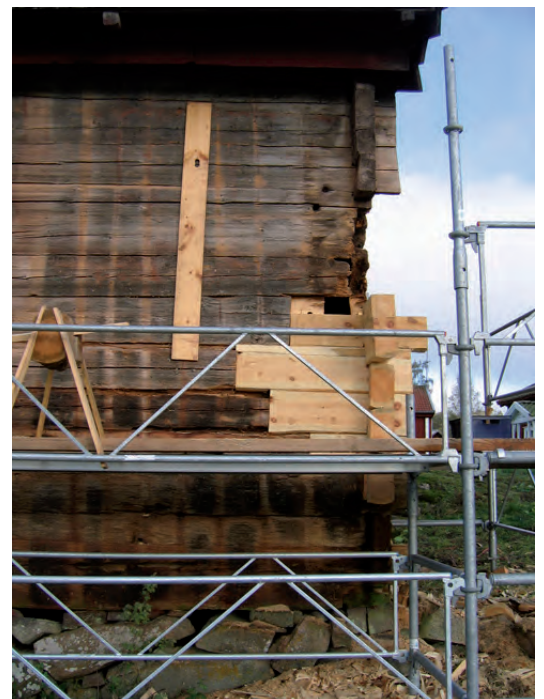
Ovan: skador och lagning av knuten.
