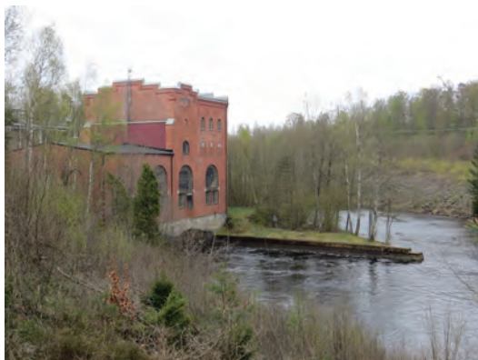
Ån Lagan söder om Sjöared ledde till drungskningsolyckor. I början av 1900-talet började Sydsvenska Kraftaktiebolaget exploatera den vattenkraft som ån skapade. Bilden visar Majenfors gamla kraftstation uppfört 1909 söder om Sjöared.
