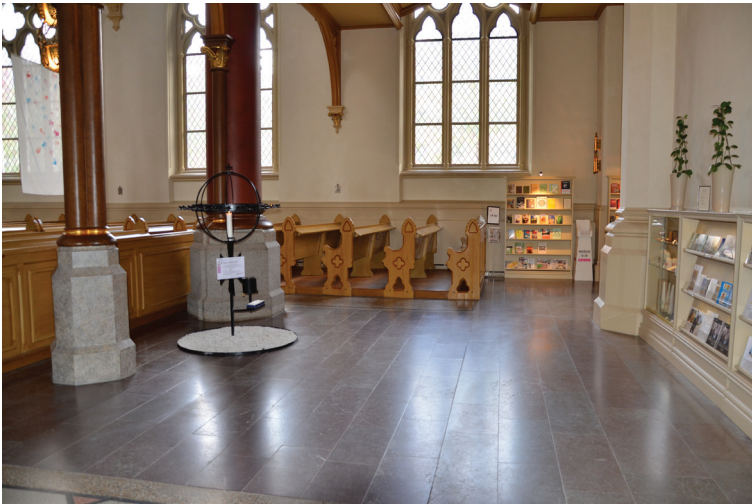
Området under läktaren inför arbetena.
