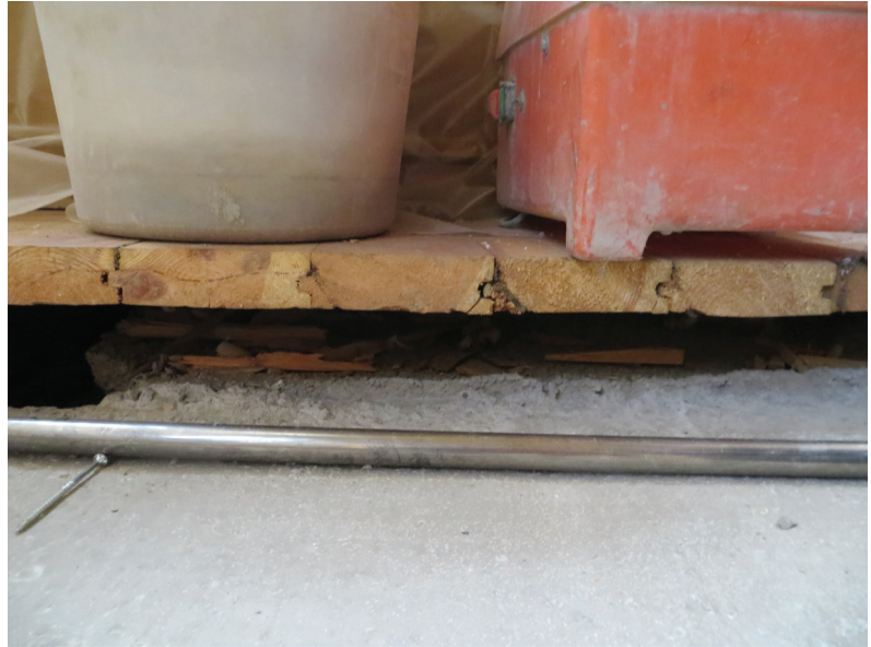
Ovan till vänster: Den befintliga inbyggnaden utefter långhusväggen öppnades upp och då framkom den ursprungliga pärlspontpanelen. Ovan till höger: Profil av bänkkvarterens golvbeläggning av spontade brädor.
