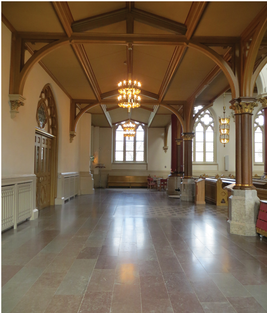
Området under läktaren sett mot norr.
