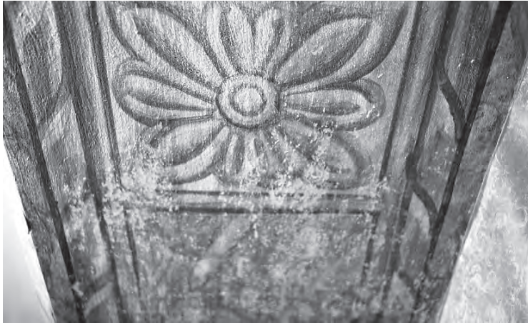
Dekorationsmåleriet i valvbågarna vid koret och läktaren hade skador i form av sprickor och krackeleringar.
