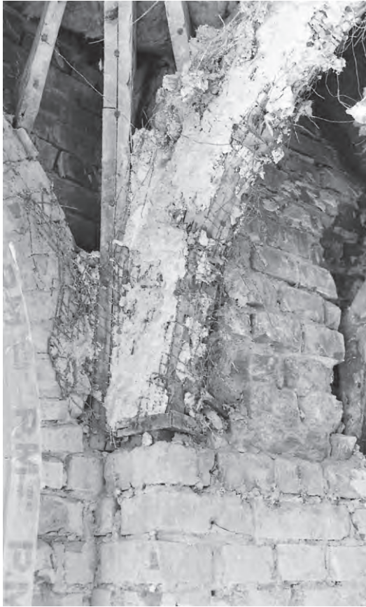
Ovan och till vänster: Valvbågarnas konstruktion framträdde när putsen knackades ned.
