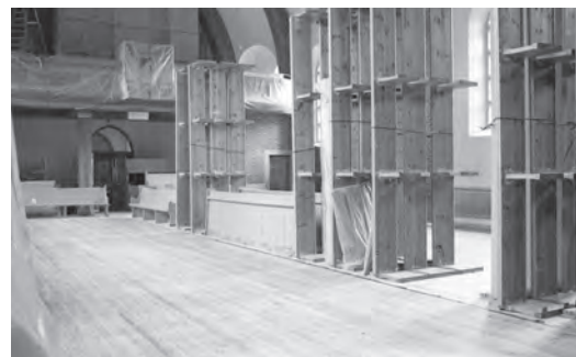
Slipning av trägolv i bänkkvarteren.
