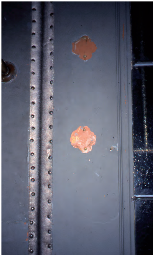
Under beslagen fanns spår av dörrarnas ursprungliga färgställning.
