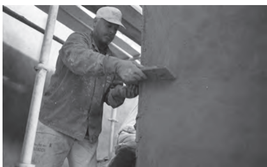
Pågående putsarbeten med muraren Stig Levinsson.
