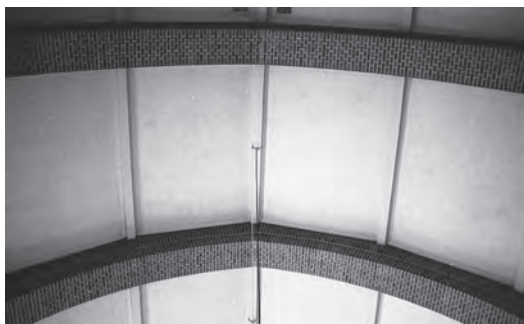
Balkarna i taket mellan tegelbågarna var inmålad i bottenkulören.
