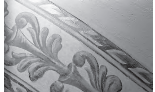
Dekorationsmåleriet i valvbågarna vid koret och läktaren hade skador i form av sprickor och krackeleringar.
