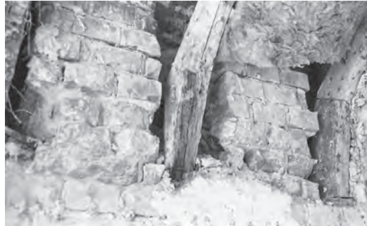
Ovan och till vänster: Valvbågarnas konstruktion framträdde när putsen knackades ned.
