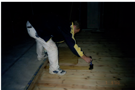
Jan Håkansson stryker trägolvet med lasyrolja.
