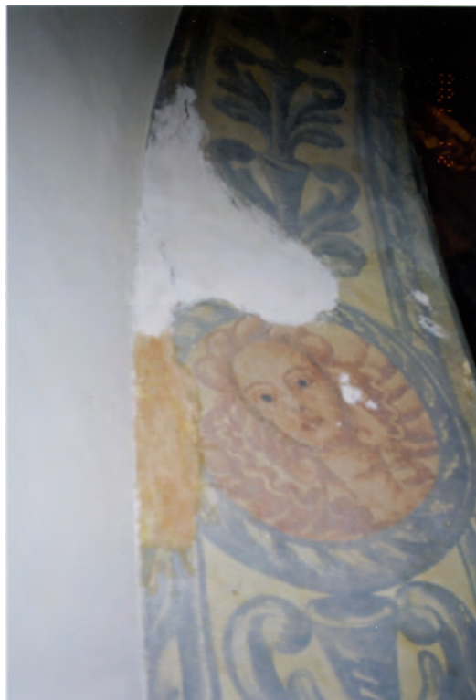
Pågående restaurering / konservering av valvbågarnas dekormåleri.
