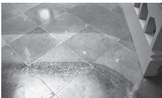
Altarringens tidigare placering syntes i golvet, då den ytan över tid inte har bonats på samma sätt som kalkstensgolvet i övrigt.
