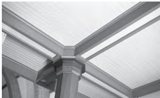
Bjälkarna i taket under läktaren målades i samma färgskala som bjälkarna i kyrksalen.
