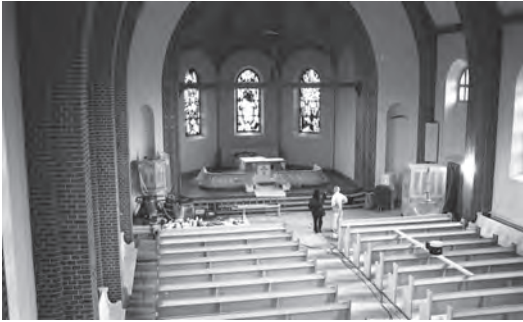
Översikt av kyrkorummet under pågående arbete.
