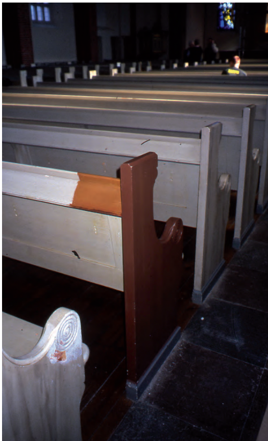
Kulörprov med en brun kulör, på gaveln närmast i bild är delar av den äldre färgsättningen framskrapad.
