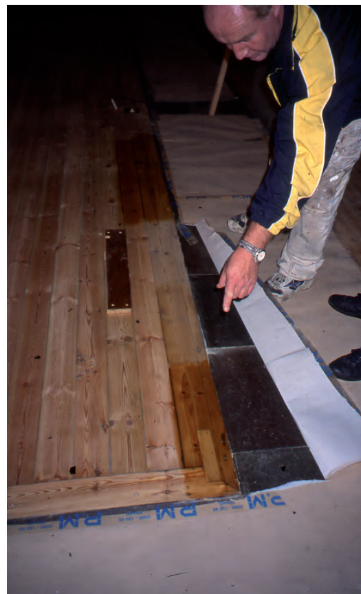
Provstrykning av trägolvet med lasyrolja. Målare Jan Håkansson visar proverna.
