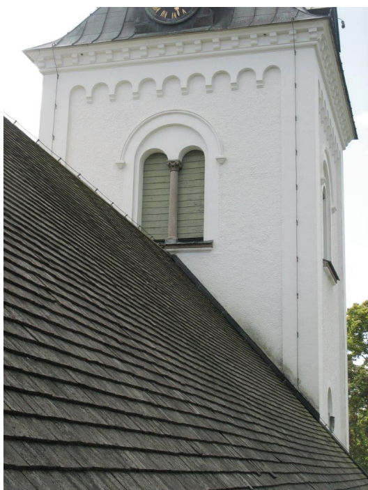
Den befintliga täckningen av sågade ekspån.
