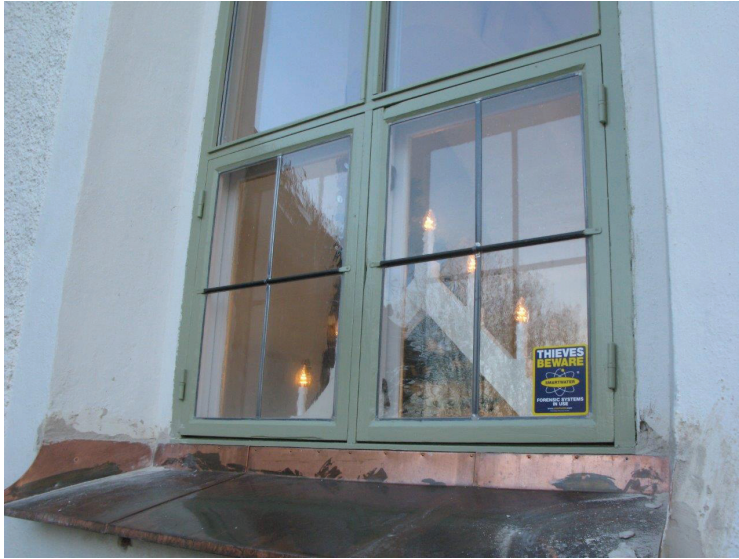
Fönster efter byte av skadade isolerglasrutor, ommålning och montering av nya kopparbleck.
