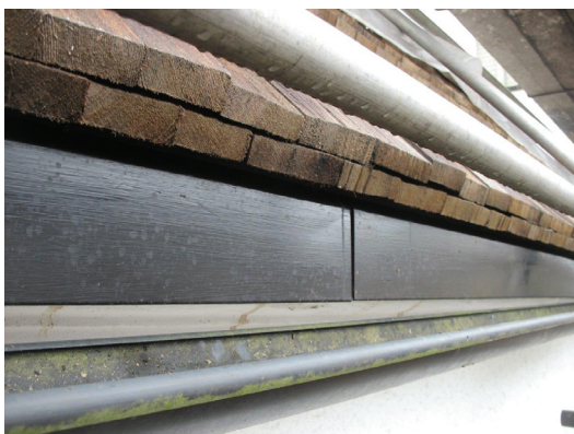
Ny spåntäckning av kluven furu på långhusets norra takfall. En droppnäsa av linoljefärgsmålad plåt har satts mellan takskägg och hängränna för att minska risken för nya putsskador på gesimsen.
