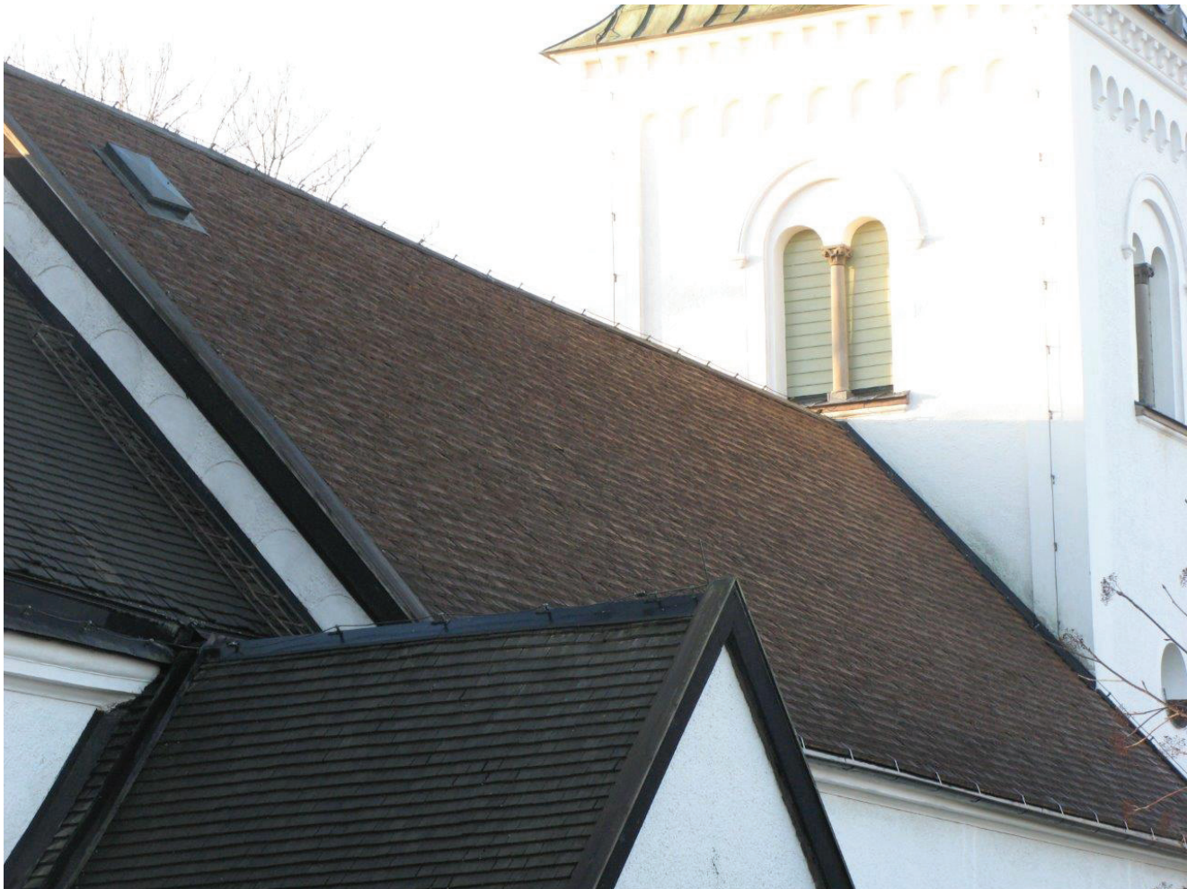
Ny spåntäckning av kluven furu på långhusets norra takfall. En droppnäsa av linoljefärgsmålad plåt har satts mellan takskägg och hängränna för att minska risken för nya putsskador på gesimsen.
