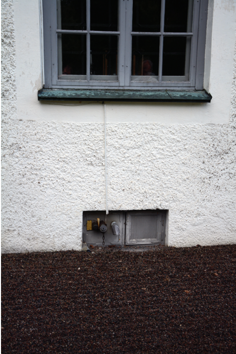
Pannrumsfönster på sakristigaveln med rör till oljetank.
