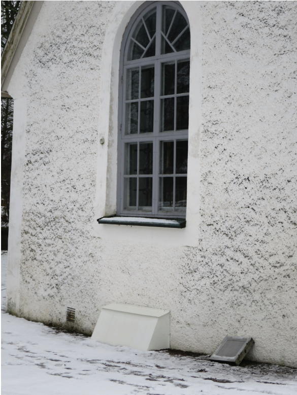
Plåtsvep för att dölja rörens passage in i pannrummet.
