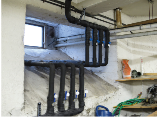
Genomföring av rören till pannrummet kunde ske under marknivå.
