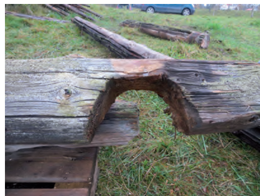
Del av väggtimret med en rännknut.
