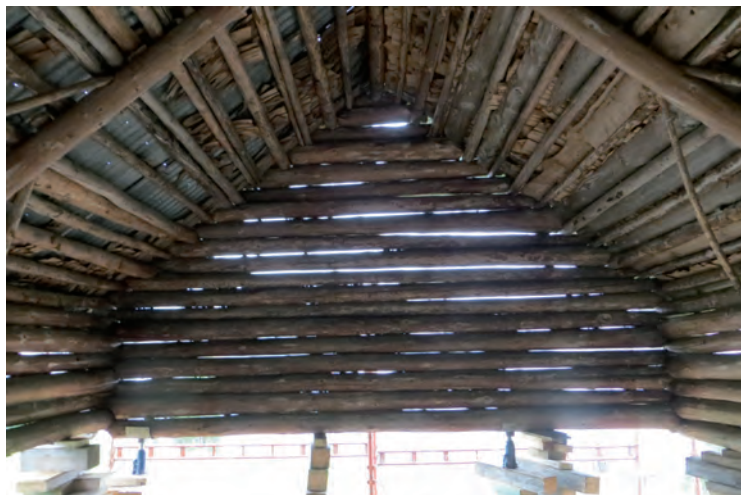
Ovan: Den östra gaveln med ingången. Till höger: Ladans konstruktion med timmerväggar, och mångåstak.
