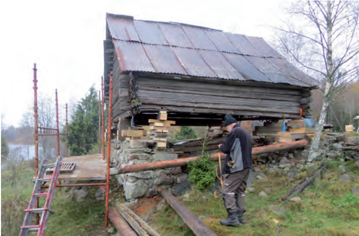
Översikt när arbetena påbörjats och ladan lyfts för att komma åt de nedre, rötskadade timmervarven. Hitom ladan står Lennart Johnsson som fungerade som projektledare.
