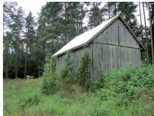
Ängsladorna i Jönköpings län kan delas in i två huvudgrupper. De timrade (överst) och de av regelverk (nedan).
