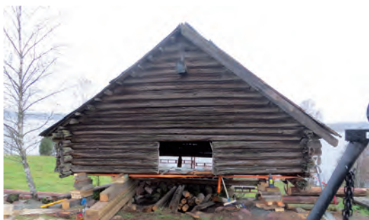
Ovan: Den östra gaveln med ingången. Till höger: Ladans konstruktion med timmerväggar, och mångåstak.
