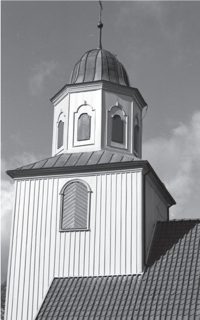
Torn och lanternin från söder.
