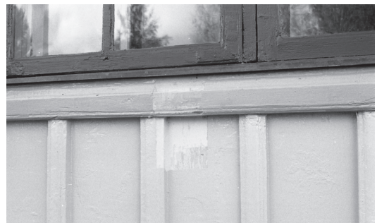
Referensyta av äldre färgsättning som sparats på norra långhusfasaden.
