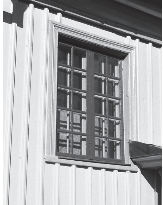
Ett av långhusets fönster efter ommålning.
