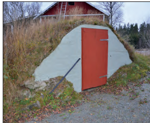
Matkällaren i gjuten betong ligger på gångavstånd från parkkaféet och förtäringsskioskerna. Lite av källarnes enkla funktionella karaktär har gått förlorat genom att betongväggen målats.
