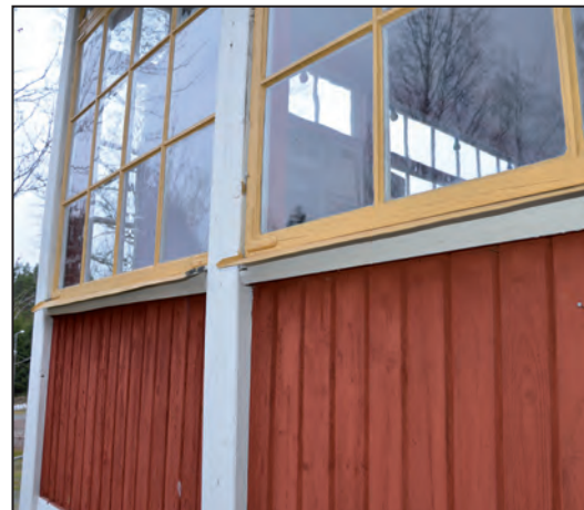
Exteriören känns genuin från 1920-talet med sina smårutade originalfönster och fasspontpanel, tillverkade på snickerifabrik. Byggnaden har dock byggts till på 1960-talet vilket skett på ett mycket välintegrerat sätt.
