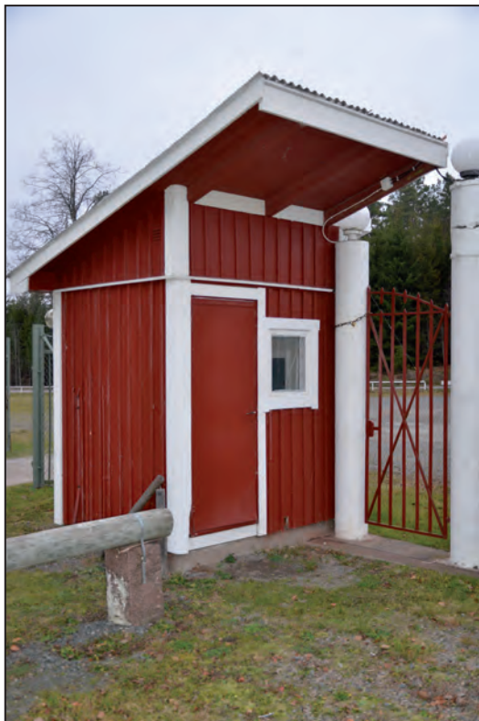
Parkentréns båda biljettkurer fick nya uttrycksfulla s k pulpettak på 1960-talet. Tidigare hade taken en välvd form i likhet med grindens namnbåge.
