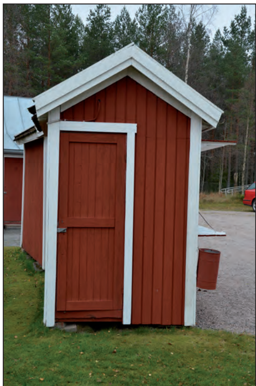
Kioskerna är uppförda av återanvänt byggmaterial från Nässjöutställningen 1922.
