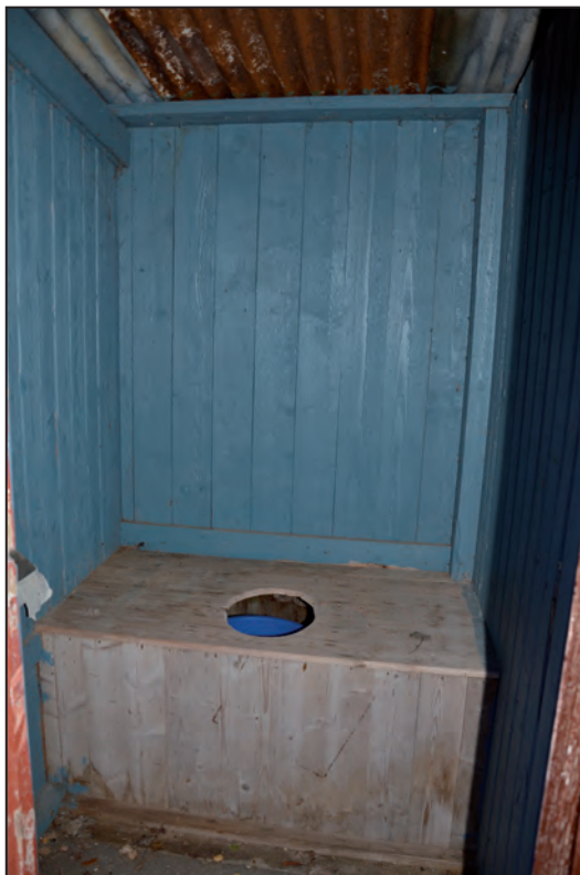
Dasset är mycket enkelt utformat utan golv och invändig tak- och väggpanel. Invändigt stod det omålat fram till på 1960-talet.
