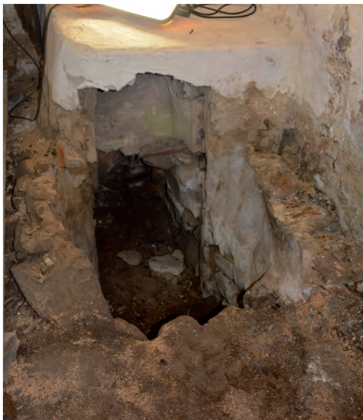
Vinkällaren före igenfyllning.
