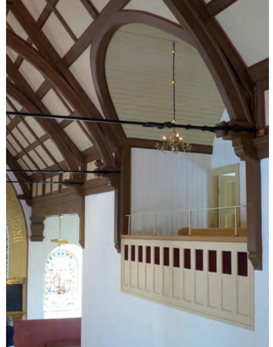
Även den kvarvarande biten av sidoläktarens bröstning restaurerades.
