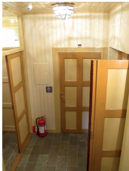
I norra vapenhuset sattes en ny mellanvägg upp för bygge av en handikappanpassad toalett.
