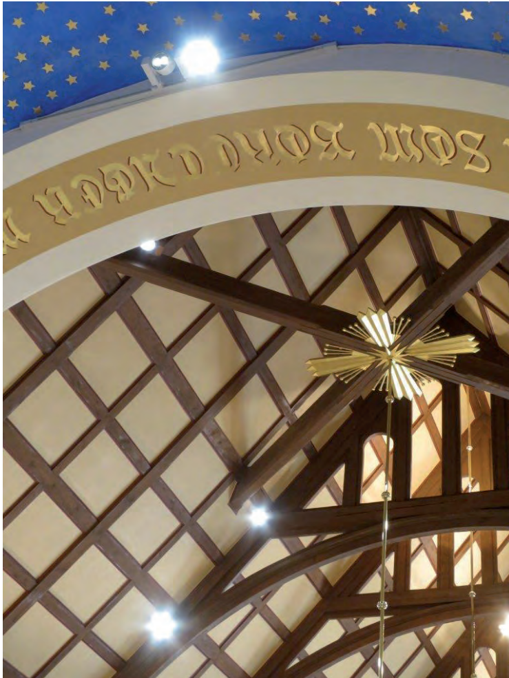
Belysningen i koret kompletterades med strålkastare för bland annat körframträdanden. I långhuset kompletterades ljuskronorna med förstärkningsljus av modell "Gunilla" från Fongs gelbgjuteri.
