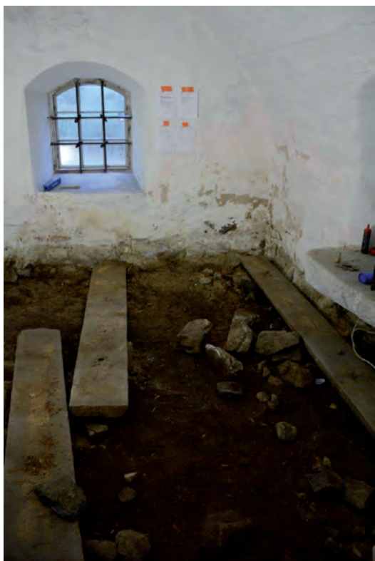
Gamla sakristian efter golvet rivning. I bild tre grova plank, kluvna på ena sidan och sågade på den andra, troligen från ett äldre golv.
