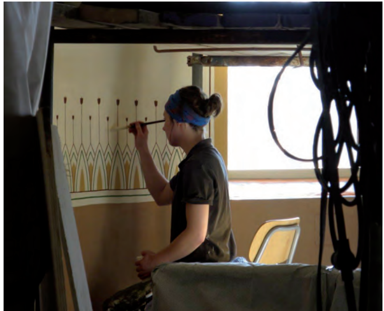
Ovan till vänster: Jan Håkansson visar uppstrukna kulörprover för projektledare Maria Williamsson. Nedan till vänster och ovan: Lisa Klasson i arbete med dekor-måleri. Färgskalan består till stor del av jordfärger och ansluter till glasmålningarna och befintliga inredningsdetaljer.
