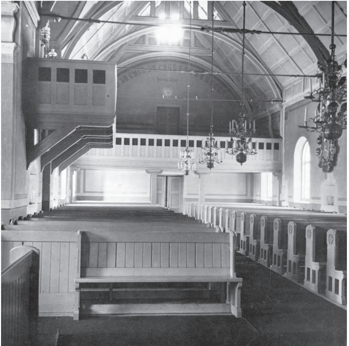
Vy mot norr, fotot troligen taget av arkitekt Erik Lundberg under restaureringen 1937. Långsidornas ljusnicher är redan uppbrutna och takfälten har förminskats samt klätts med masonit. Notera även gavelns bibelord. ATA.
