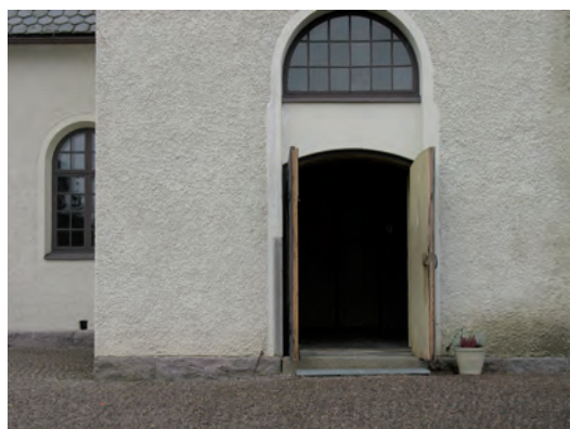
Grusgången från norra entrén till västportalen hårdgjordes och täcktes med stenmjöl. Ytan kring porten förhöjdes, asfalterades och täcktes med samma stenmjöl. Foto nedan före åtgärd.
