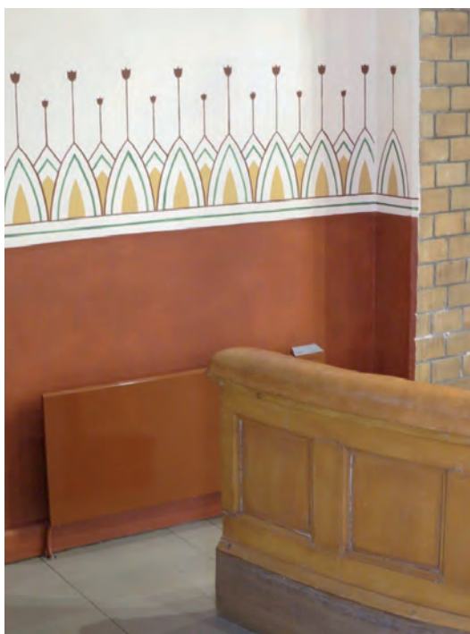
De nya väggmonterade radiatorerna lackerades i bröstningens kulör.
