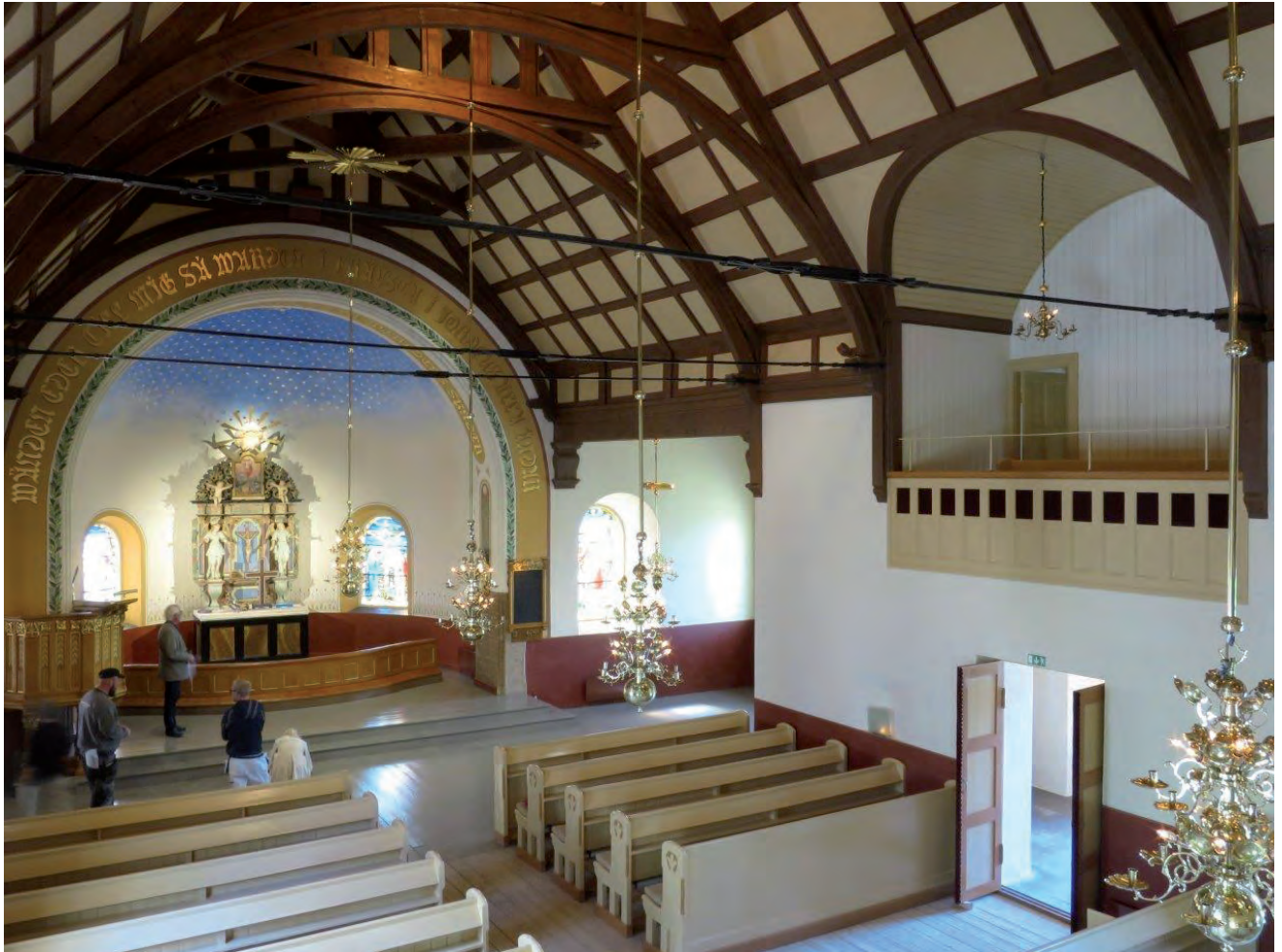
Kyrkorummet sett från norr efter avslutade arbeten. Bänkinredning, läktarbröstning och takfält har återfått 1906 års färgskala, dekorationsmåleriet i koret har rekonstruerats.
