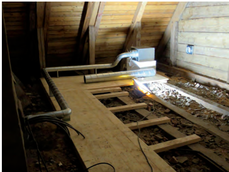
Frånluftsfläkt under installation på vinden över östra korsarmen.
