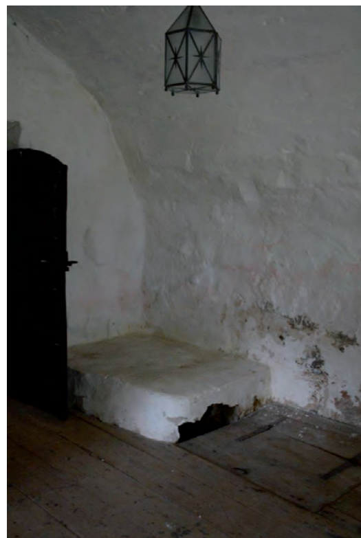
Gamla sakristians sydvästra hörn med nedgången till vinkällaren före åtgärd.
