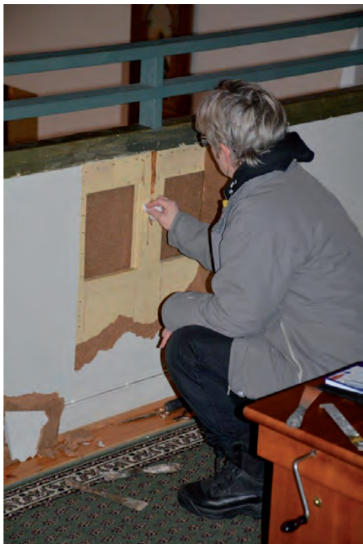
Målarmästare Anne Håkansson rengör en bit av den framtagna läktarbröstningen från 1905.
