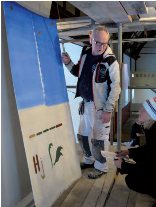
Ovan till vänster: Jan Håkansson visar uppstrukna kulörprover för projektledare Maria Williamsson. Nedan till vänster och ovan: Lisa Klasson i arbete med dekor-måleri. Färgskalan består till stor del av jordfärger och ansluter till glasmålningarna och befintliga inredningsdetaljer.
