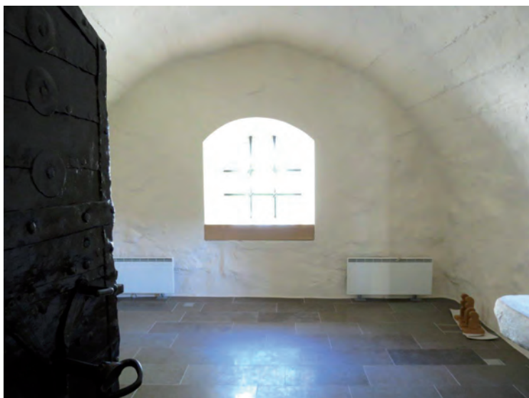
Nygamla sakristian med nytt golv av kalksten, altare i fönsternischen och nystrukna väggar, brutna med järnvitriol i likhet med äldre färgskikt.
