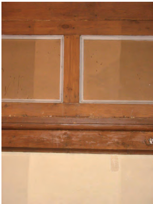
Rengöringsprov på tak och vägg.
