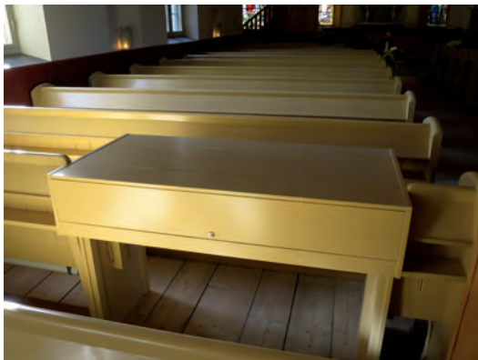
Manöverpulpiten flyttades och byggdes in i en av bänkraderna.
