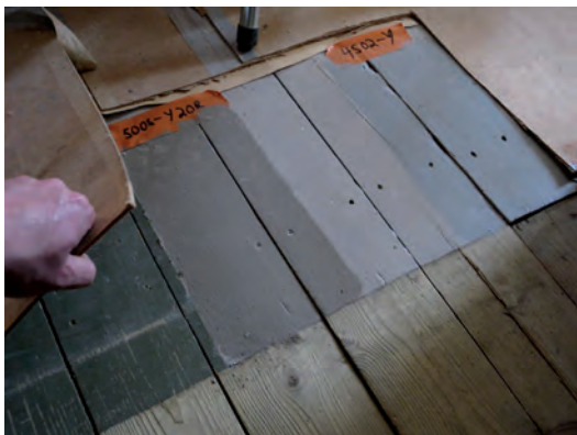
Kulörprover för golvmålning uppstrukna. Till vänster den befintliga kulören.
