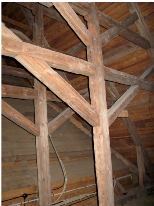
Ett av få medeltida inslag i dagens kyrka. Här ses två av fyra senmedeltida takstolar av ”kungstyp”, som står över östra korsarmen, en del av långhuset i medeltidens kyrka. Troligen tillkom detta taklag i samband med senmedeltida valvslagning. Få liknande taklag är kända i länet, däribland i Askeryd och Höreda kyrkor.
