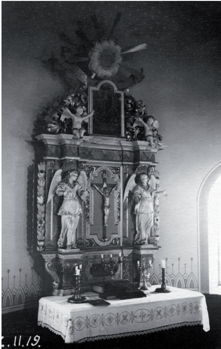
Den hårdhänt restaurerade altarpopsatsen. Notera den målade jugendfrisen över väggens tegelbröstning. JLM.
