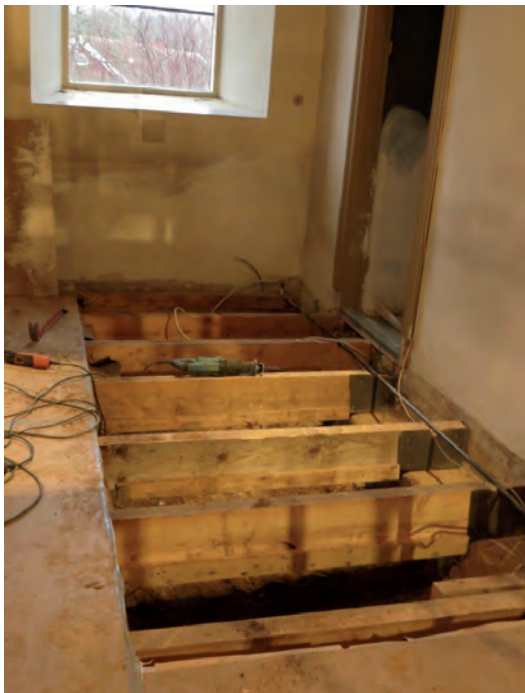
Svampangripna bärlinor i västra korsarmen utbytta.
