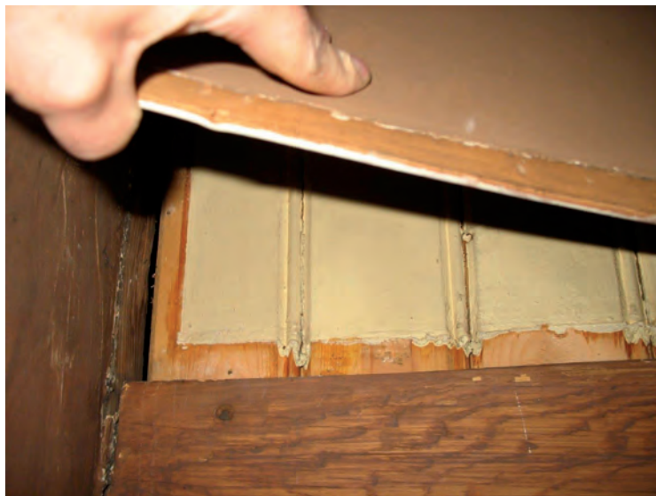
Under takfältens masonit sitter pärlspont från 1905, målad med linoljefärg bruten med obränd terra, vilket visade sig vara den huvudsakliga kulören på inredningen.
