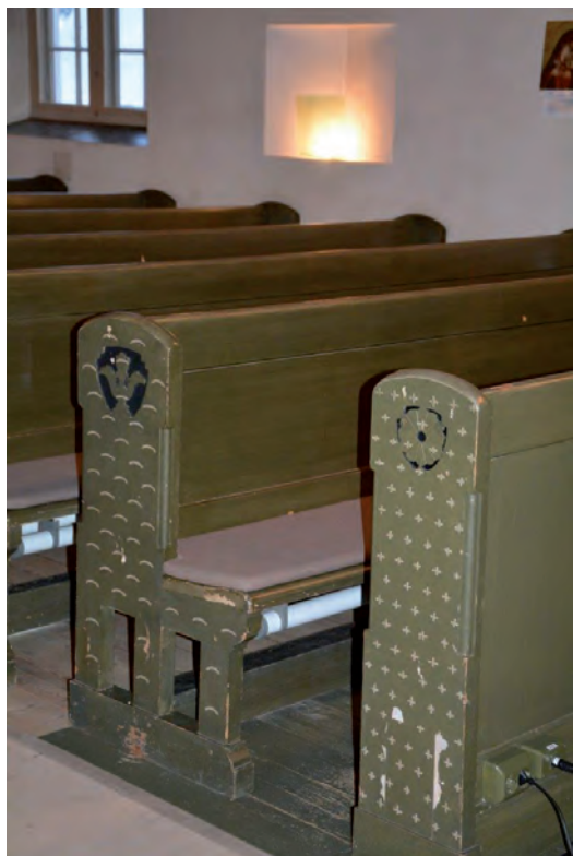
Bänkarna ommålades senast 1951 eller 1957, det är oklart om man då behöll 1937 års kulörer. Kraftig flagning.
