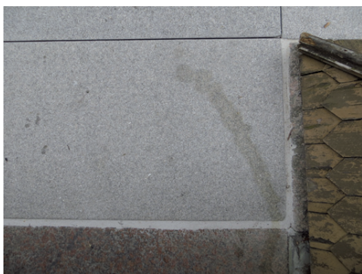
Rampen i mötet med den ursprungliga trappan.
