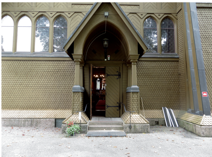
Entrén före åtgärd. Den tidigare rampen står lutad mot sockeln till höger i bild.
