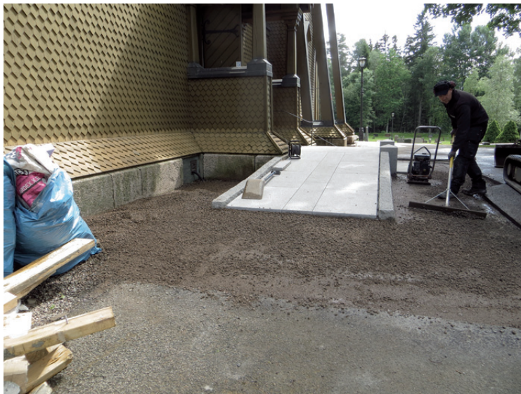
Pågående arbete. Rampen är satt, uppfyllnad med naturgrus pågår.
