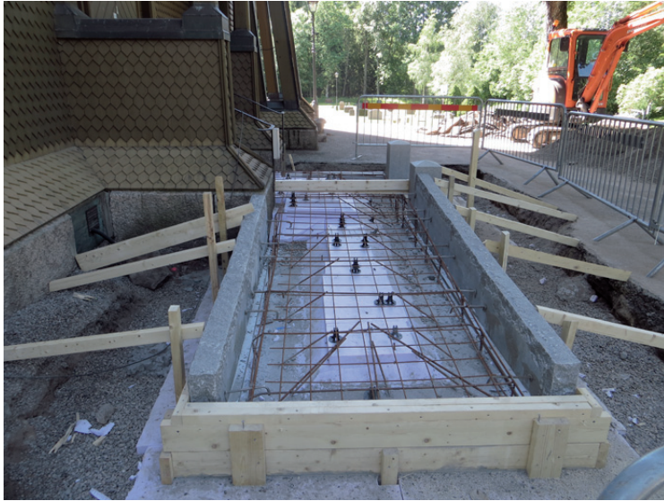
Pågående arbete. Kantstenarna är satta, betongfundamentet är klart för gjutning. Under gjutformen kan man se markskivorna.
