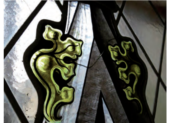
Exempel på sprucket glas som skall limmas.
