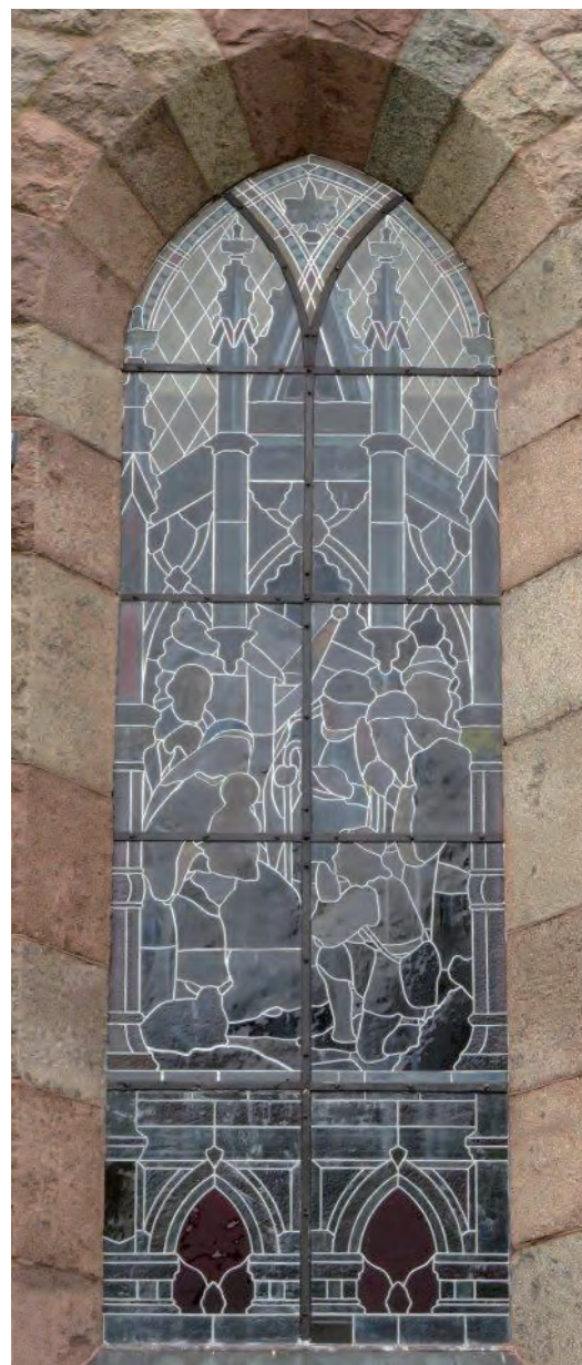
Mittfönstrets utsida efter byte av skadade glas, lagningar, rengöring och omspröjsning. Stag rostskyddsbehandlade och strukna med svart linoljefärg.
