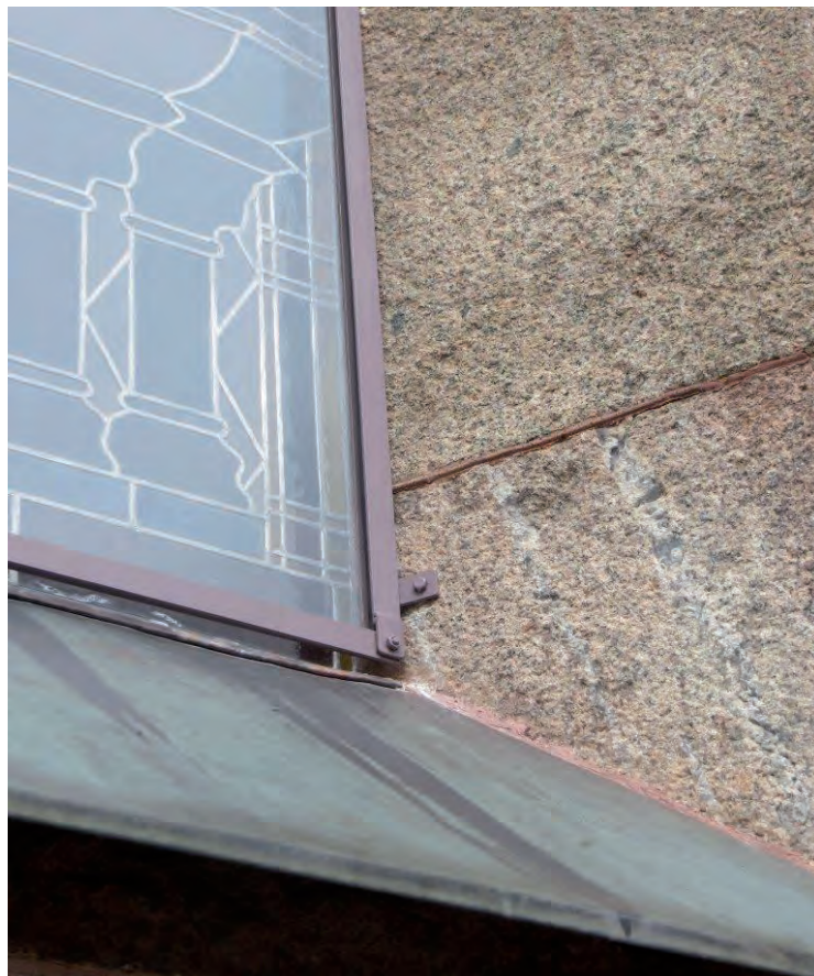
Detalj av nya ytterbågarna, vilka sattes med skruvförband i smygarna. Nertill har den en liten spalt för luftning.
