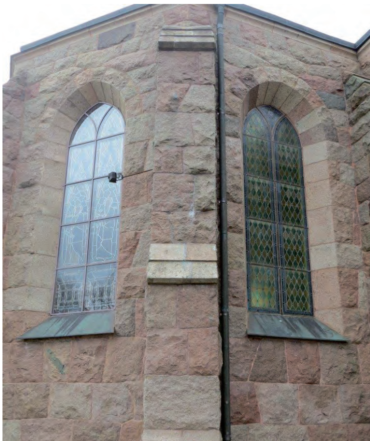
Yttre bångar med skyddsglas har monterats på de tre östligaste absidfönstren.
