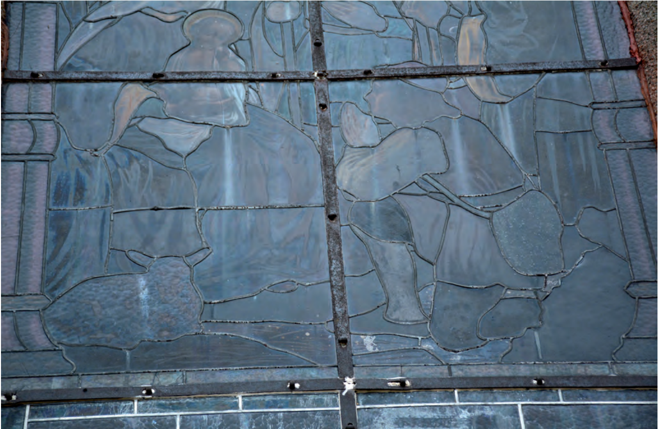
Parti av mittfönstret utifrån, där man ser hur oxiderade och bitvis deformerade eller spruckna blyspröjsarna är.
