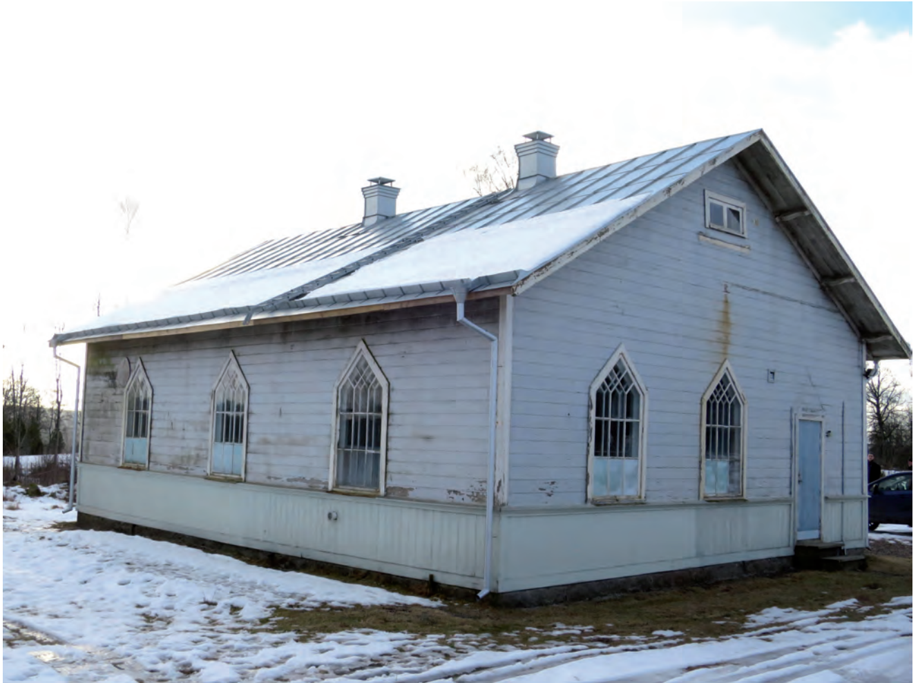
Från nordväst. Befintlig stege skall bytas mot en bättre anpassad.
