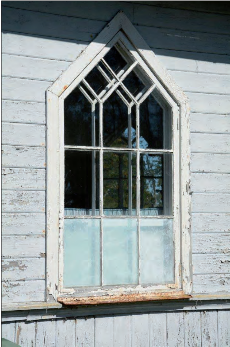
Fönster och fasspontpanel från ca 1900, idag målade med alkydoljefärg.
