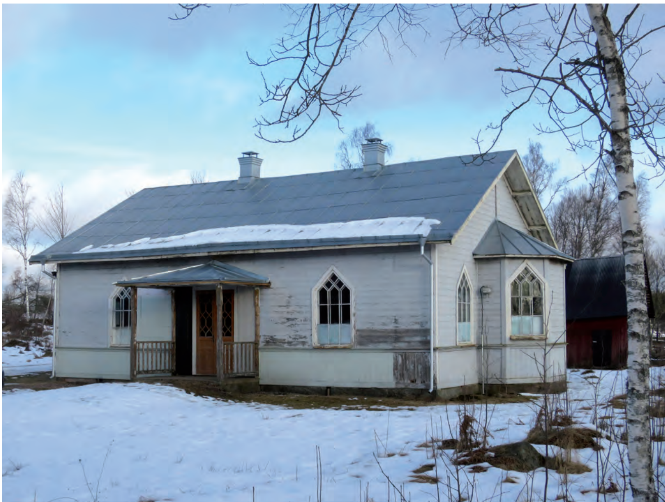
Taket efter avslutade arbeten, från sydost.
