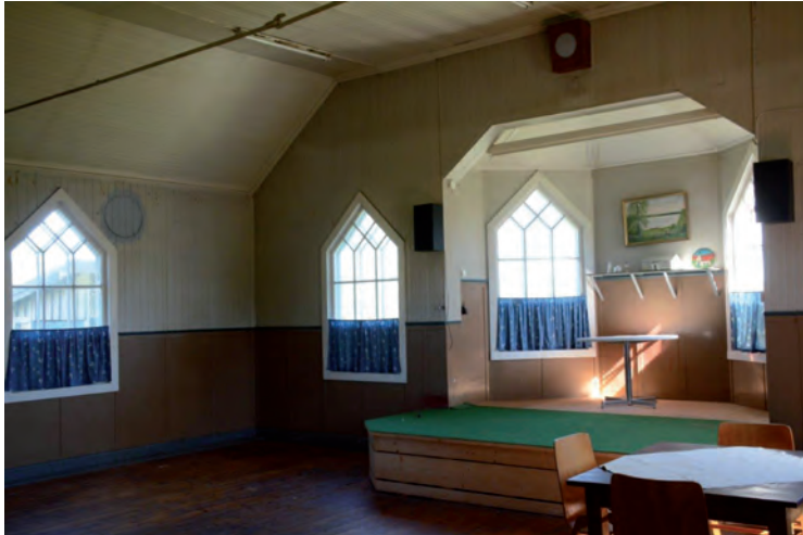
Stora salen. Bröstpanelen med träfiberskivor är från 1950-talet. Podiet återskapades på 2000-talet.
