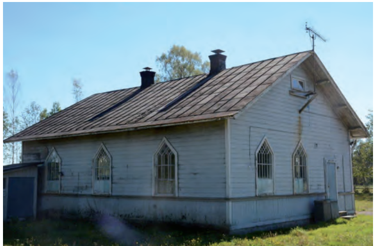
Exteriör från nordväst 2014. Notera köksingången med avtryck efter ett skärmtak.
