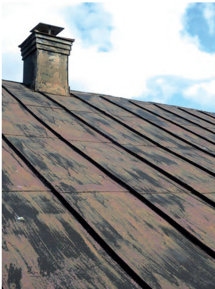
Skivtäckning med enkelfalsad förzinkad stålplåt från ca 1900, målad med stenkols tjära på järnmönja.
