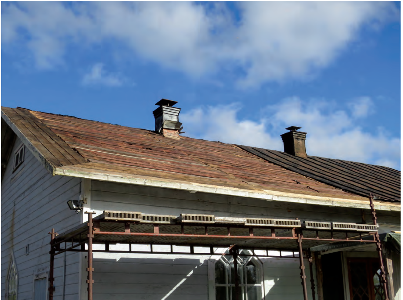
Plåttaket under rivning. Glespanel i överlag god kondition.
