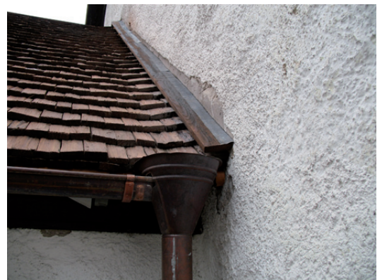
Detalj av anslutning vapenhusets tak mot västra muren.
