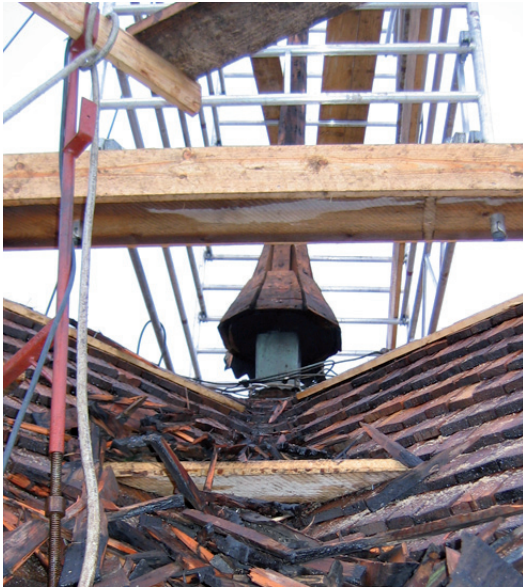
Omläggning av spirans spåntäckning.
