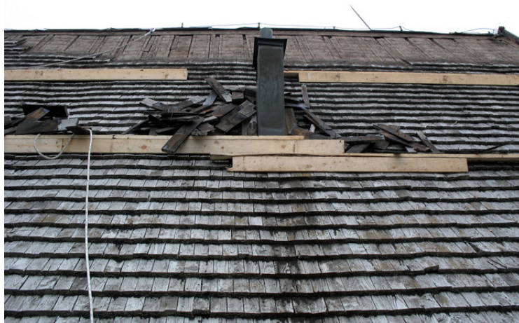
Det tidigare spåntaket rivs av. Takbotten består av äldre breda brädor med urspårning.
