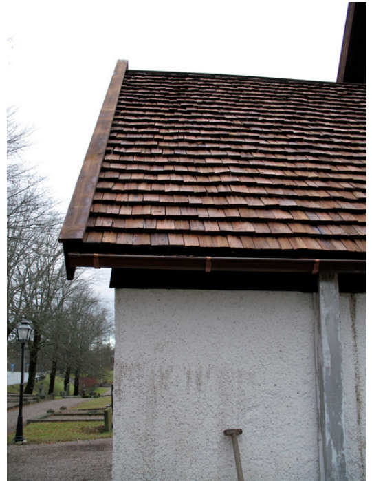
Detalj av vattbräda på vapenhuset.
