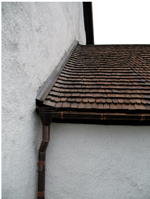
Detalj av anslutning sakristians tak mot korväggen.
