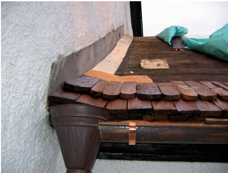
Till vänster: Detalj av uppbyggnad mot mur.
