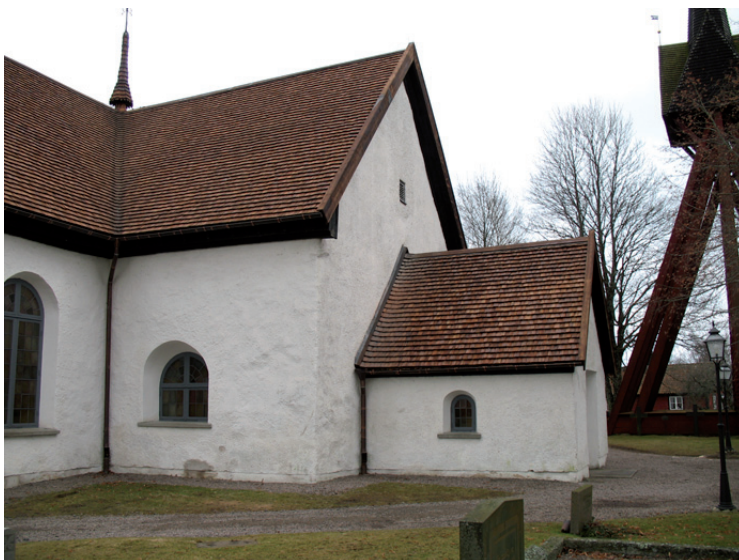
Kyrkan och vapenhuset från nordväst.
