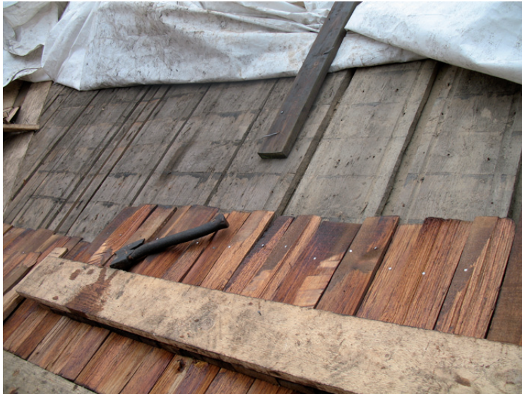
Takbotten utgjordes av breda brädor med spår för avrinning.
