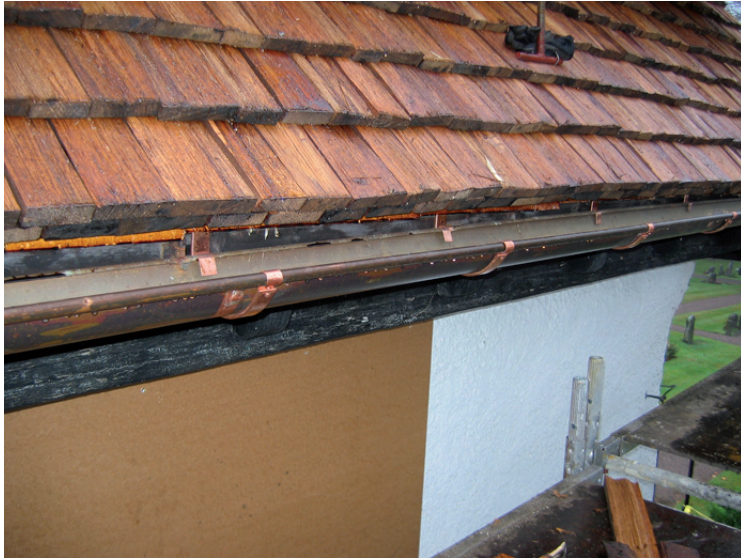
Pågående arbete, nävern kan anas under underlagsspånen. Vidare sattes nya beslag till hängrännan.
