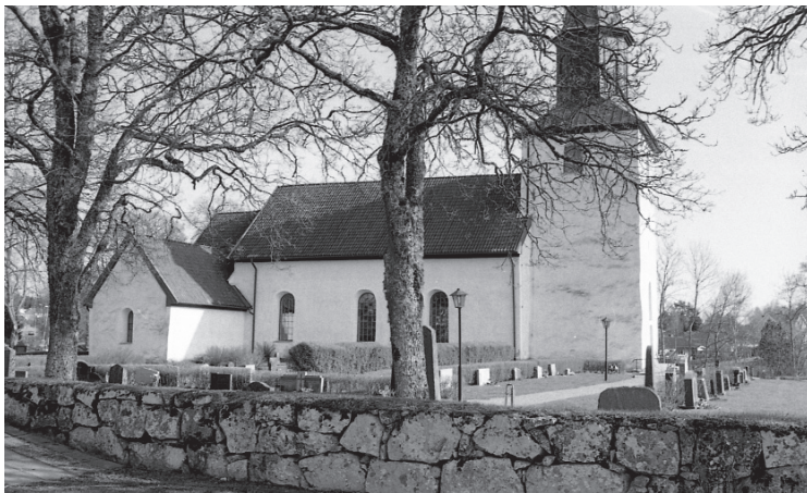
Översikt från norr, kyrkan före åtgärd.
