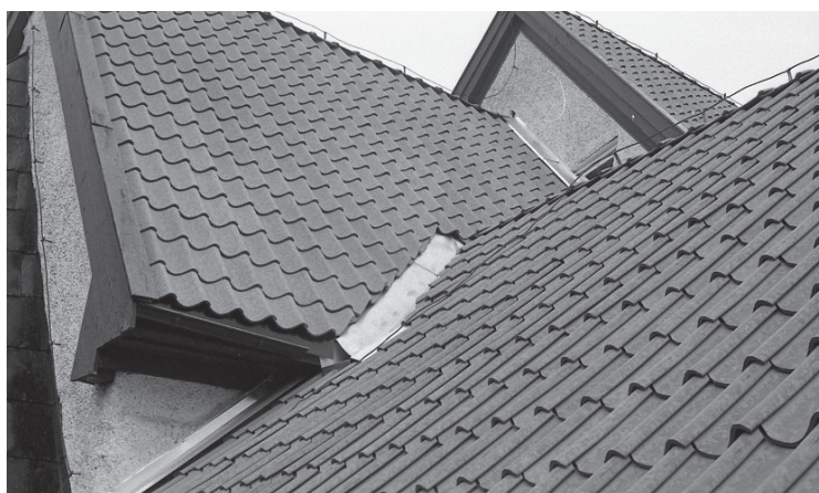
Sakristians takfall i förgrunden möter korets. Långhusets norra takfall i övre delen av bilden.
