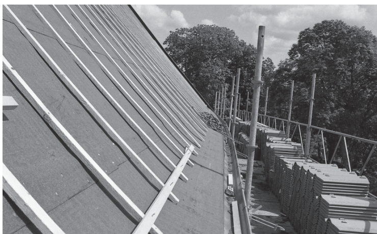
Ny läktning, långhusets södra takfall.
