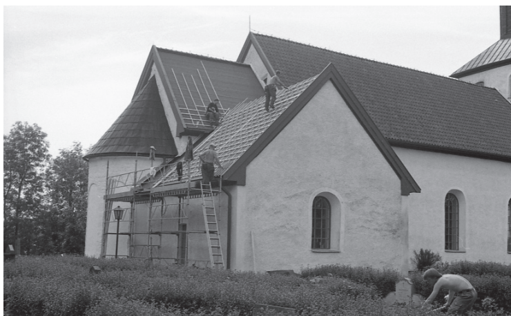
Arbetena har inletts, ny underpapp är lagd och läktning pågår på sakristian och kortaket. Vy från nordost.
