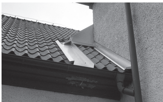
Detalj av plåtavtäckningen på sakristians takfall åt väster.
