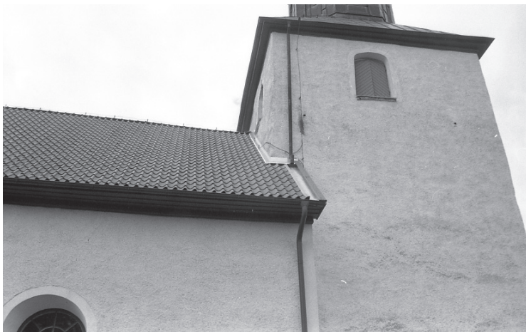
Långhusets takfall åt norr i mötet mot tornet.
