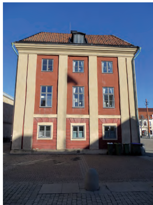
Sydfasaden inför arbetena.
