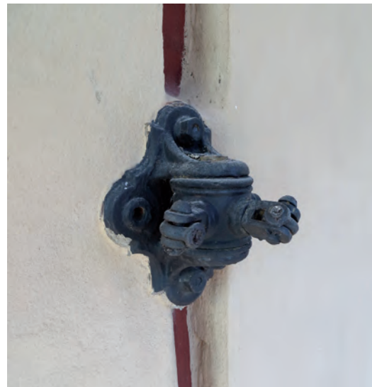
När spårvagnstrafiken på Östra Storgatan startade i början av 1900-talet användes vajerfästen för elförsörjningen, vilka sattes på flera av gatans fasader. Detta fäste togs inte bort vid arbetena.
