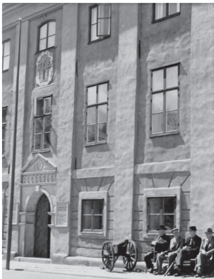
Parti av rådhusfasaden mot torget efter 1940-talets restaurering. Här har bottenvåningen erhållit rusticering. Foto Jönköpings läns museum.
