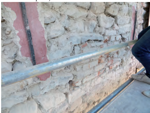
Ovan: Takfoten efter putsöversyn och avfärgning. Nedan: Ankarjärnens omgivande putsskikt sparades för att bibehålla putstjockleken.
