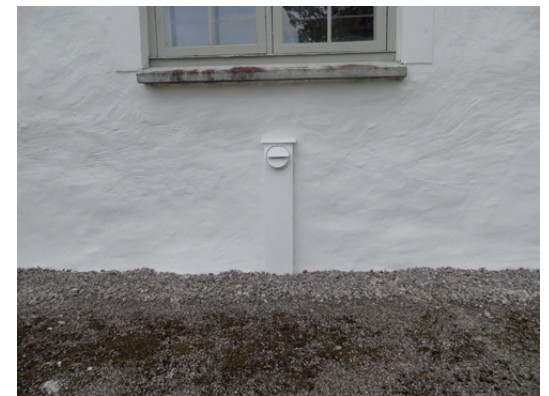
Ventilationsdonet under fönstret målades in mot fasaden.
