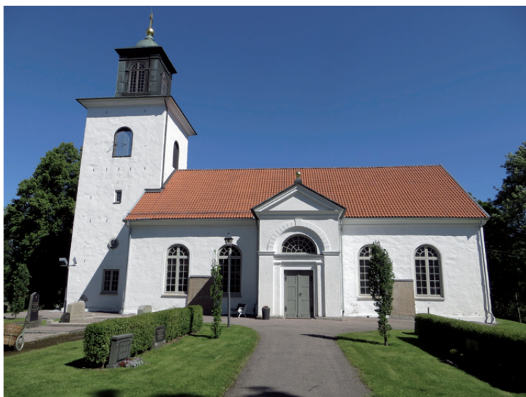
Sandhems kyrka från söder före åtgärd.
