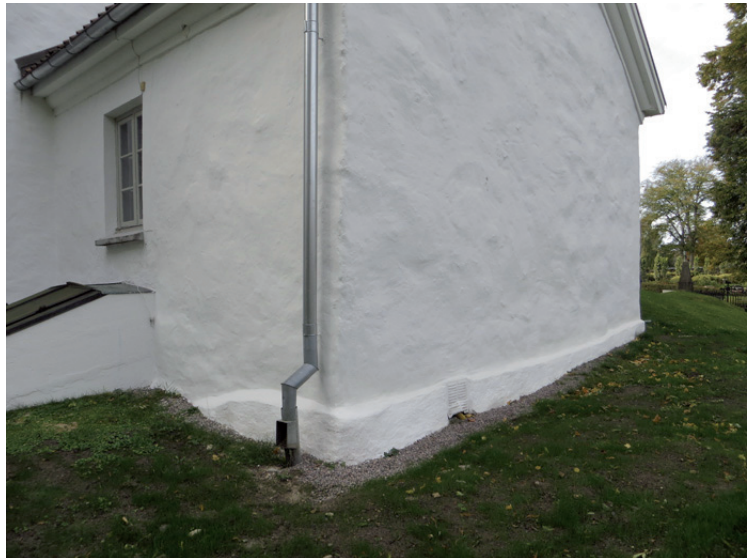
Sakristians norra och östra fasad.
