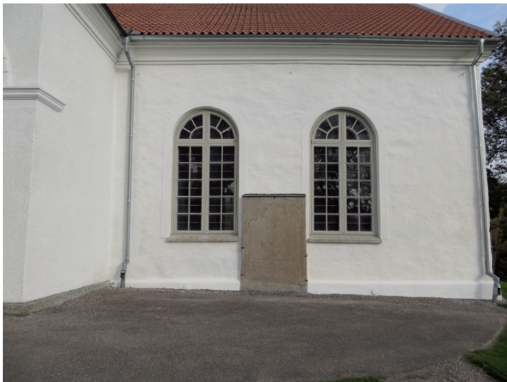
Den södra fasaden, öster om entrén.
