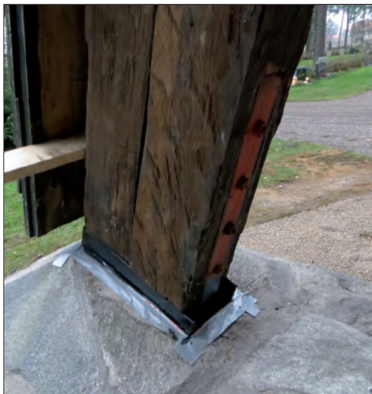
Befintliga infästningsjärn till snedträvorna rostskyddsbehandlades med blymönja och svart linoljealkydfärg (Isotrol Grund och Finish).
