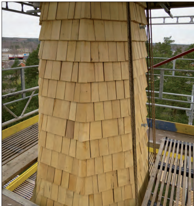
Takspiran fick en något mindre distinkt form med mjukare hörn när man övergick till växelvis överlappning av spånen i över hörnnocken.
