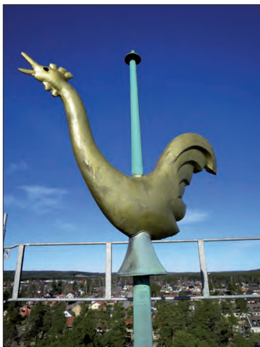
De fint arbetade krönprydnaderna från J A Jönssons Eftr. i Jönköping hade sekundärt målats med bronsfärg, se ovan. Nu återställdes förgyllningen.
