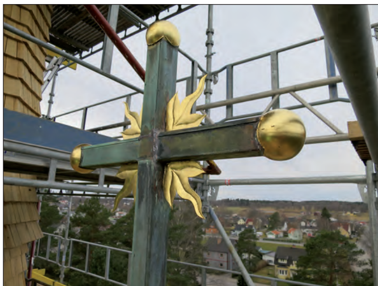
Eldkorset på klockhusets tak lagades med lödning samt förgylldes om med bladguld.
