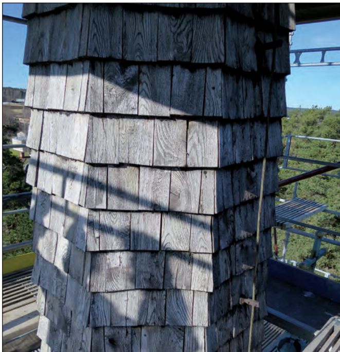
Takspiran fick en något mindre distinkt form med mjukare hörn när man övergick till växelvis överlappning av spånen i över hörnnocken.
