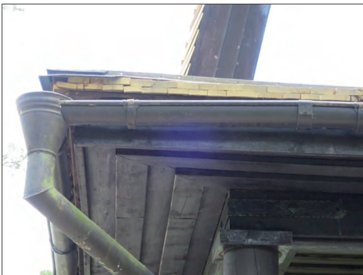
Målningen av den befintliga hänggrännen och stuprören kvarstår och planeras utföras 2016.
