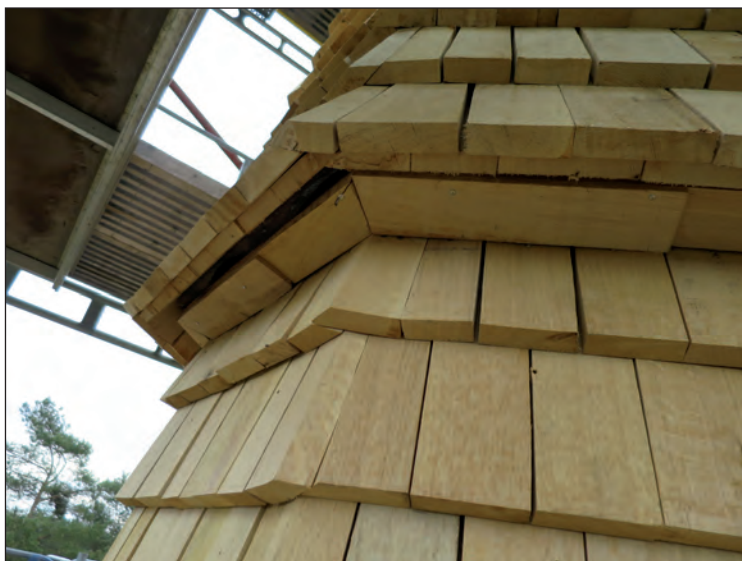
Takfoten under spirans utsvängda kjol hade täckts med dubbla ekspån, ett utförande som bibehölls vid omtäckningen.
