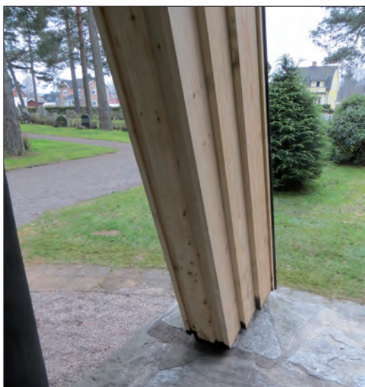
Panelen på samtliga strävpelare i paviljongen byttes ut mot likadan, d v s cirkelsågade furubrädor av hög kvalitet.
