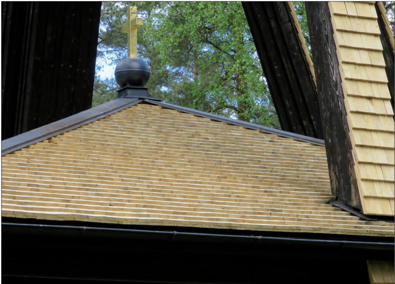
Paviljontaket med ny spåntäckning. Krönprydnadens kors förgylldes medan klotet målades med grafitsvart linoljefärg. Målning avnockbeslagen kvarstår och utförs i samband med tjärningen 2016.
