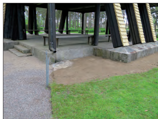
Funkiarabatterna och cemenplattorna kring klockstapeln, båda sentida tillägg, togs bort. Ändringen innebar en återgång till markytornas ursprungliga behandling. På bilden är gräset nysått och stenfrisen ännu inte utförd.
