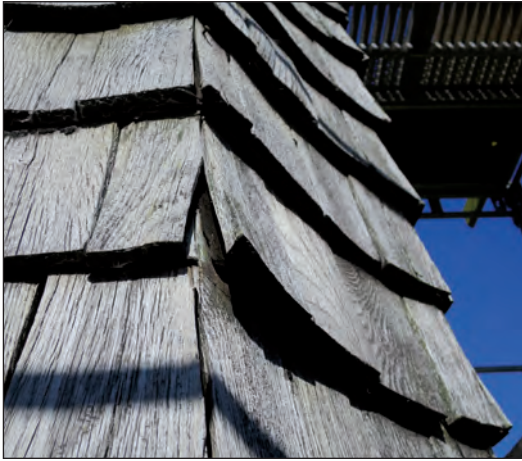
Spiran har distinkt markerade hörn i och med att de tunna spånen slagit sig. Hörnskarven har tätats med inskott av förhydringspapp.
