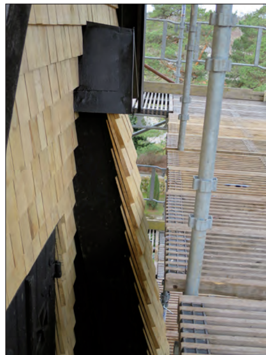
Befintliga tak i varmförzinkad plåt vid snedsträvornas möte med klockhusfasaden målades med järnmönja och grafit svart linoljefärg.
