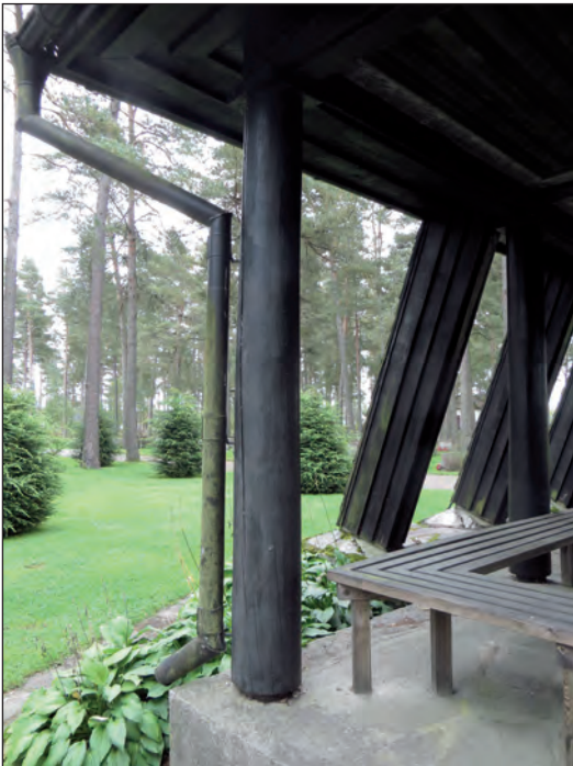
Ceremonirummet har svarvade träkolonner vars yta är bearbetad med bandkniv. Någon gång på 1990-talet hade de målats med oljelasyr istället för trätjära.
