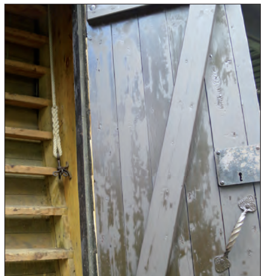
Trapphusets dörr målades med tjärbrun linoljefärg. Lejdaren till trappan återställdes med tågvirke av hampa.
