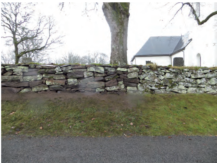
Muren i väster, från väster.
