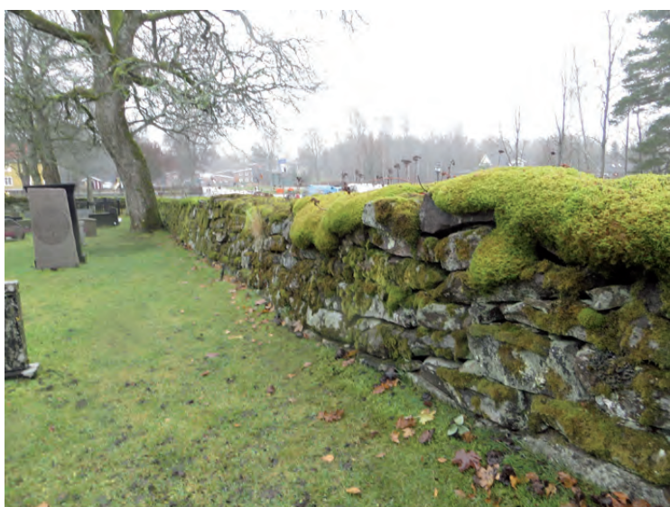
Till vänster: Södra muren, öster om porten, före åtgärd.
