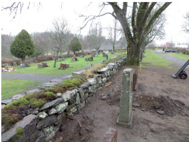
Omläggningen av muren i väster är klar. För att komma tillrätta med att det samlades vatten vid muren, påfördes också jord vid de anslutande gravarna. Foto från november 2015.
