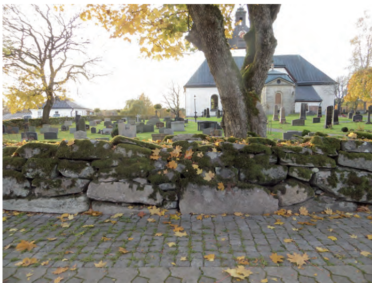
Byarums kyrka från öster. Kyrkogårdsmuren mot vägen lades om i ett parti söder om stigluckan.
