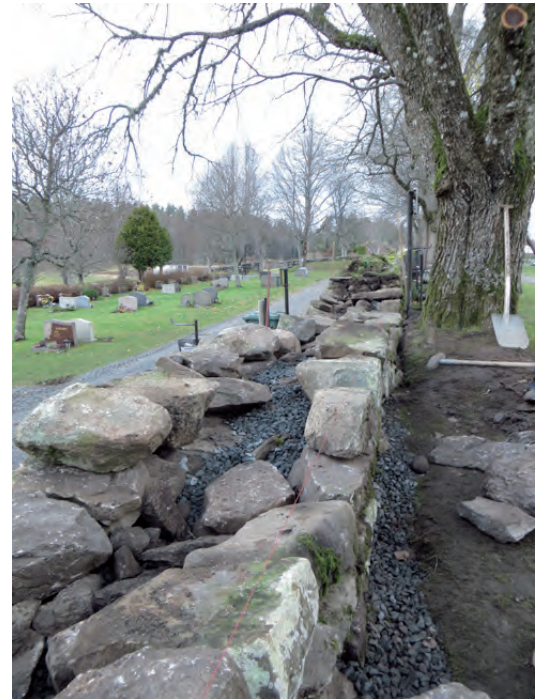
Pågående arbeten på muren i väster.
