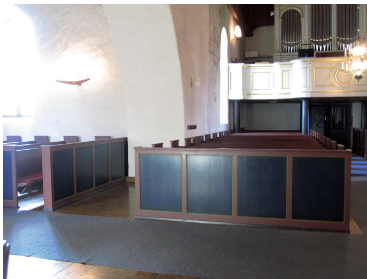
Bänkarna i valvbågen togs bort och utrymmet nyttjas som rullstolsplatser.
