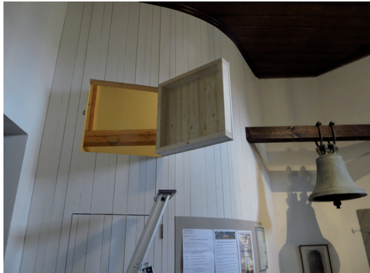
Genom den övre luckan kan man se bjälken för klockupphängningen.
