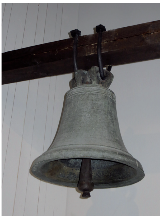
Byglarna trädde igenom klockans upphängningsöglor
