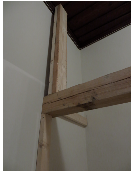
Bjälkens infästning i den andra änden, bjälken fästes och kilades med plankor mot förrådet och taket.
