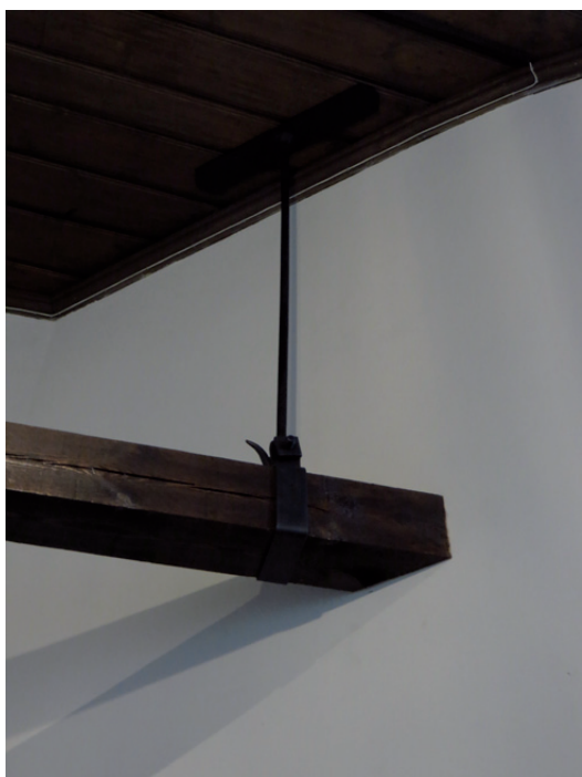
Bjälken fästes med ett järnstag i taket.
