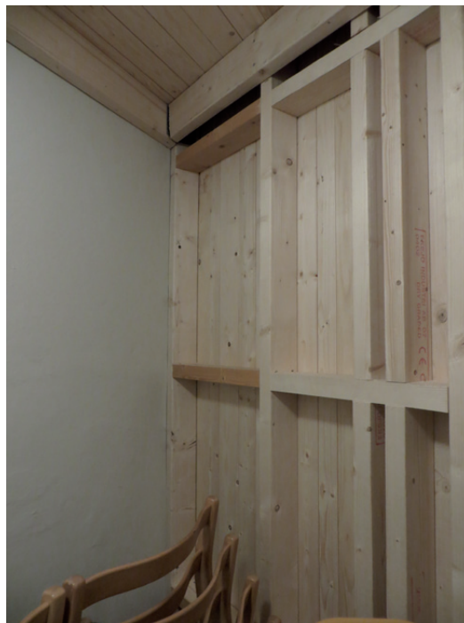
Förrådets regelkonstruktion.
