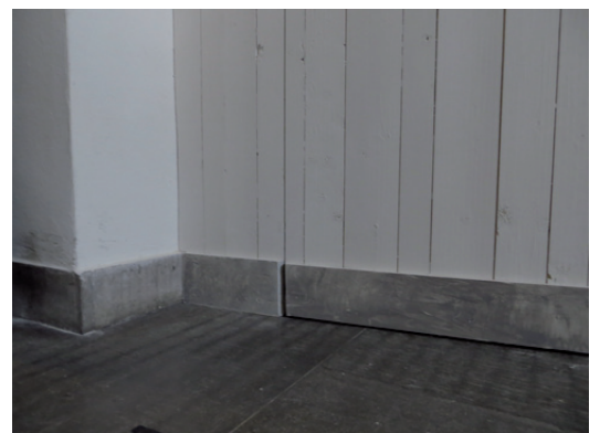
Förrådets träsockel målades mot kalkstenssockeln.
