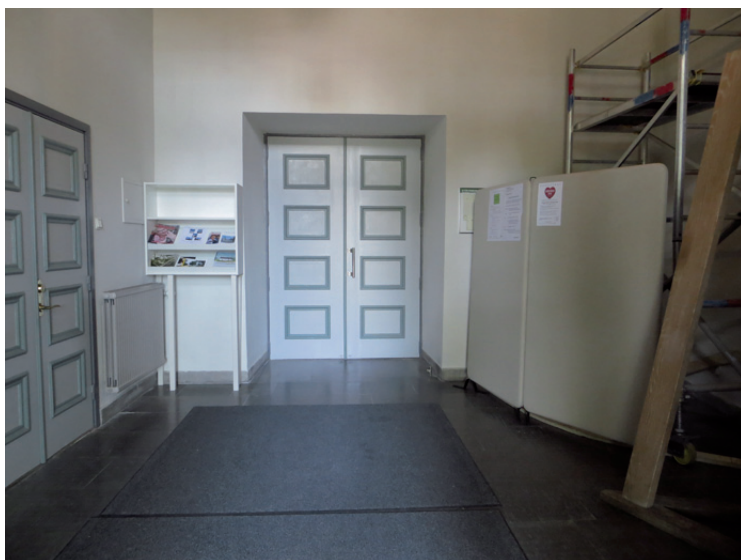
Vapenhuset före åtgärd. De skärmar som användes för att skärma av det tidigare provisoriska stolsförrådet är uppställda.
