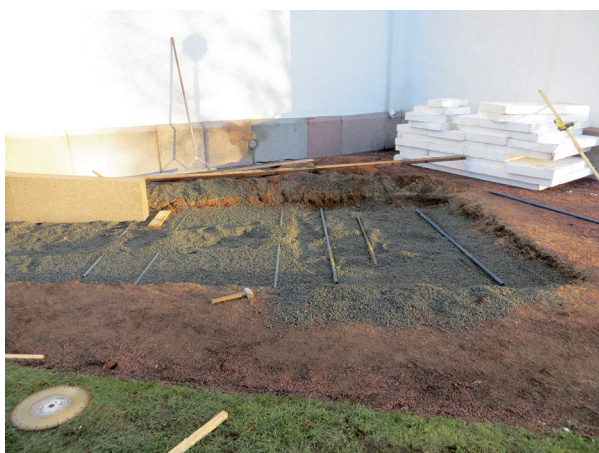
Grundläggningen av rampen.
