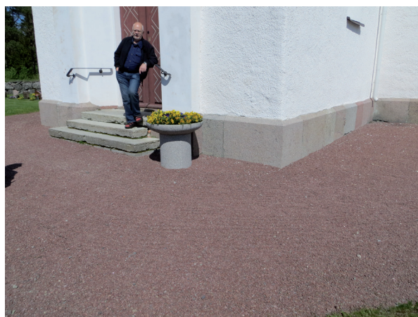
Den utvändiga trappan inför arbetena. Ulf Berndtsson, ordförande i pastoratets fastighetsutskott.
