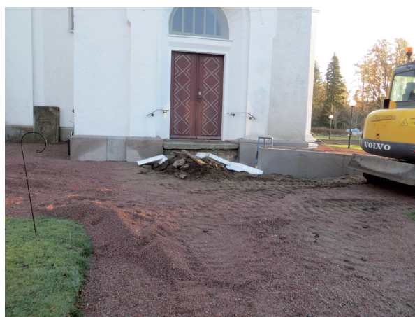
Den gamla trappan har rivits.
