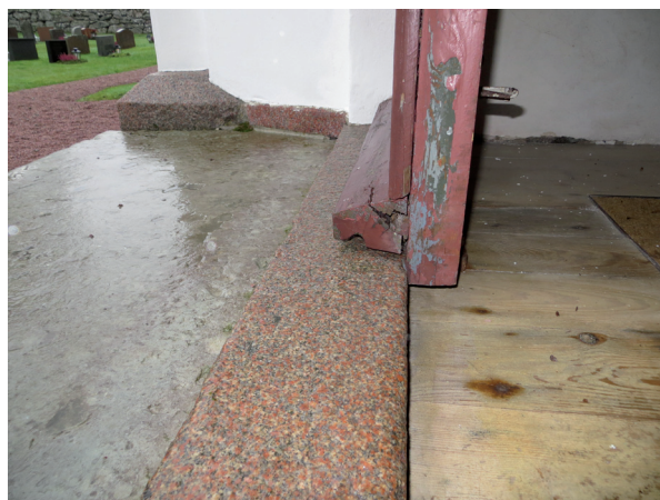
Den yttre tröskeln inför arbetena.
