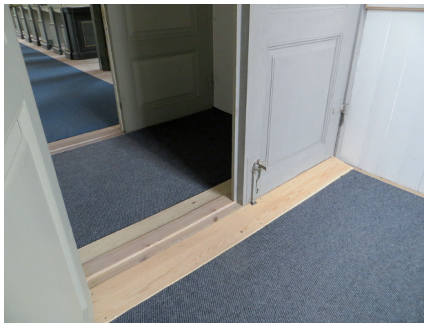
Den något höjda golvnivån i passagen vid slutbesiktningen.
