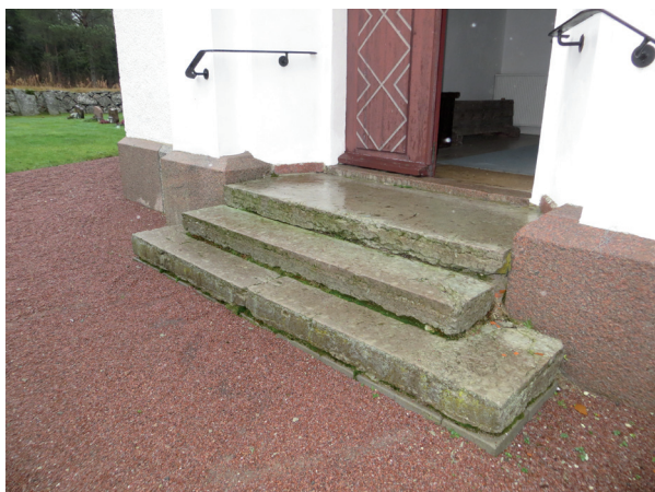
Den utvändiga trappan inför arbetena.
