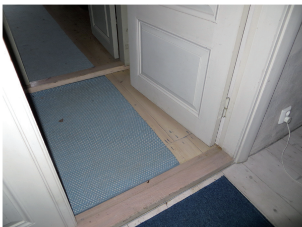
Den lilla passagen mellan vapenhuset och kyrkorummet inför arbetena.
