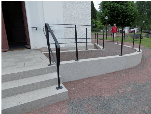
Den utvändiga trappan och rampen vid slutbesiktningen.
