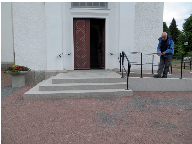
Den utvändiga trappan vid slutbesiktningen.
