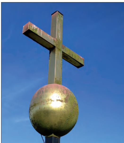
Tornets kröndekor var i stort behov av omförgyllning med kraftigt eroderad förgyllning och mosspåväxt.
