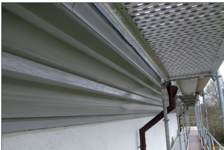
Långskeppets taklist efter ommålning och kulörbyte.
