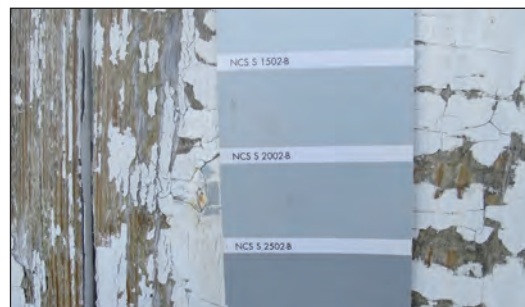
Färgspår påträffades på lanterninfasaden som visade att denna tidigare haft grå pilastrar, entablement, taklister och omfattningar. Kulören var neutralt grå och låg ganska nära NCS S-2502-B.
