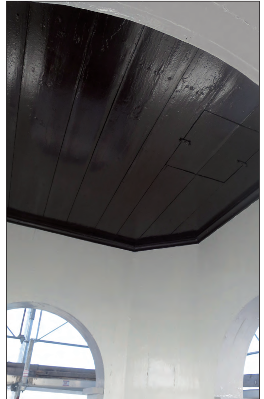
Brädtaket målades om i samma brunröda kulör som förut, vilken bröts fram på plats. Samma kulör användes på ljudluckorna.
