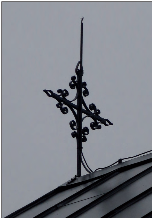
Smideskorset på kortakets krön, lagades vid infästningen vid en lokal smidesverkstad och målades med blymönja och svart linoljefärg.
