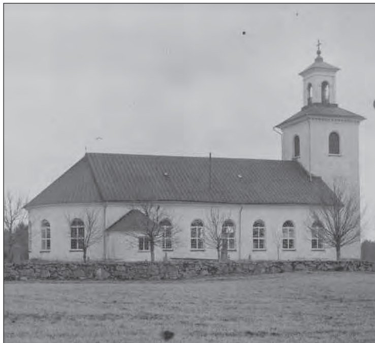
Åkers kyrka 1922. Enligt en tidningsnotis renoverades kyrkan 1911. Möjligen var det vid detta tillfälle som färgsättningen på fasaderna ändrades till helvitt, enligt tidens nationalromantik. Även fönstren kan vid denna tidpunkt ha målats vita. Foto: Anders Roland ATA.
