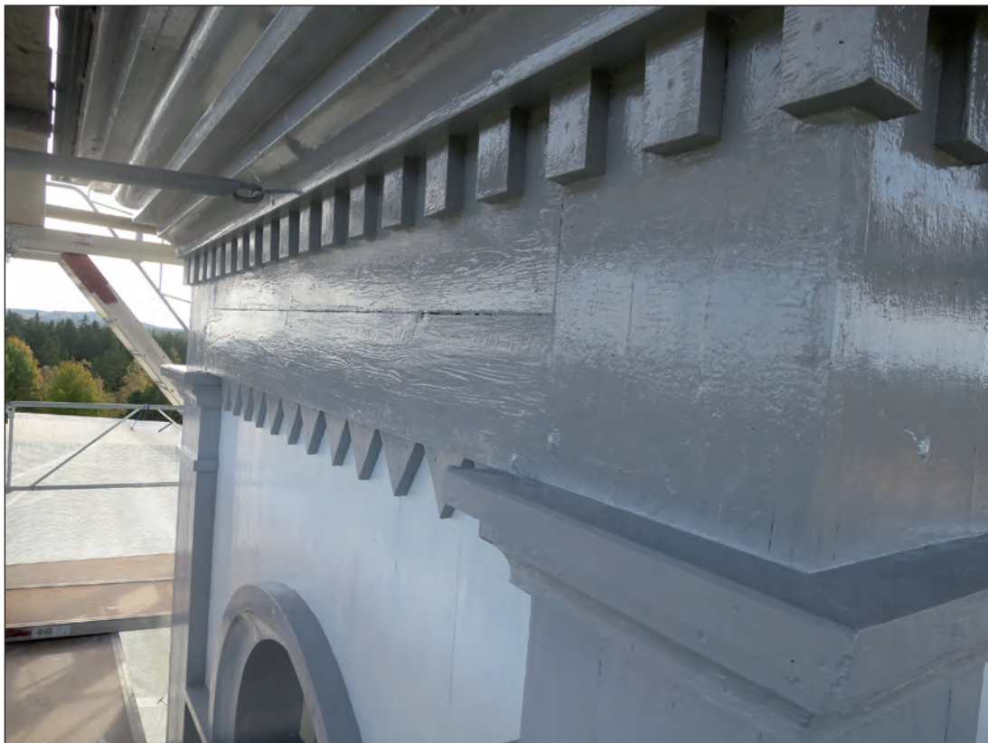
Den grå kulören till lanterninens arkitekturelement bröts fram av målaren på plats och ligger mycket nära den neutrala grå originalkulören.
