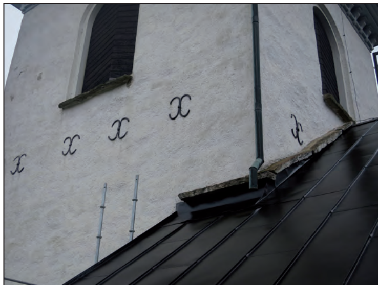
Ankarsluten i tornfasaden målades med blymönja och svart linoljefärg. Ljudluckorna målades i förutvarande brunröd kulör.
