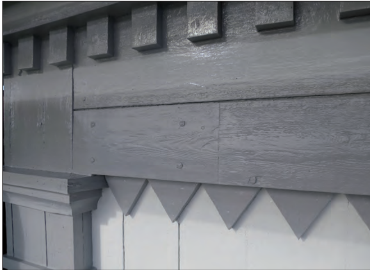
Väl utförd lagning i entablementet åt söder.
