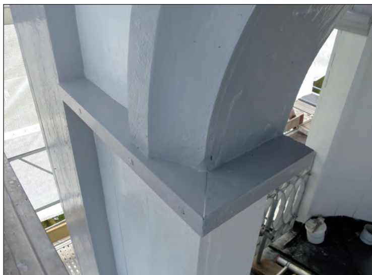
Sprucken list ersattes på lanterninens östra sida. Den nya i handhyvlat furuvirke sattes fast med ny smidd spik.
