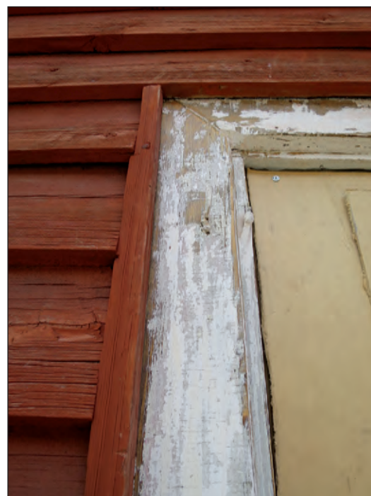
Vid skrapningen på såväl fönsterbågar som foder framkom en äldre ljusgrå kulör.
