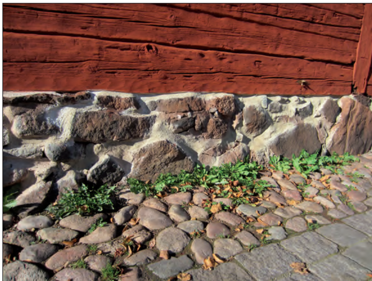
Vid omfogningen dämpades fogbrukets ljusgrå nyans något med grön umbra. Rötskador i väggtimret närmast grunden lagades i med en träkil med slätbilad yta. Lagningen utfördes med vältorkat virke och hög noggrannhet i skarvning för att inte riskera att sprickor uppstår i framtiden.
