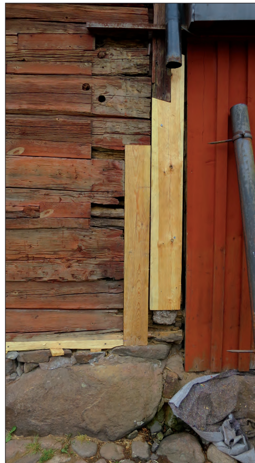
Lagningen av den nordöstra hörnstolpen och fixeringen av väggtimret.
