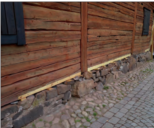
Mellan den ytliga ilagningen av syllen och grunden sattes träkilar för att inte riskera att lagningarna skulle pressas ut av väggens egentyngh.
