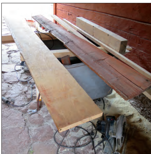
Ersättningsbrädan fasades i överkant likt övriga panelbrädor.
