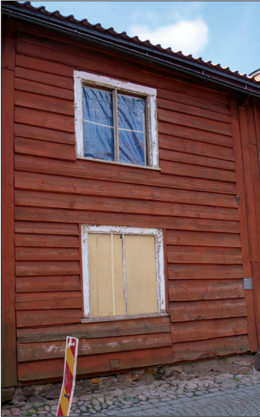
Ladugårdens gatufasad är klädd med en ålderdomlig lig-gande panel på förvandring. De ramsågade panelbrädorna har handhyvlat utsida och är spikade med smidd spik.
