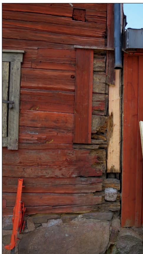
Ett äldre läckage från ett stuprör har orsakat kraftiga rötskador i anslutning till den nordöstra hörnstolpen. Provisoriska lagningar hade gjorts med cement och en brädinklädnad som i viss mån höll väggtimret på plats. Rötskadan i de nedersta knutarna och stolpen har orsakat en sättning i den norra gaveln.
