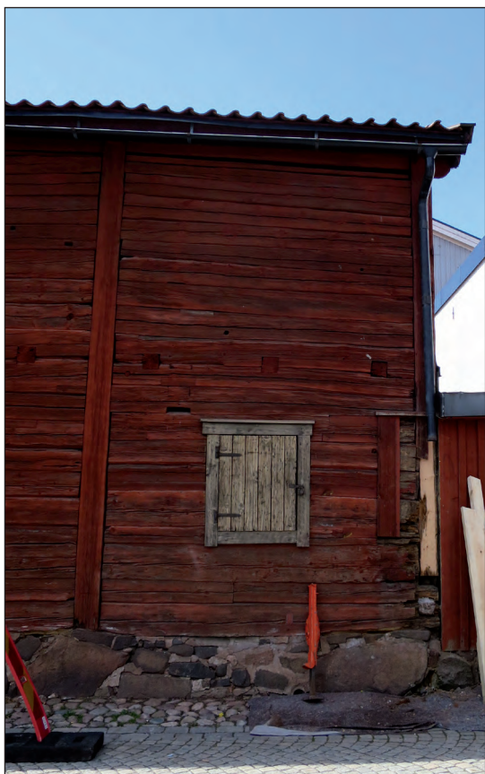
Ett äldre läckage från ett stuprör har orsakat kraftiga rötskador i anslutning till den nordöstra hörnstolpen. Provisoriska lagningar hade gjorts med cement och en brädinklädnad som i viss mån höll väggtimret på plats. Rötskadan i de nedersta knutarna och stolpen har orsakat en sättning i den norra gaveln.
