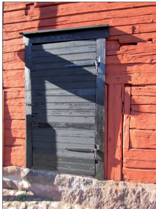
Boddörren efter ny infästning, renovering och återmontering på rätt håll.
