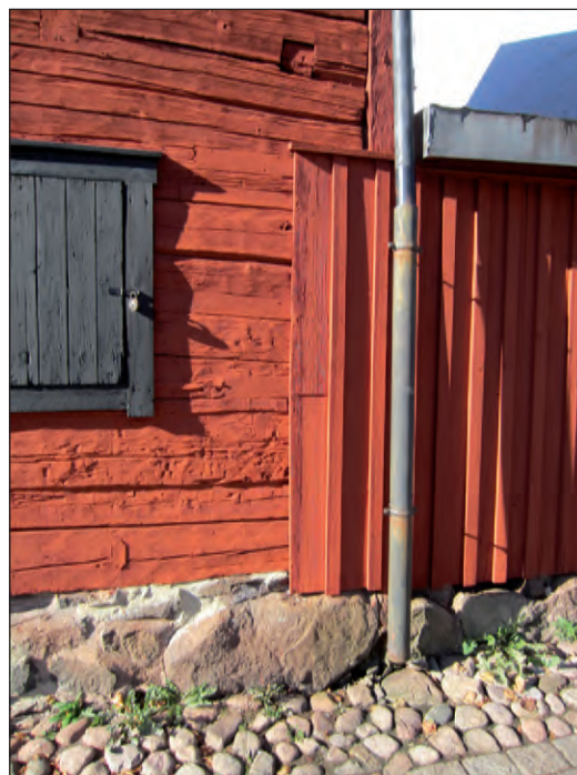
Lagningen av nordöstra hörnstolpen och fixeringen av väggtimret doldes med brädfodring.
