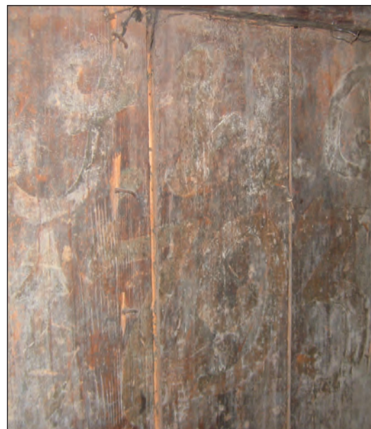
På insidan av ena porten till ladugården finns inskriptionen "SHG 1793". Möjligen avser detta årtal ladugårdens byggnadsår.
