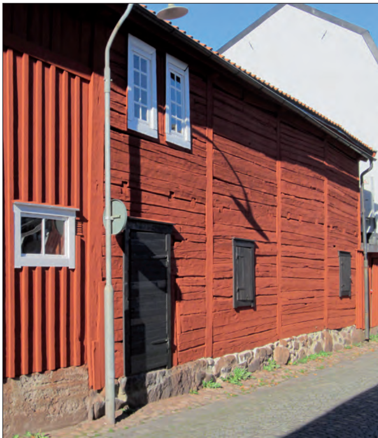
Bodlängan efter fönsterrenovering och ommålning. Befintliga hängrännor justerades enbart. Nya rännor i en större dimension och med fler stuprör kommer att behövas för att skydda fasaden, men fanns inte med i 2015-års arbeten.
