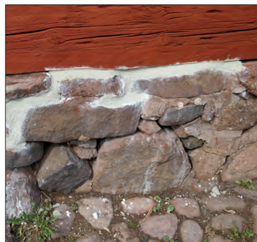
För att erhålla inte alltför ljusa fogar pigmenterades fogbruket med grön umbra. Här har en provyta gjorts.
