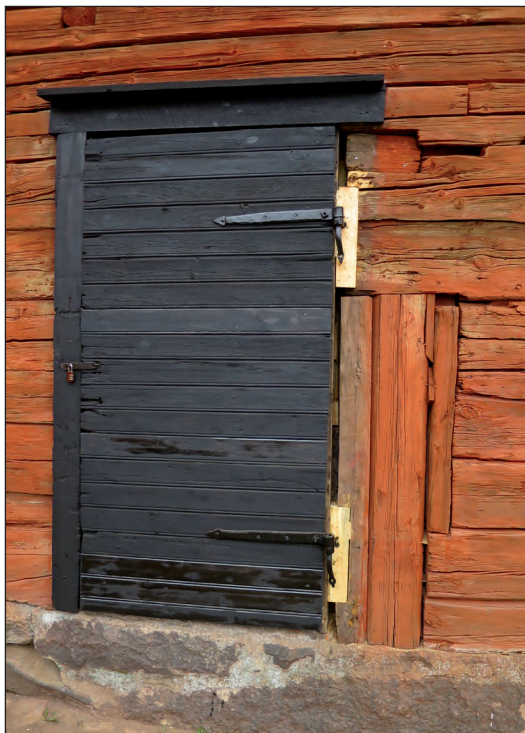
Dörren mot Arendt Byggmästares gata erhöjll nya infästningspunkter. Efter byte av ett antal panelbrädor och målning sattes dörren åter tillbaka vänd åt rätt håll.
