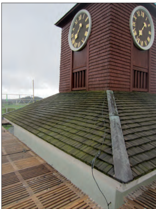
Torntaket har liksom lanterninfasaden kvar en täckning av stavspån, vilket de haft allt sedan byggtiden år 1809.
