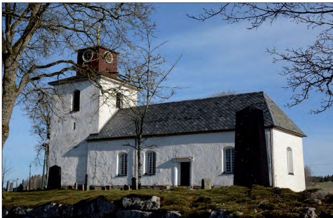
Skepperstads kyrka utgör i långhusets västra del och tornets bottenvåning delar av en romansk asbidskyrka med västtorn. Dagens torn byggdes 1809 medan långskeppets östra del byggdes till 1833-35.
