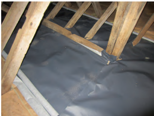
Skarvning av duken i vindens längdriktning gjordes med väl tilltagen överlappning.
