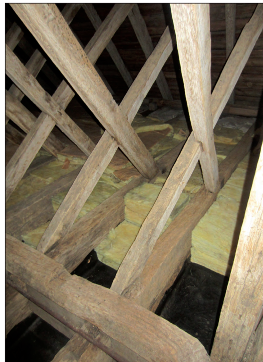
På de ställen där all isolering togs bort dammsögs ovan- sidan av innertaket rent från damm och täcktes därefter med förhrydringspapp.
